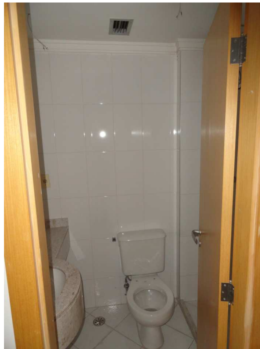
VISTA DO BANHEIRO FLAT Nº 2.112 (ATUAL Nº 2.106).
