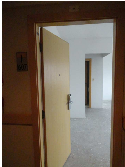
VISTA DA PORTA DO FLAT N° 1.611 (ATUAL N° 1.607).
