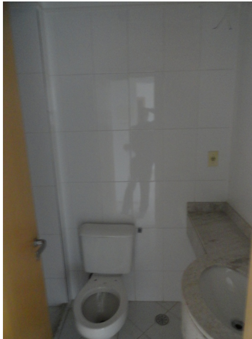
VISTA DO BANHEIRO FLAT Nº 1.611 (ATUAL Nº 1.607).
