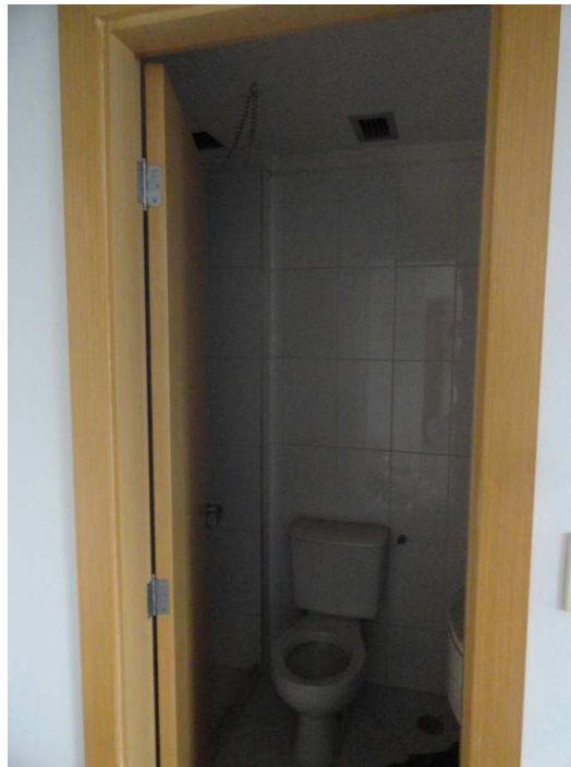
VISTA DO BANHEIRO DO FLAT Nº 605 (ATUAL Nº 601).
