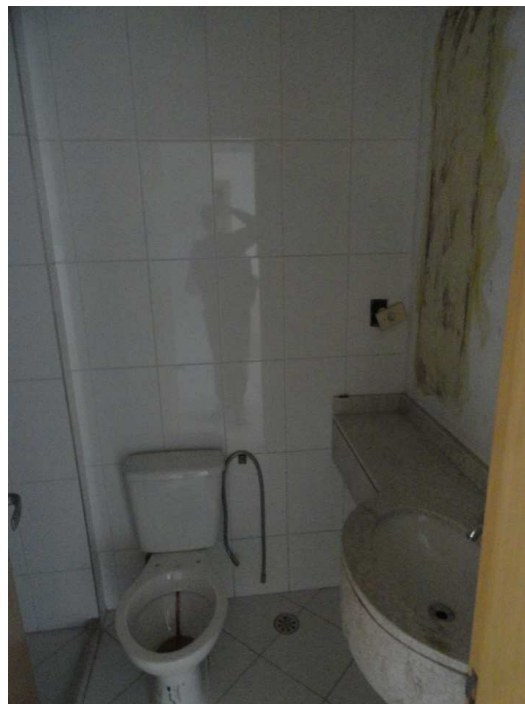
VISTA DO BANHEIRO DO FLAT Nº 1.411 (ATUAL Nº 1.407).
