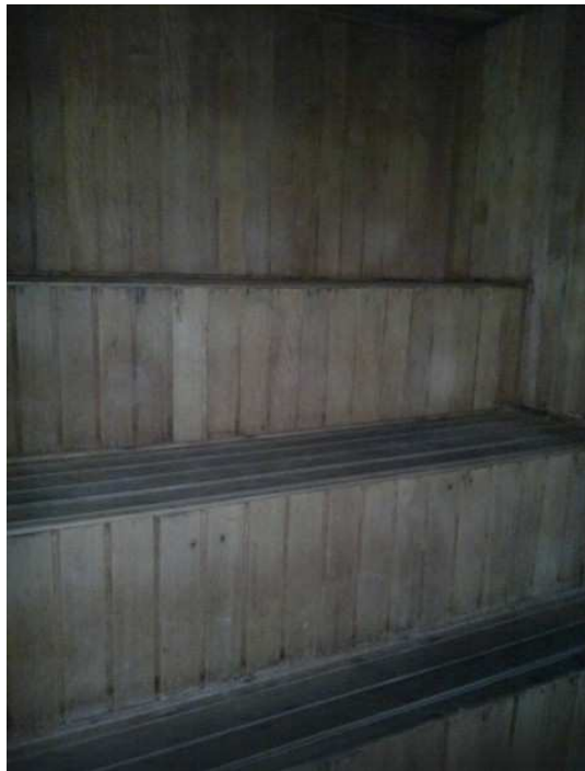
VISTA DA SAUNA SECA.
