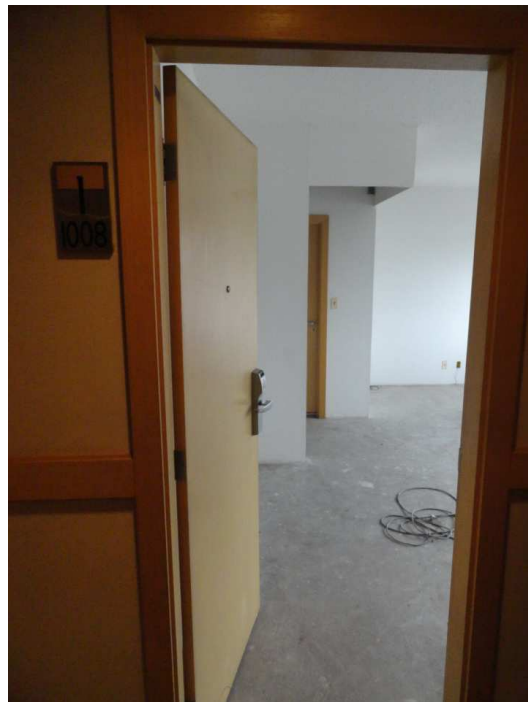
VISTA DA PORTA DO FLAT N° 1.010 (ATUAL N° 1.008).
