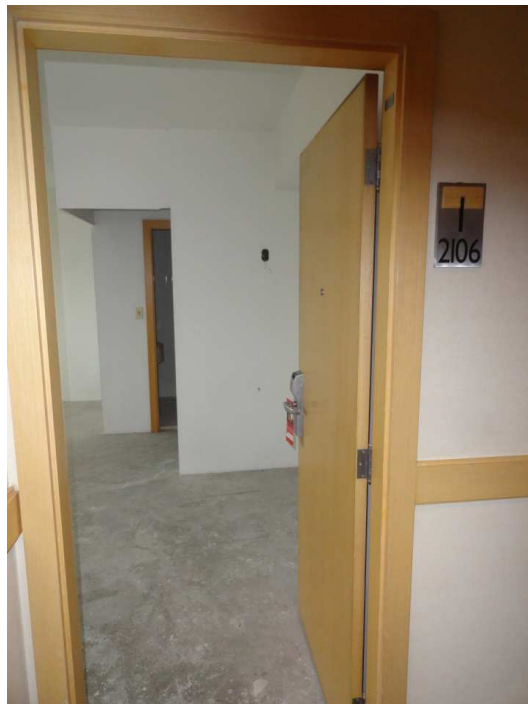
VISTA DA PORTA DO FLAT N° 2.112 (ATUAL N° 2.106).
