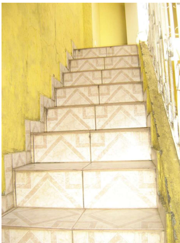
vista da escada que da acesso ao piso superior da edícula
