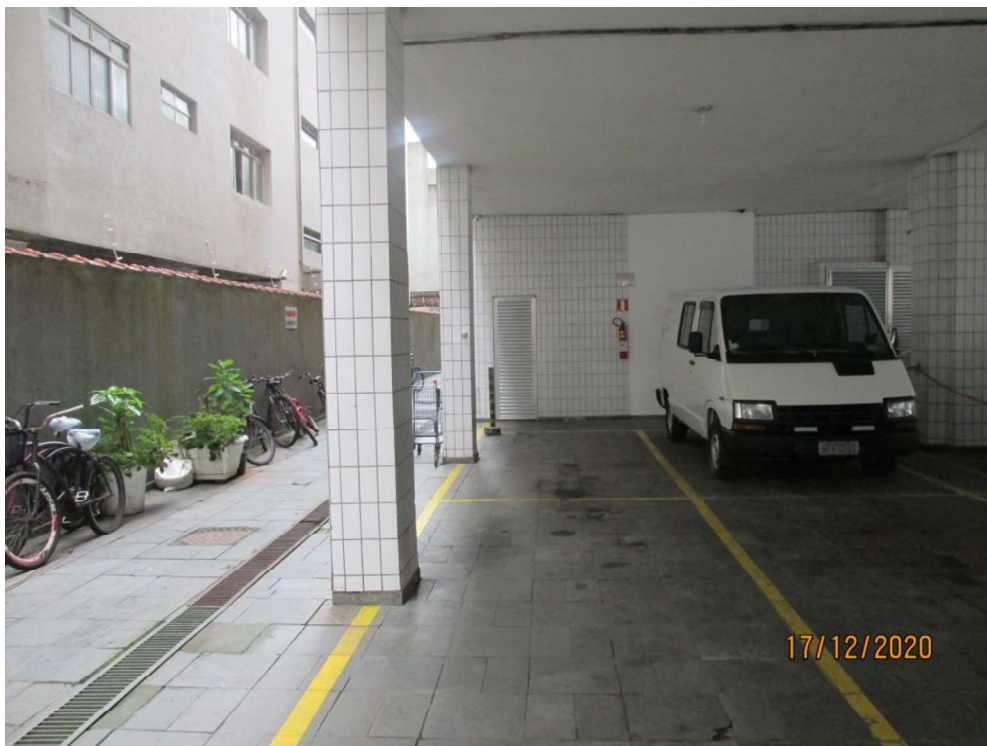
Foto 6 - Vagas de garagem no andar térreo
