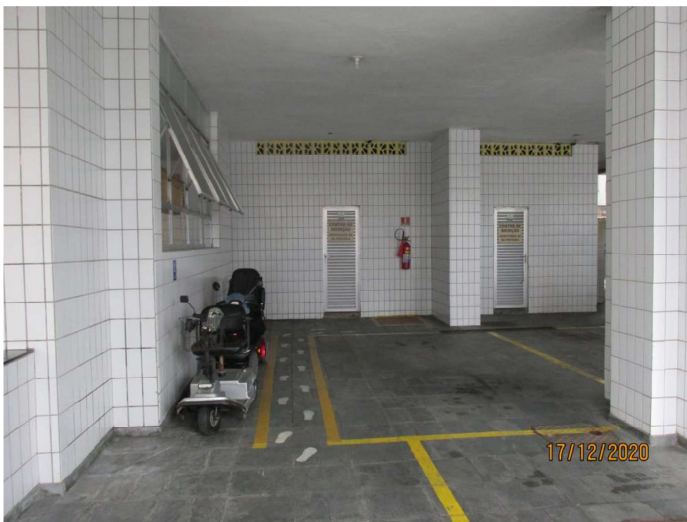
Foto 4 - Vagas de garagem no andar térreo
