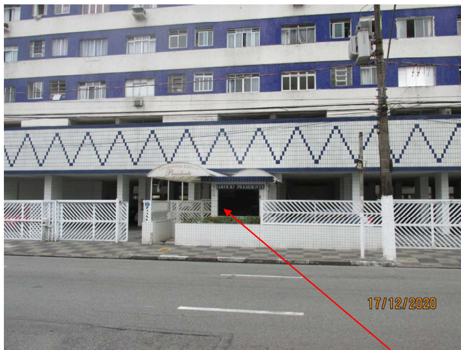
Foto 2 - Detalhe da entrada do edifício - portaria
