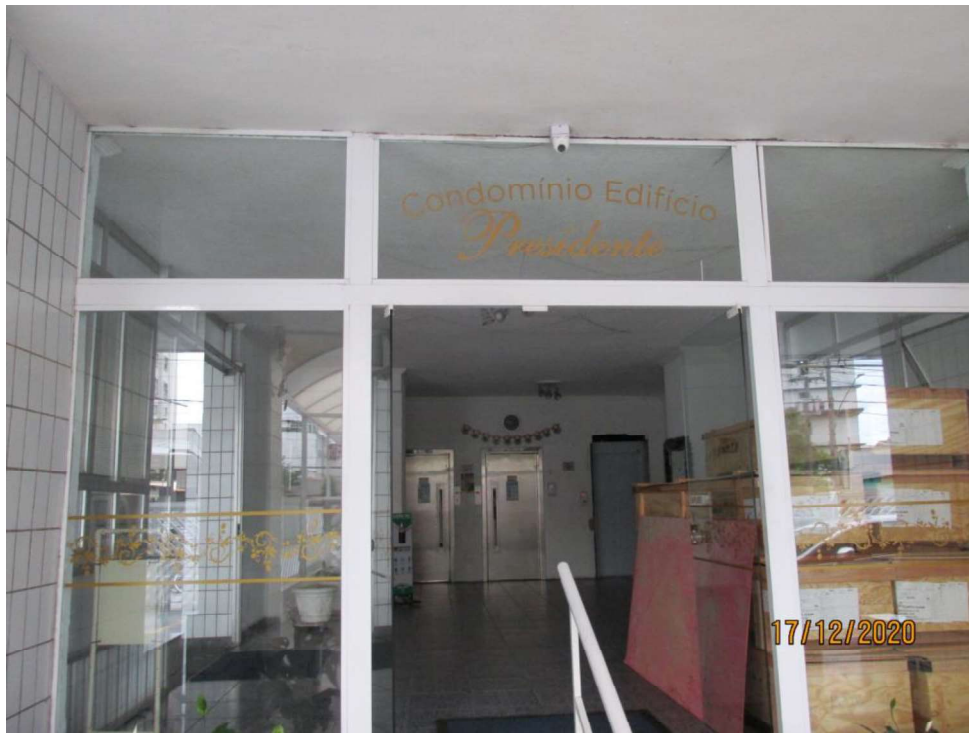
Foto 3 - Entrada para o hall social e elevadores
