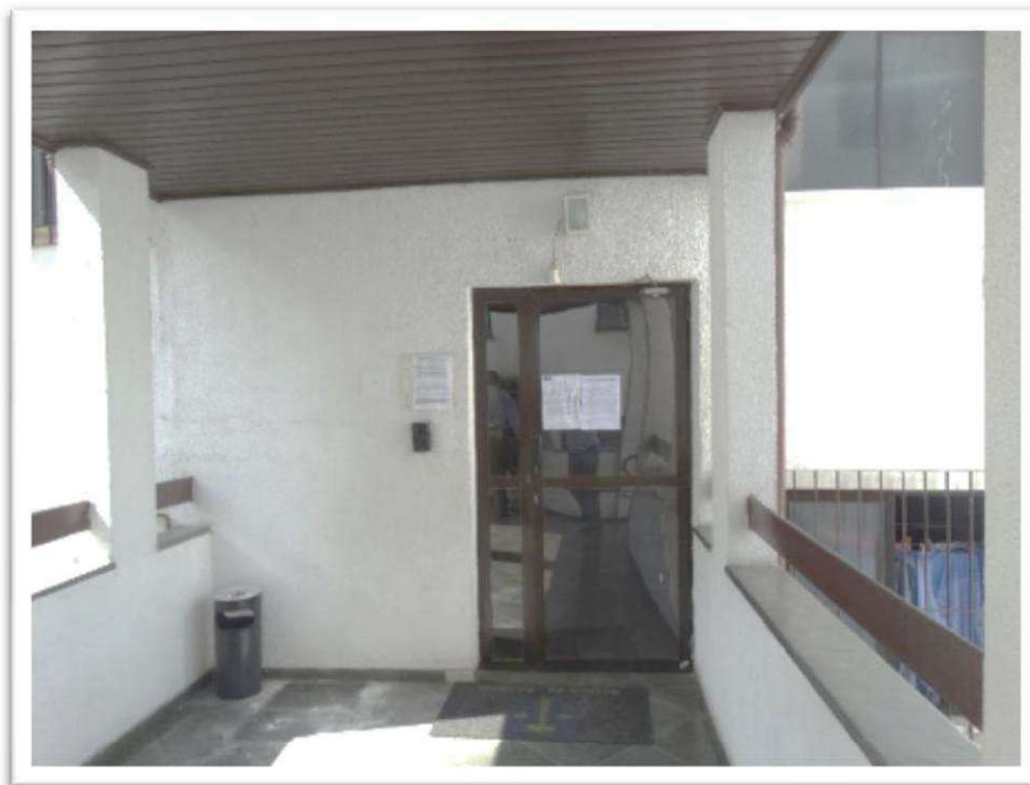
Foto nº 10 - Vista da porta de entrada do Edifício Parpan, cujo apartamento de nº 13 é objeto da presente vistoria.
