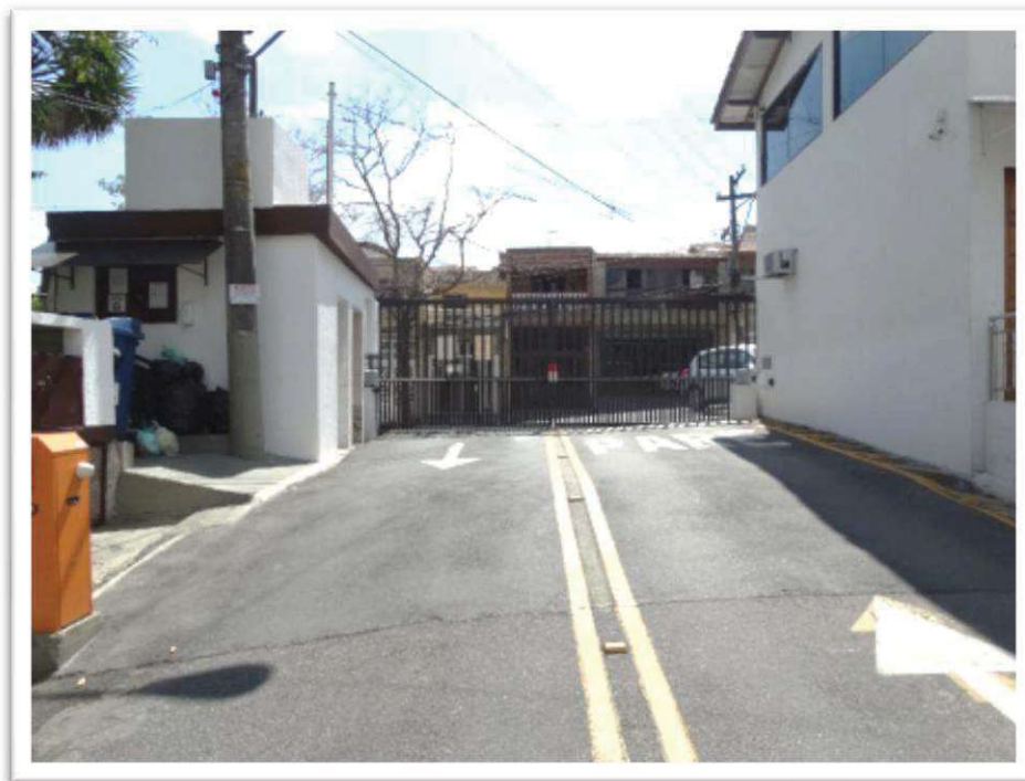
Foto nº 52 - Vista interna da entrada de veículos junto à Portaria do “CONDOMÍNIO VILA SUIÇA III”
