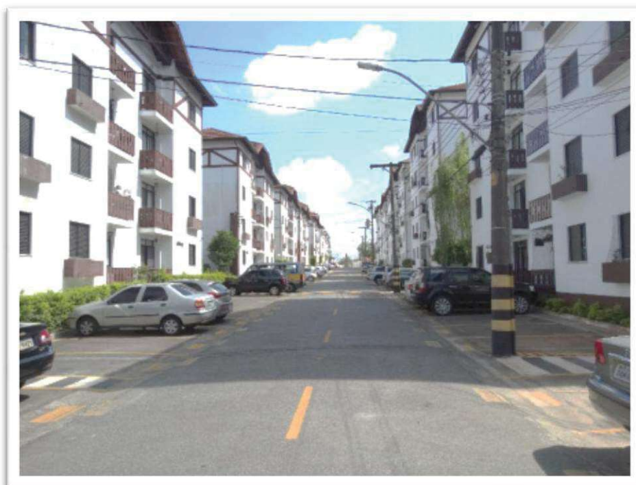
Foto nº 7 - Vista geral da rua interna do “ CONDOMÍNIO VILA SUIÇA III ”. Observador defronte ao Edifício Parpan - bloco 29, visando a entrada do condomínio.
