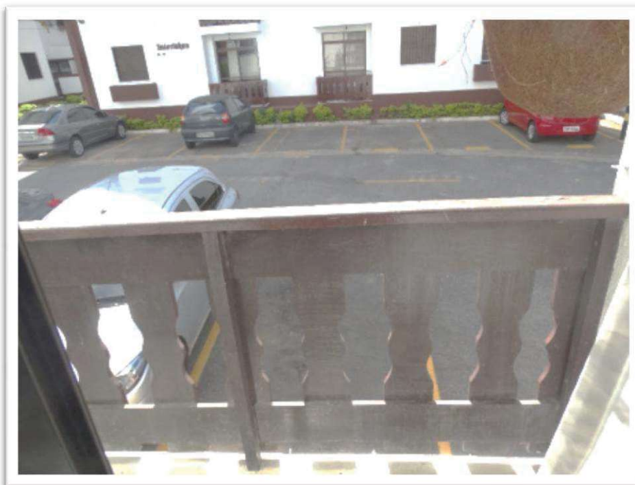
Foto nº 19 - Outra vista parcial da varanda.
