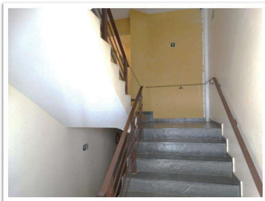
Foto nº 11 - Vista da escada interna de acesso aos pavimentos do Edifício Parpan, cujo apartamento de nº 13 é objeto da presente vistoria.
