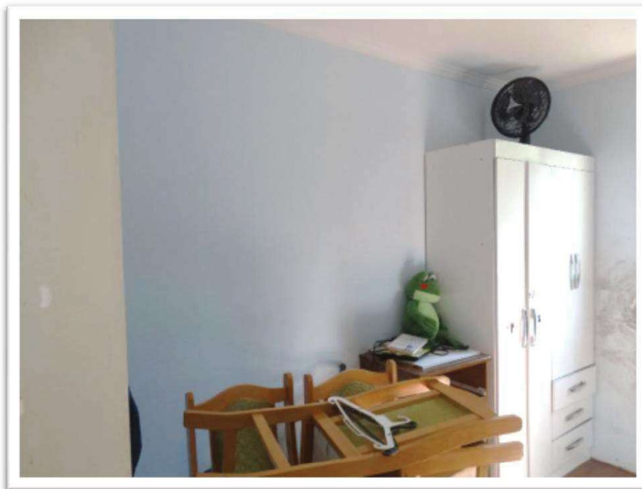
Foto nº 30 - Vista parcial interna do apartamento nº 13 do Edifício Parpan – Dormitório 1.
