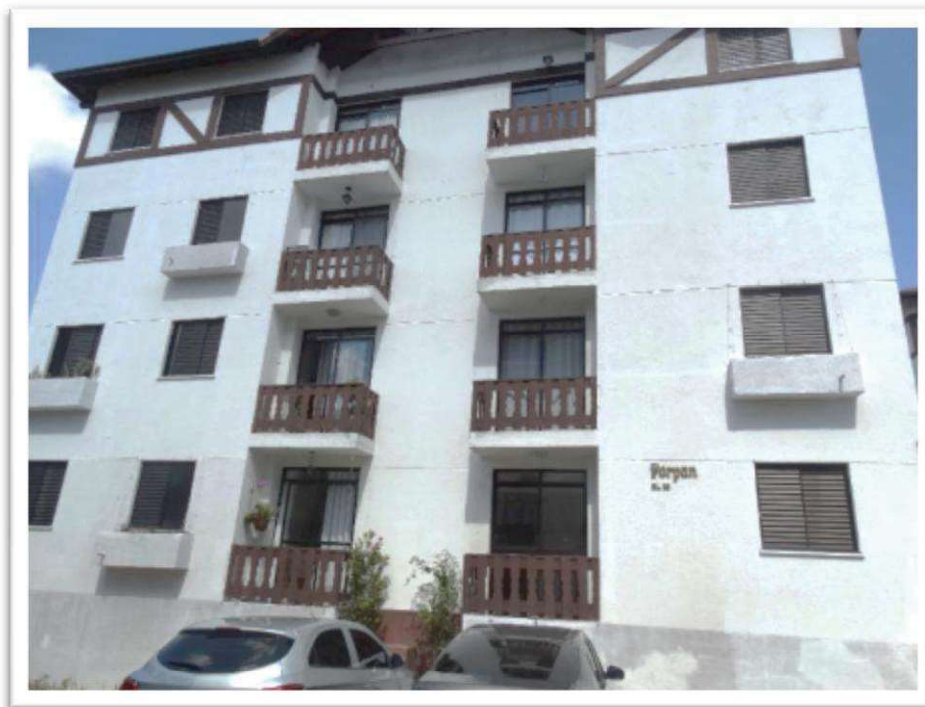
Foto nº 8 - Vista frontal do Edifício Parpan, bloco 29 do “ CONDOMÍNIO VILA SUIÇA III ”, cujo apartamento de nº 13 é objeto da presente vistoria.
