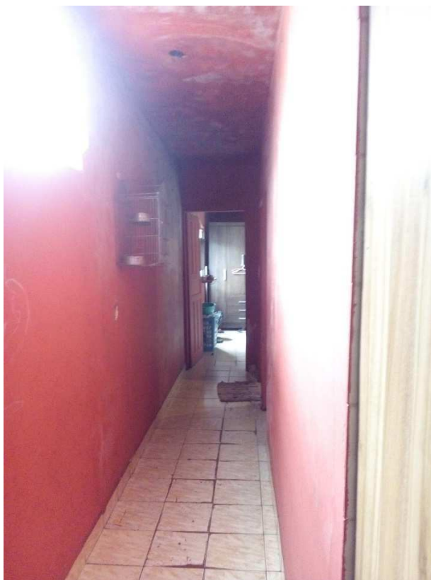
VISTA DO CORREDOR DE ACESSO AOS DORMITÓRIOS.
