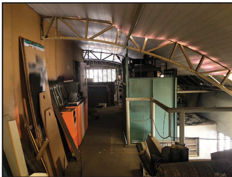
Foto 24 – 2º Pavimento – Vista 2
