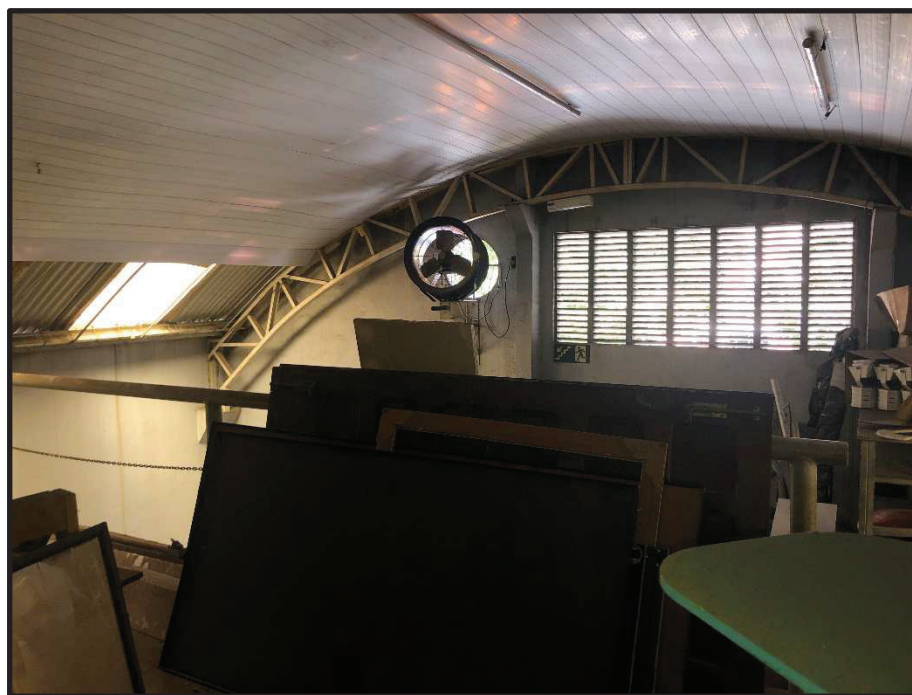
Foto 25 – 2º Pavimento – Vista 3
