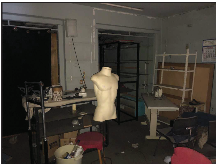
Foto 10 – Pavimento Térreo – Sala 2 – Vista 1
