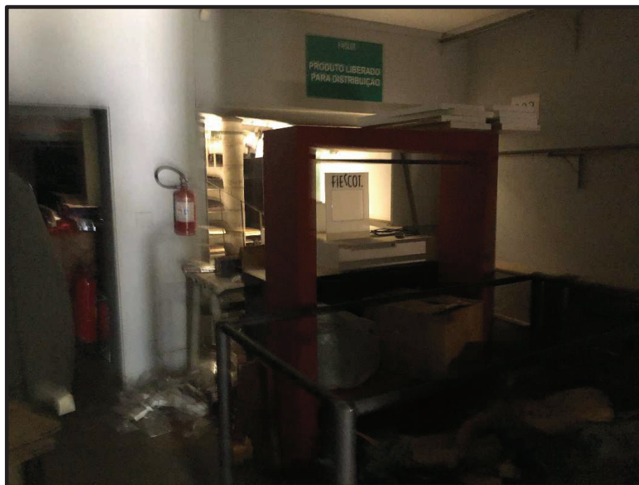
Foto 7 – Pavimento Térreo – Sala 1 – Vista 1
