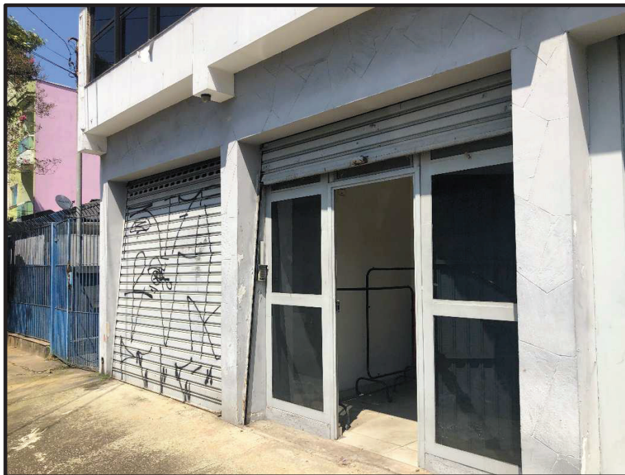
Foto 3 – Rua Nassau, nº 48 e 52 – Entrada
