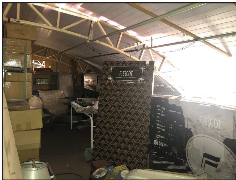
Foto 26 – 2º Pavimento – Vista 4
