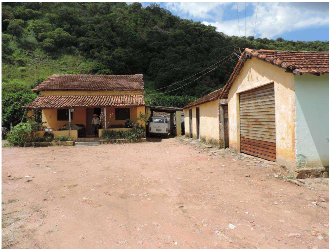
FOTO Nº 05 – VISTA EXTERNA DAS EDIFICAÇÕES/CASAS
