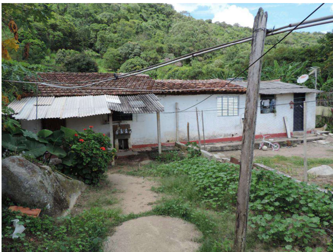
FOTO Nº 14 – VISTA EXTERNA DAS EDIFICAÇÕES/CASAS
