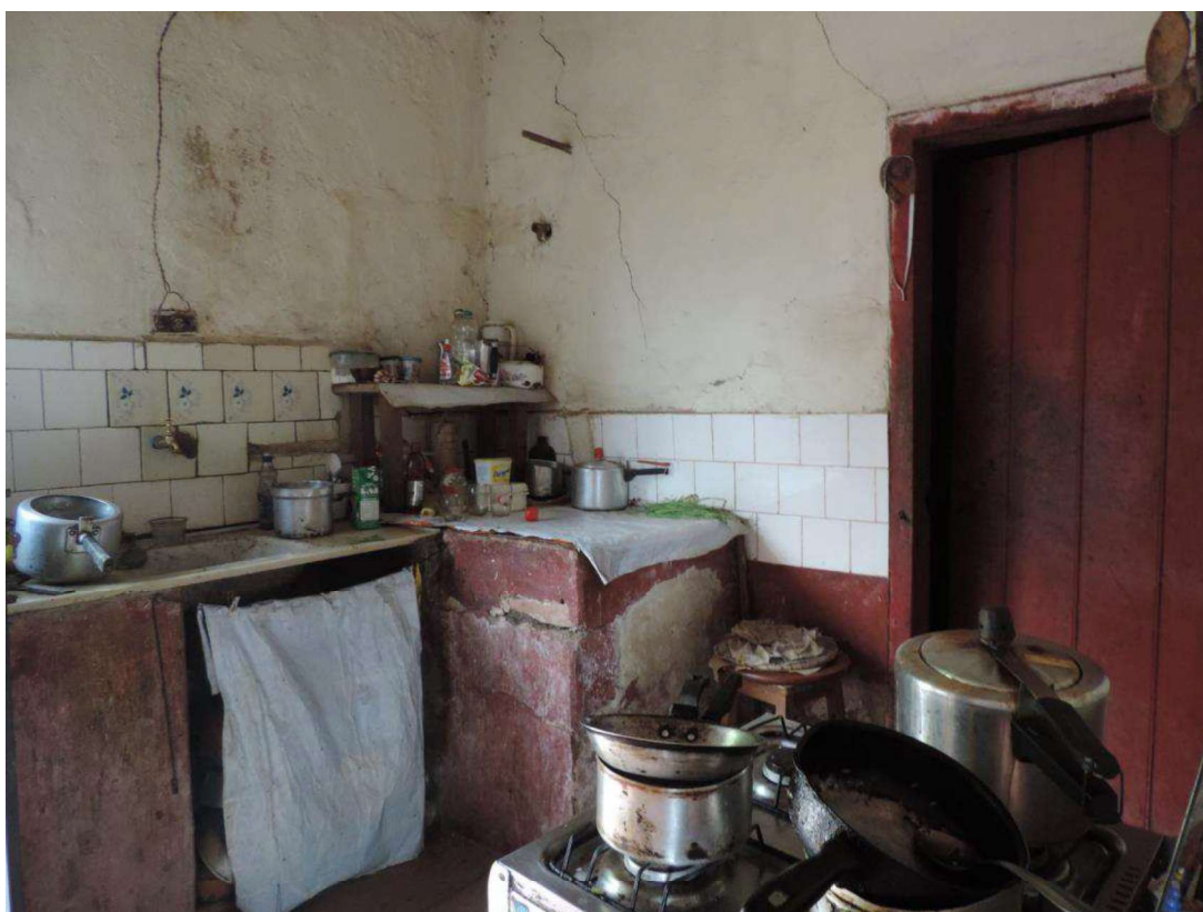
FOTO Nº 10 – VISTA INTERNA DAS EDIFICAÇÕES/CASAS
