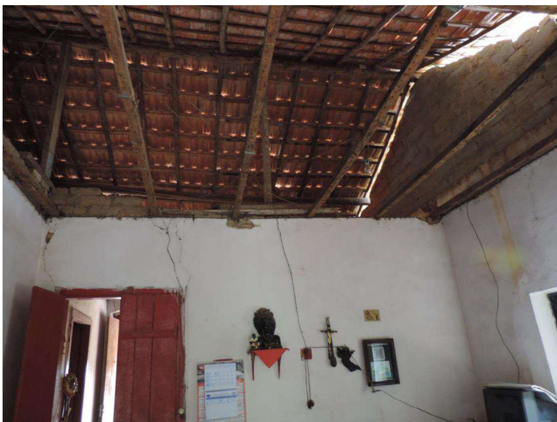
FOTO Nº 12 – VISTA INTERNA DAS EDIFICAÇÕES/CASAS
