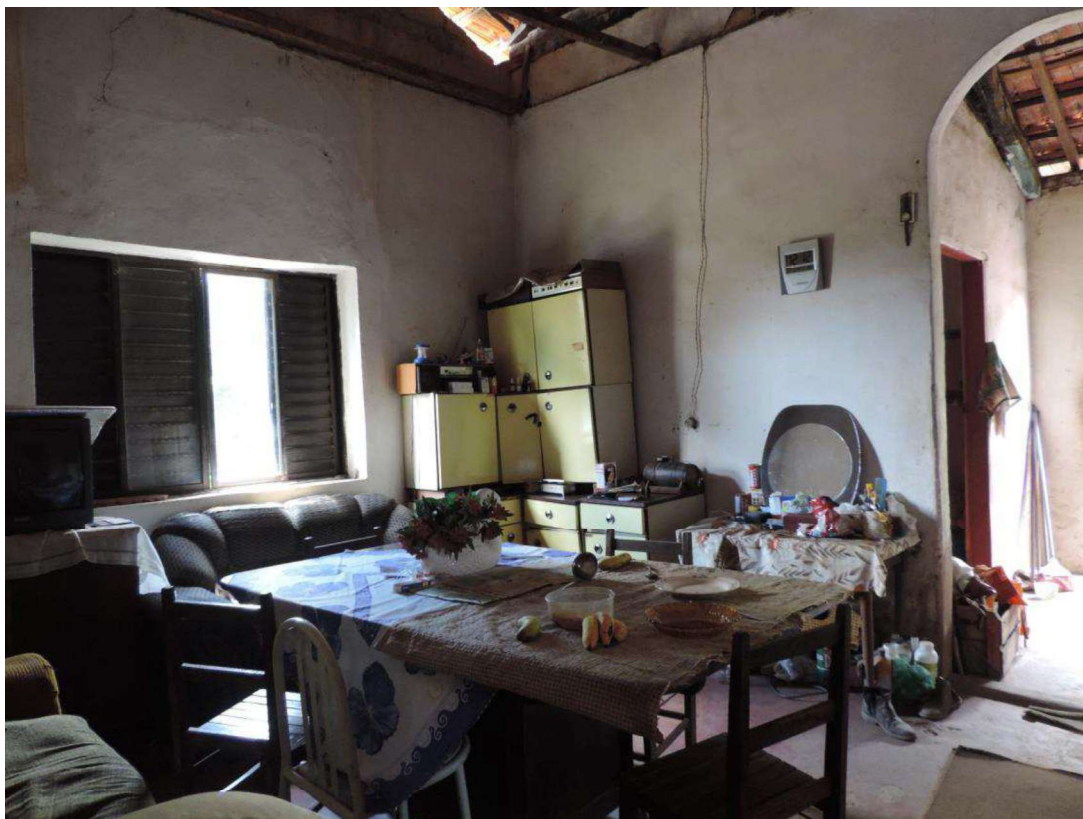
FOTO Nº 07 – VISTA INTERNA DAS EDIFICAÇÕES/CASAS
