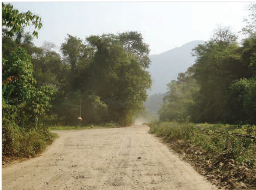
Acesso não pavimentado ao Terreno
