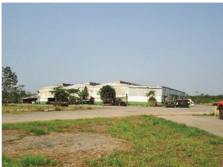
Galpão Principal – fachada Sudoeste
