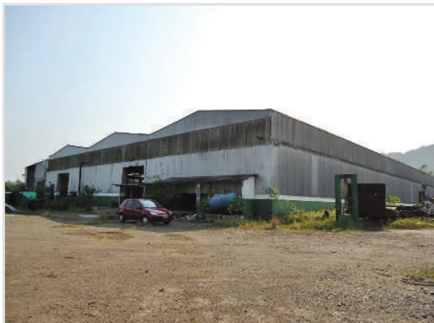
Galpão Principal – fachada Nordeste
