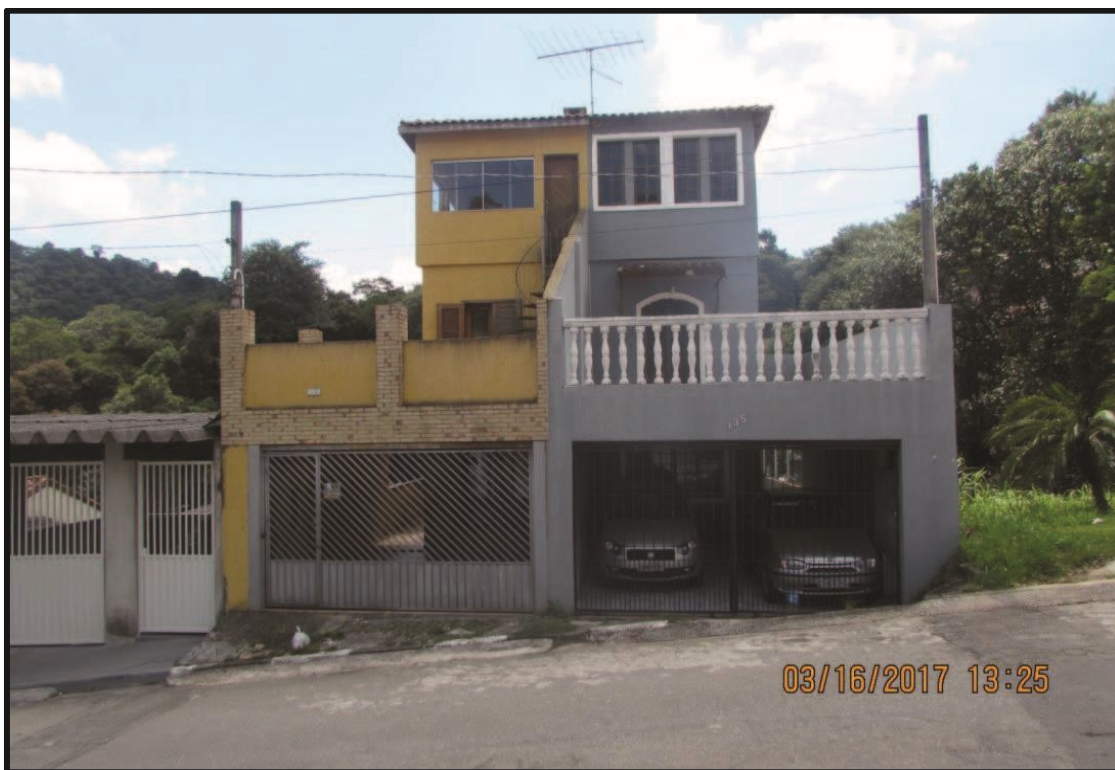
Vista frontal do imóvel nº135
