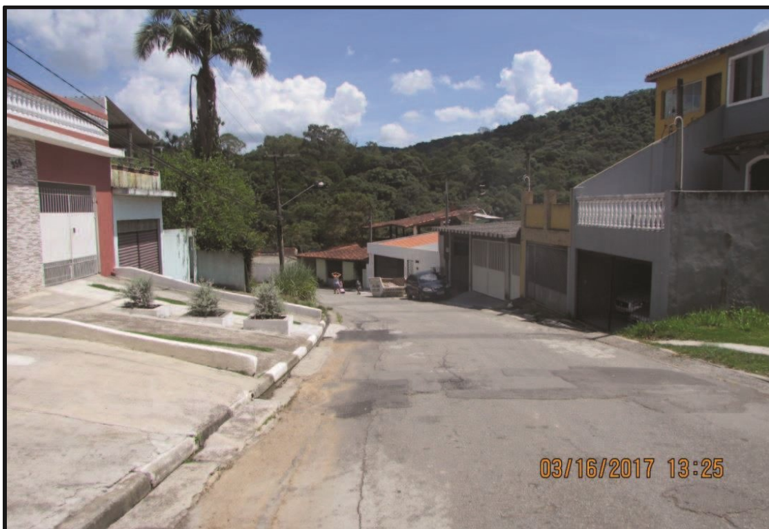
Vista da Rua Netuno, no trecho considerado
