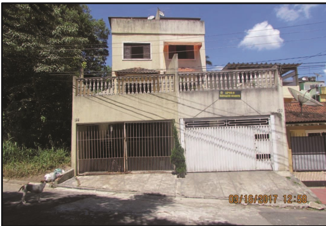
Vista frontal do imóvel, casa nº 120 e 122 – Rua Apolo
