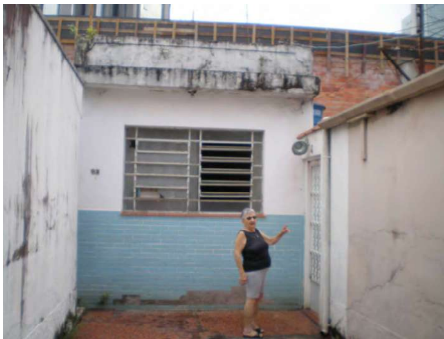
Foto 13- Fachadas Casa 1 e Casa 3..
