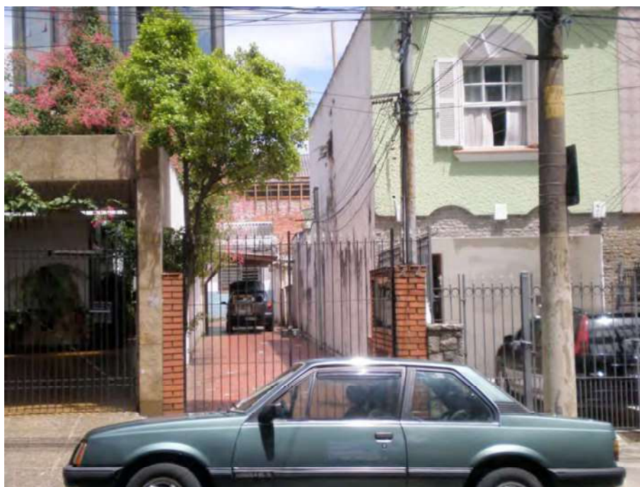
Foto 2- Vista frontal do imóvel avaliando com sua estreita entrada.
