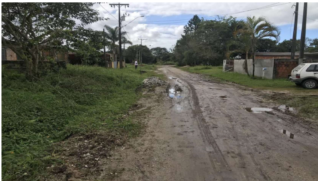
Foto 08 - Vista da referida rua Sol Nascente
