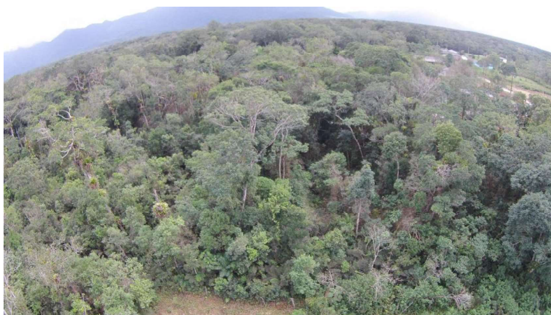
Foto 05 - Vista dos lotes 22 e 24
