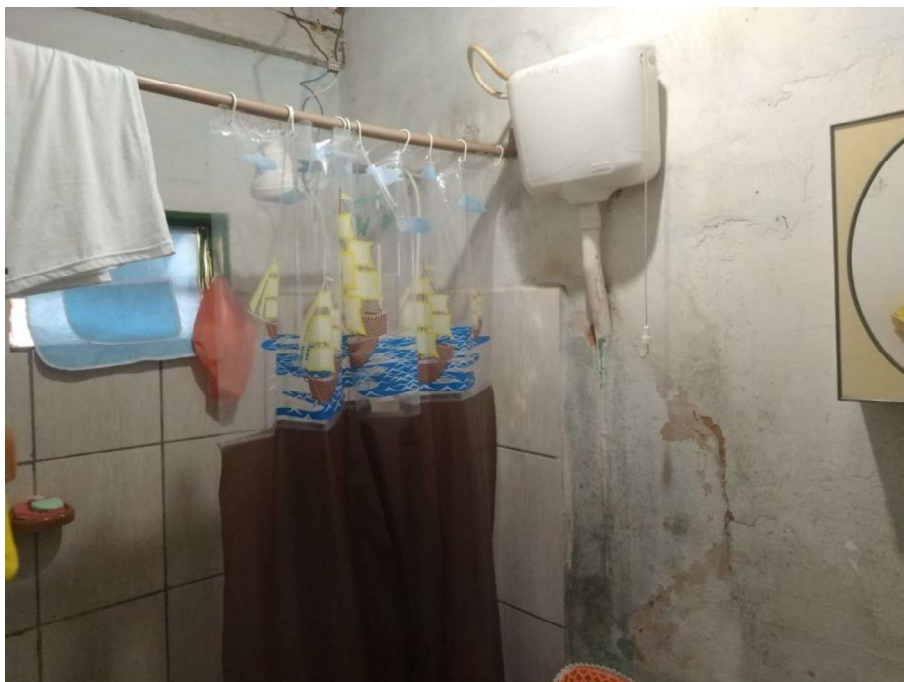
FOTO 09 – Mostrando o banheiro do imóvel.
