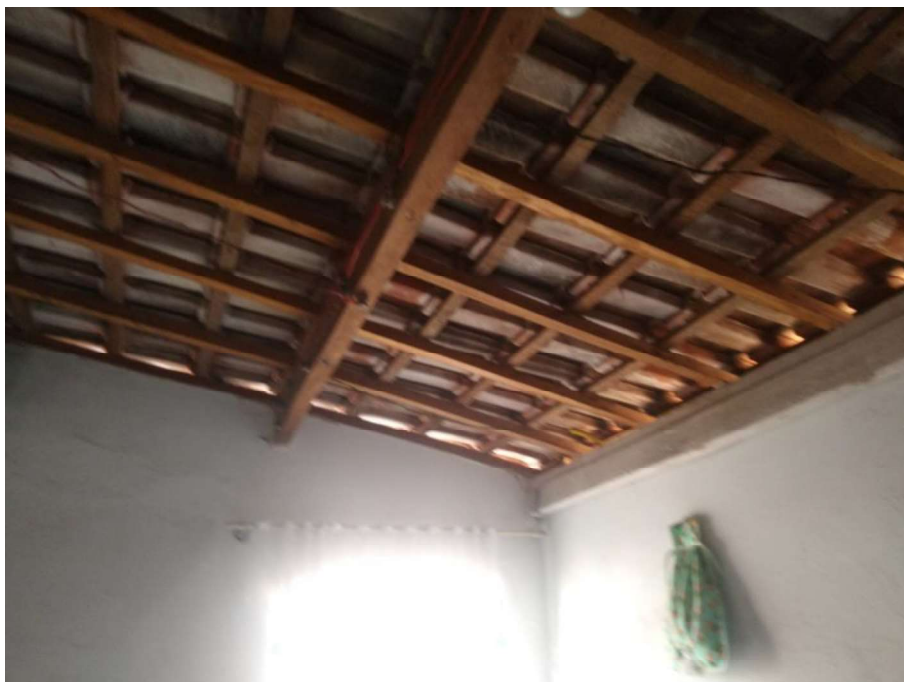
FOTO 11 – Mostrando o telhado com telhas de barro sem forro.
