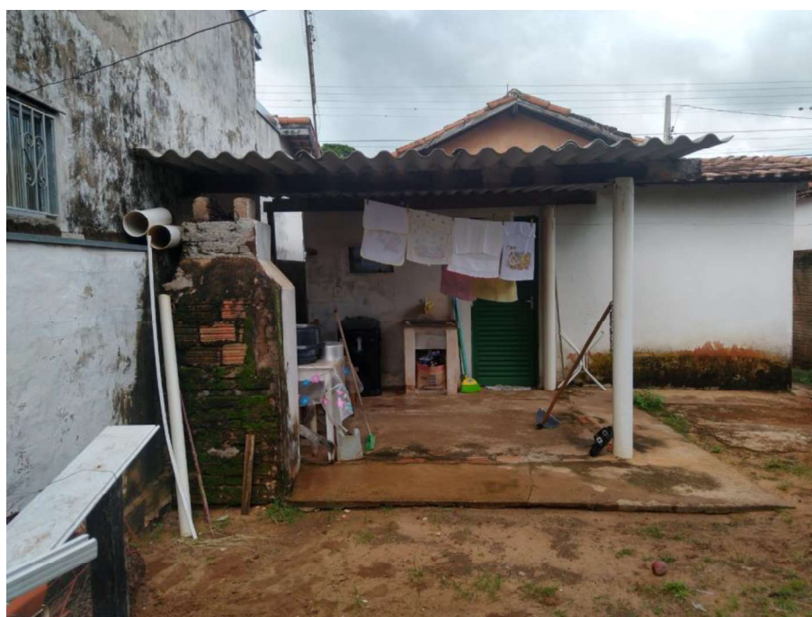
FOTO 04 – Mostrando a área de serviço, simples, aberta e coberto com telhas de amianto
