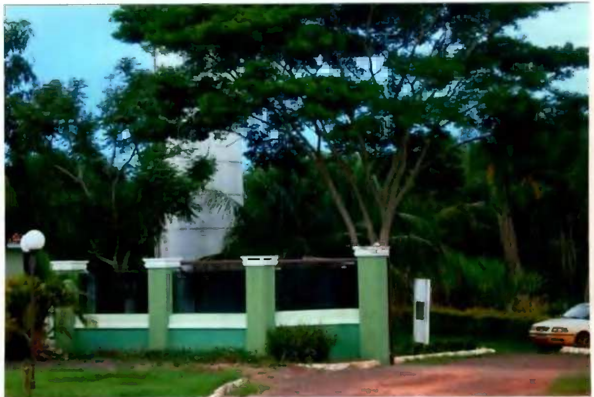
Vista da guarita de entrada do condomínio " São José do Macaúba, com os acessos de entrada e saída sem pavimentação asfáltica.
