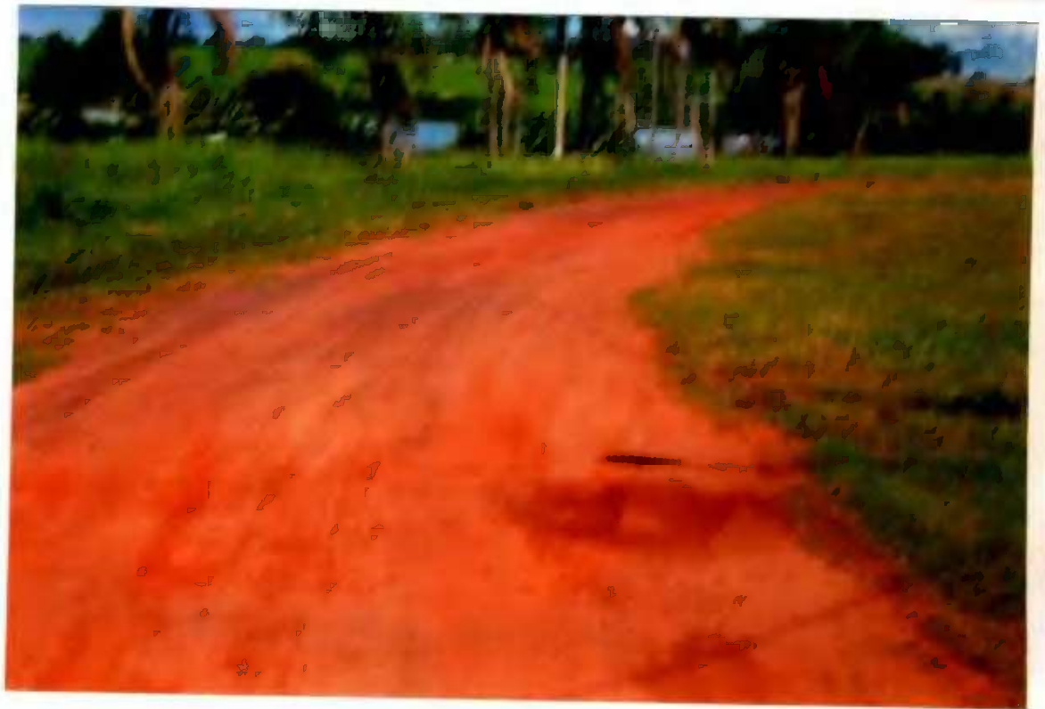
Vista parcial do leito da Rua Pacu, para a qual os lotes penhorados possuem testadas, apresentando traçado sinuoso, sem asfalto, sem guias e passeios públicos calçados.
