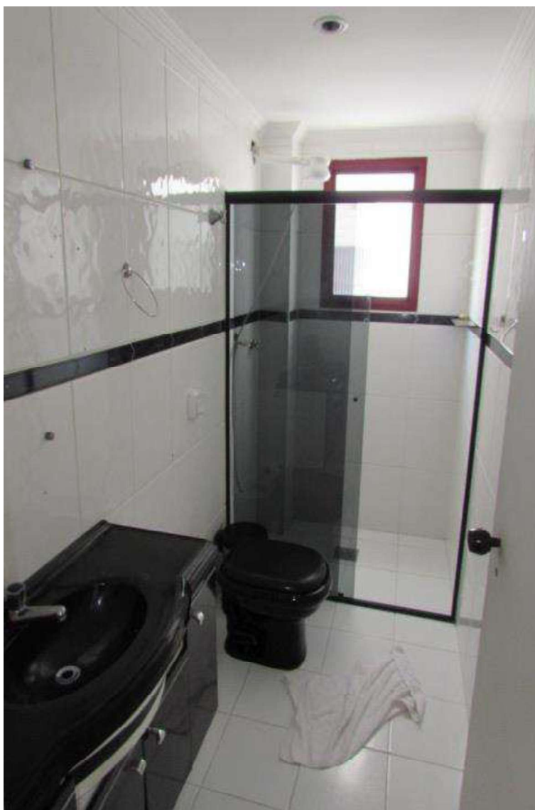
Foto 09 – Vista de um banheiro com piso cerâmico, paredes azulejadas até o teto, forro em laje e esquadrias de alumínio.
