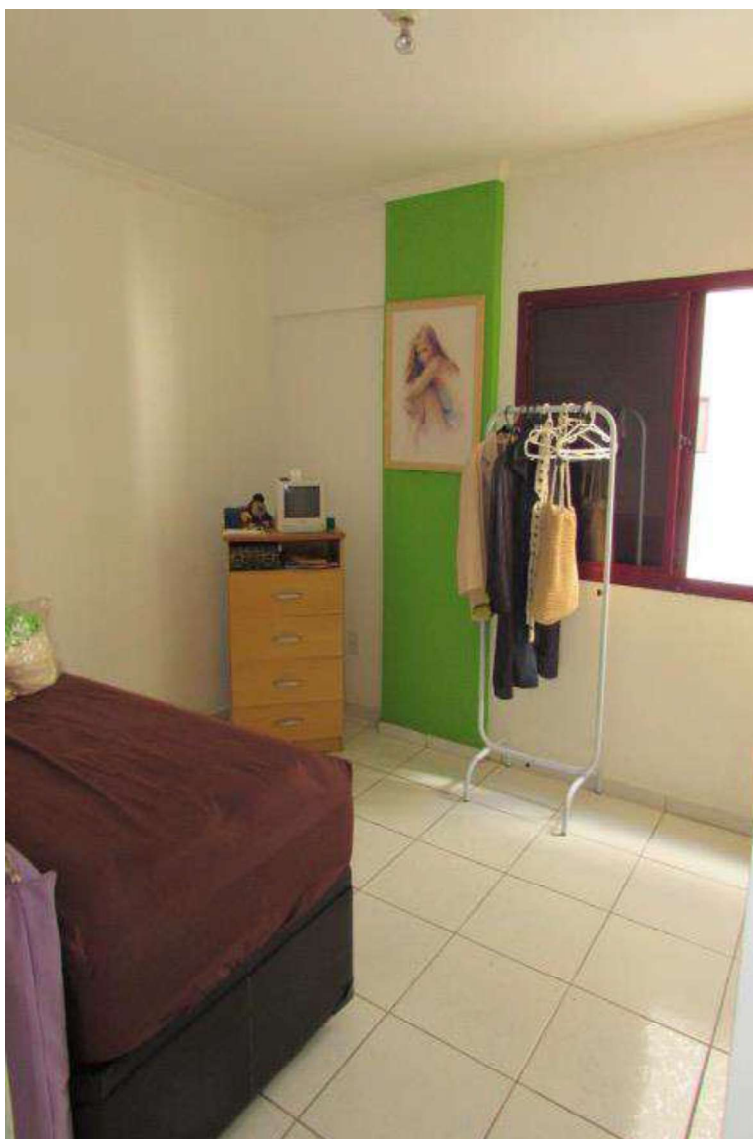
Foto 10 – Vista de outro dormitório com piso cerâmico, paredes revestidas em massa corrida pintadas em látex, forro em laje e esquadrias de alumínio.
