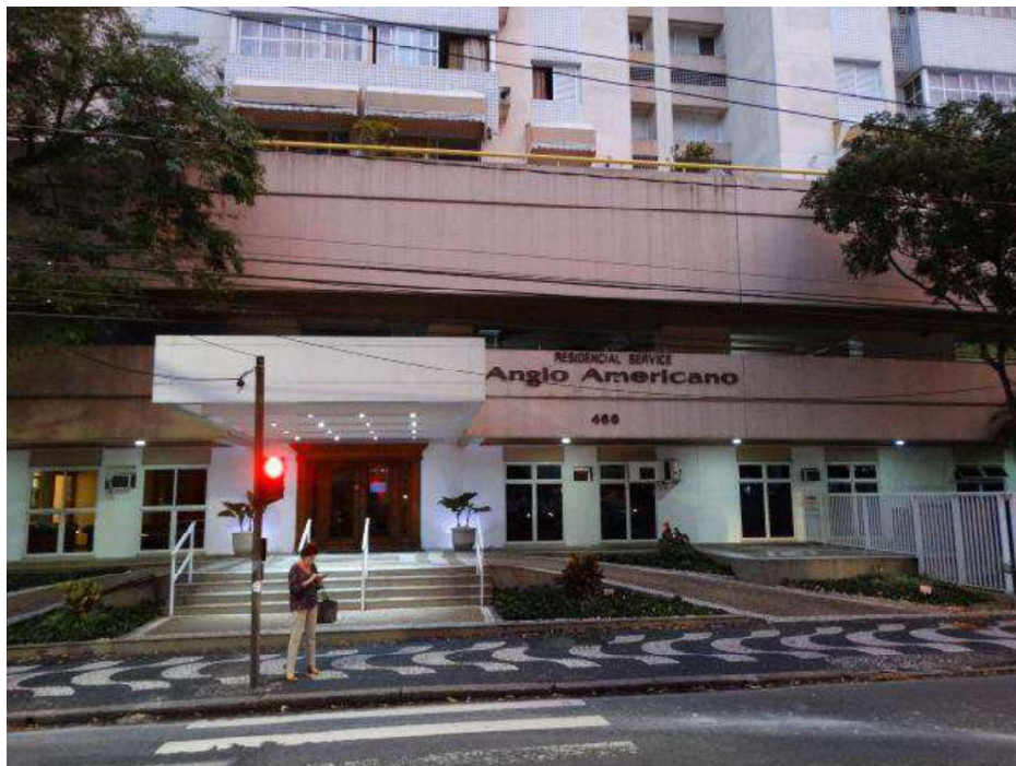
FOTO N° 2 - Vista da entrada do condomínio.
