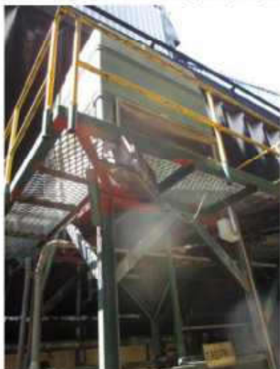
Vista da unidade de refrigeração 1.
