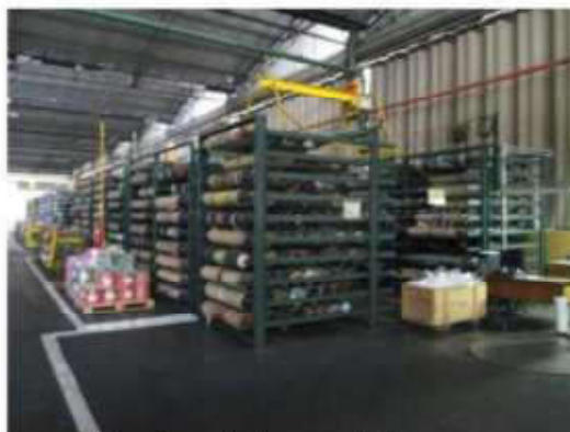
Vista da estrutura metálica para armazenamento de cilindros.
