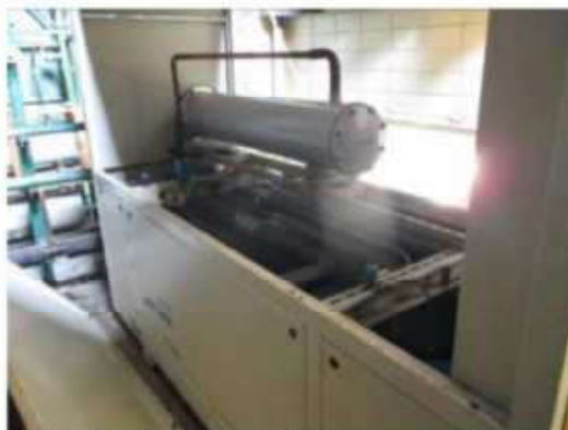
Unidade de água gelada , marca Refrisat, modelo SAT.090-W
