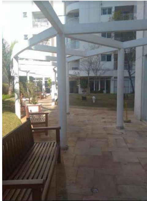
FOTO Nº 03 Vista parcial acesso da Torre II Edifício Veridiana
