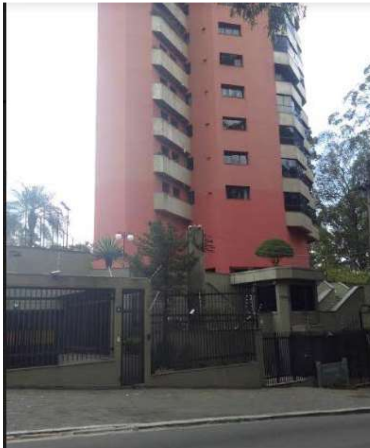
FOTO Nº 01 Vista parcial fachada Edifício Carlbridge Park
