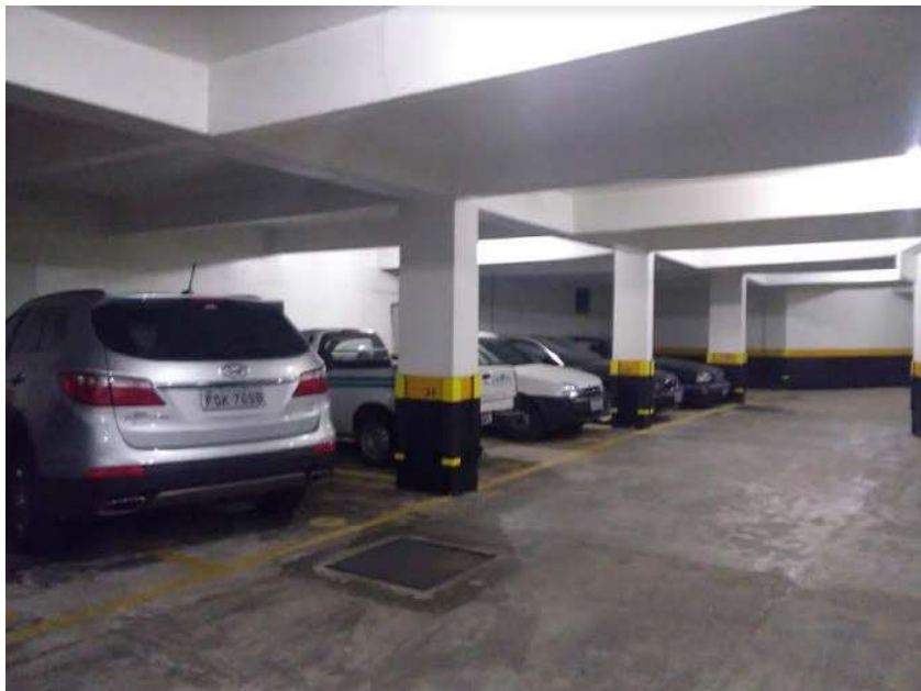
FOTO Nº29 Vista parcial Garagem
