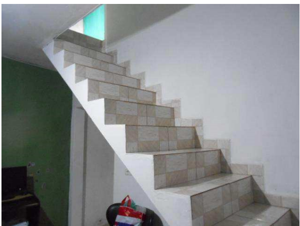
Foto 11 – Escada acesso ao superior
