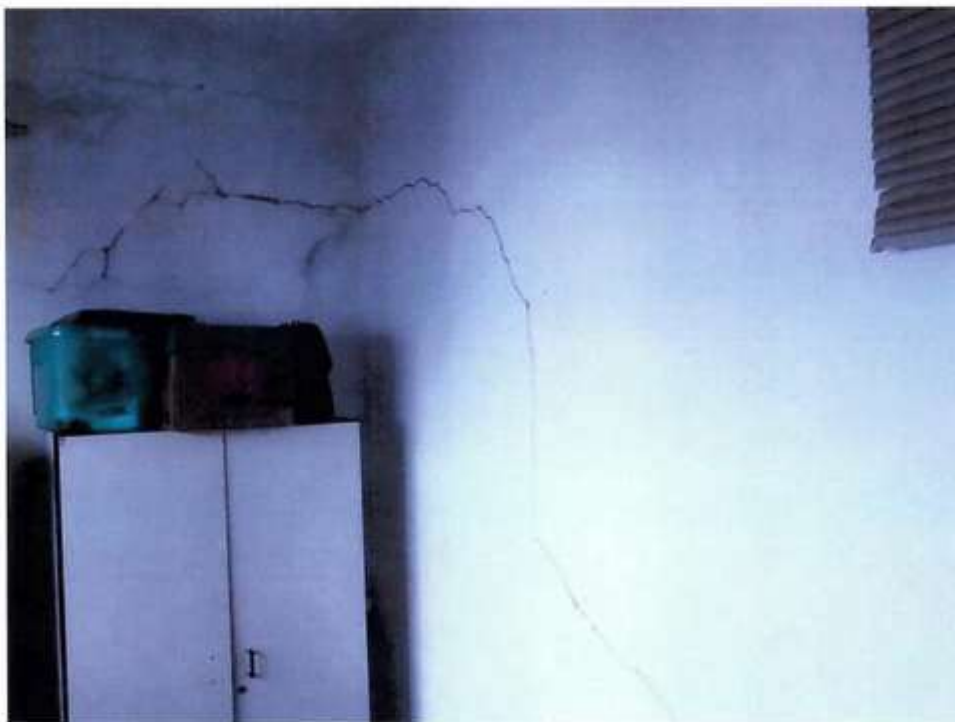
Foto 36 – Detalhe de trinca na parede do escritório (2º superior)
