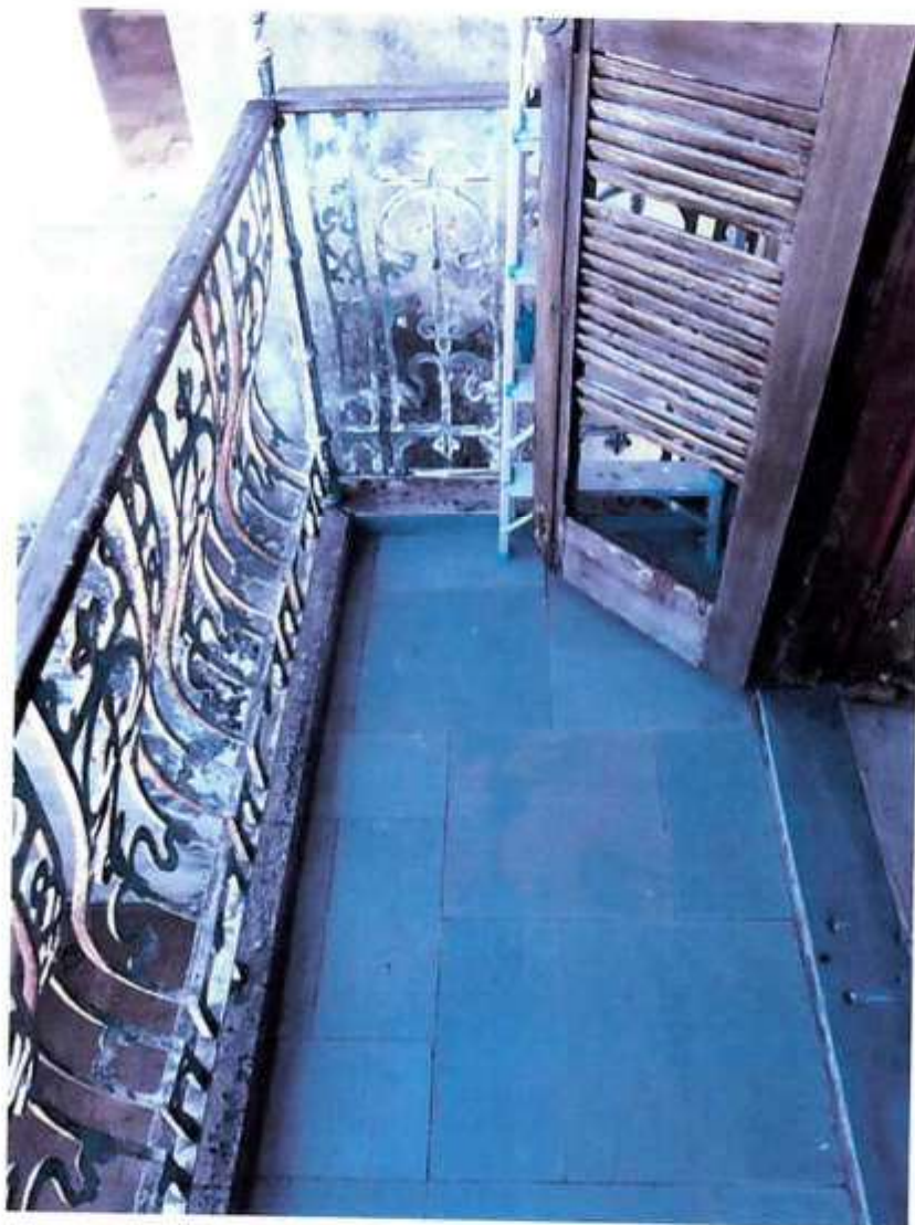
Foto 21 – Vista da sacada (1º superior)
