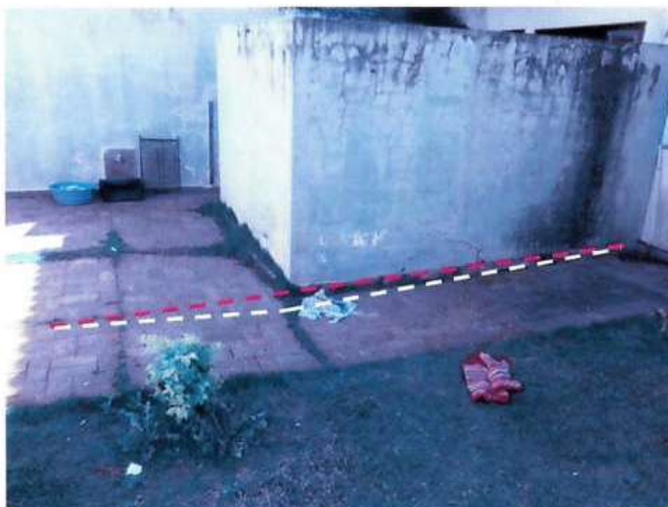
Foto 54 – Vista geral da área externa (inferior) detalhe de recalque linha amarela
