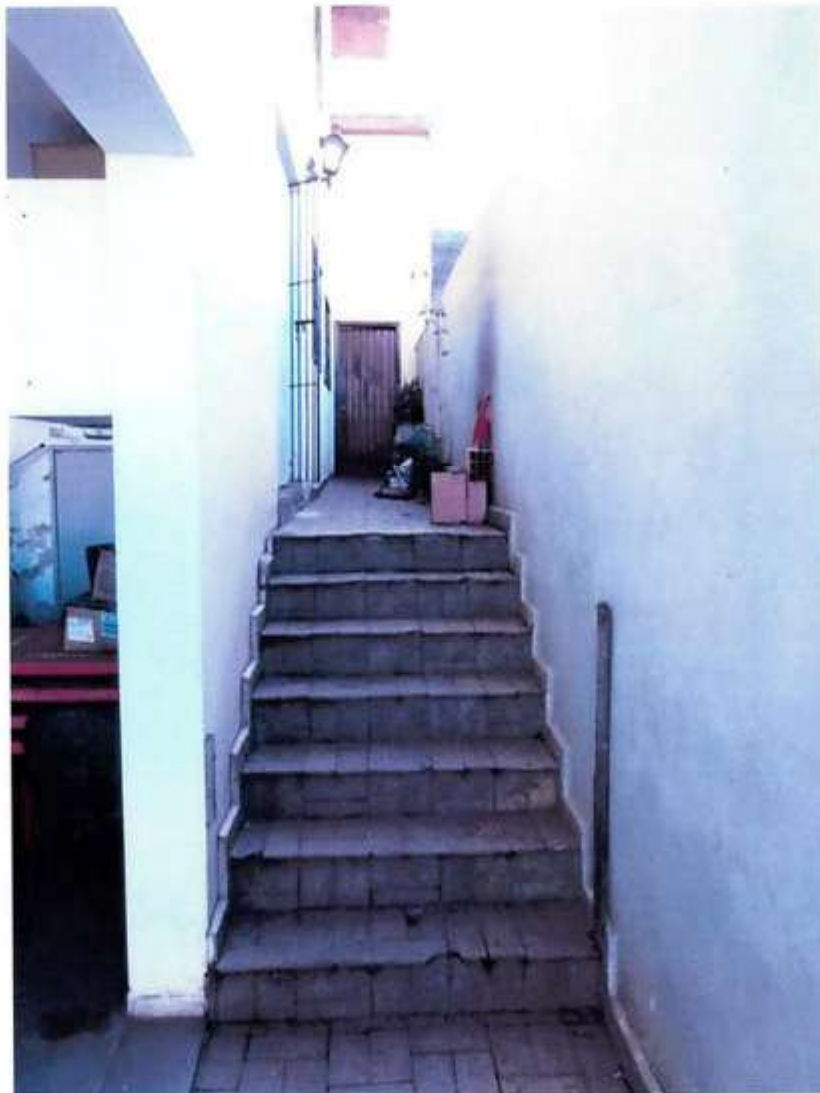
Foto 60 – Vista do corredor de distribuição lateral (inferior)
