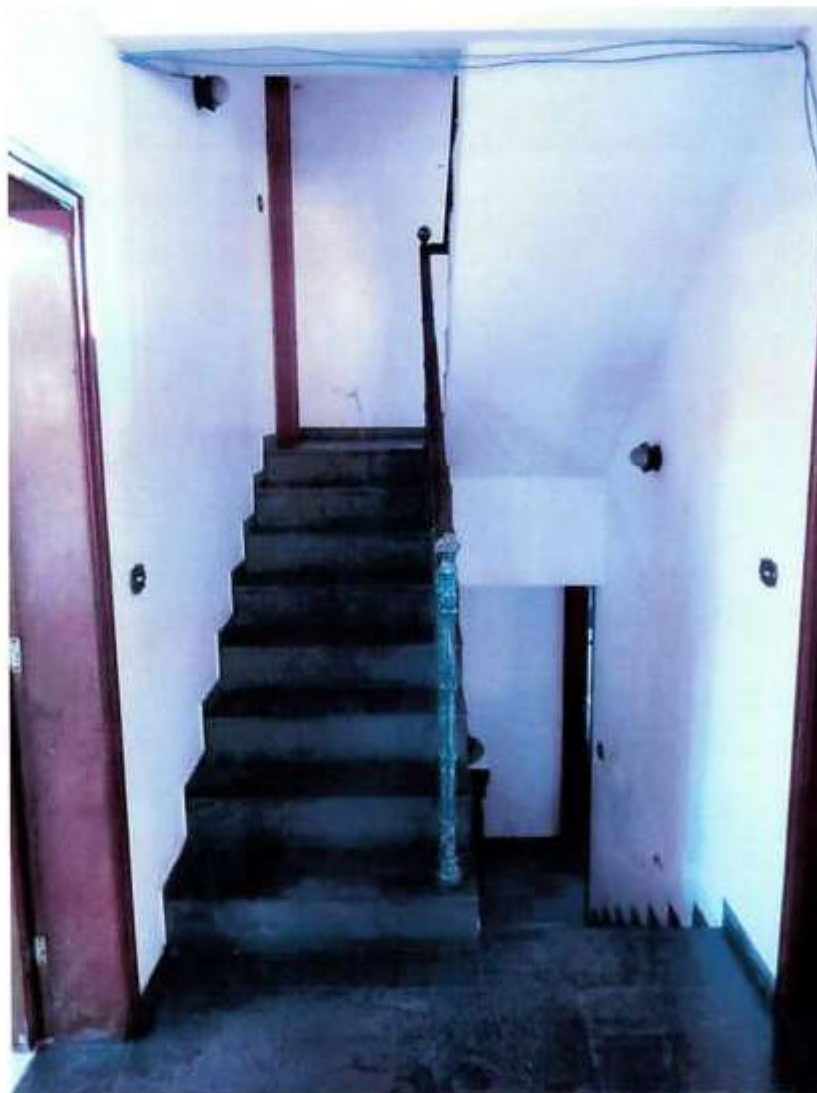
Foto 17 – Vista da escada de acesso ao a 1º andar superior (térreo)
