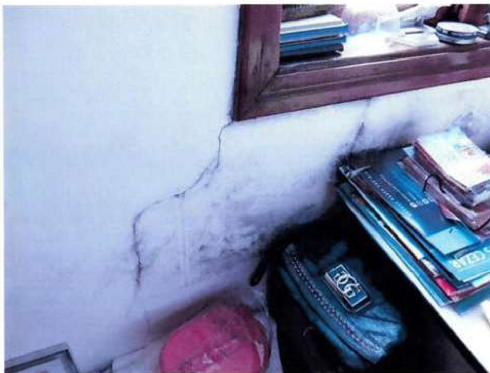
Foto 36 – Detalhe de trinca na parede do escritório (2º superior)
