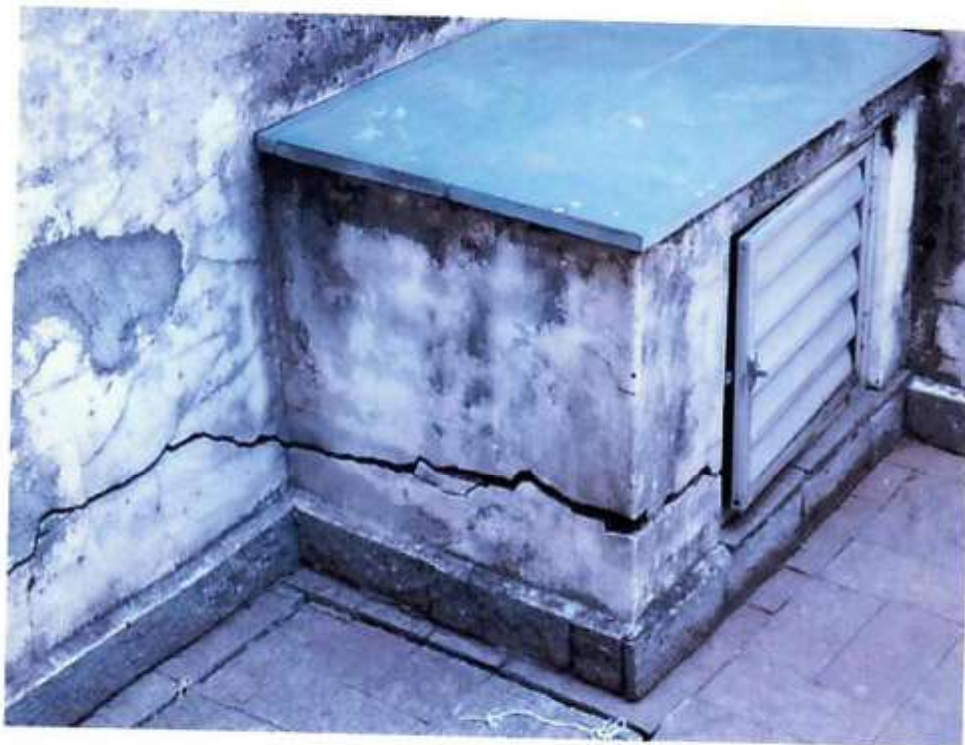
Foto 50 – Detalhe de trinca no piso (inferior) – em função de recalque
