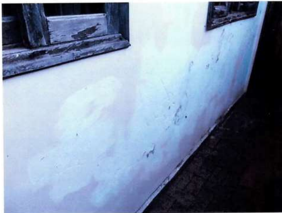
Foto 61 – Detalhe de reparo na parede (térreo)
