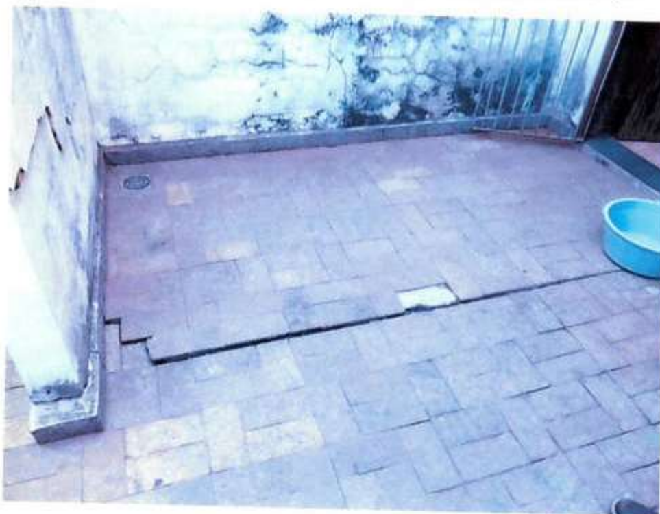
Foto 50 – Detalhe de trinca no piso (inferior) – em função de recalque
