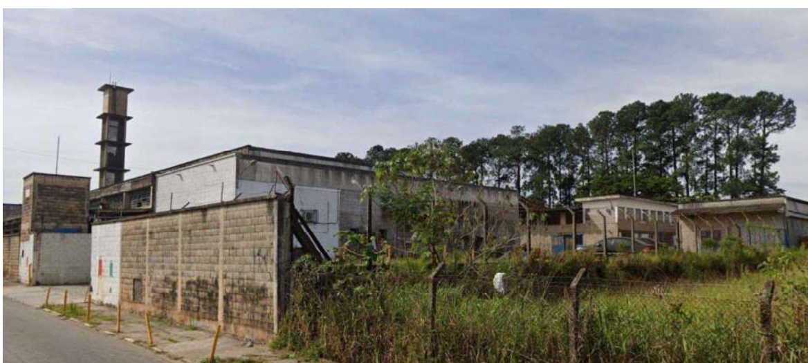
Foto 07 – Vista externa dos galpões
