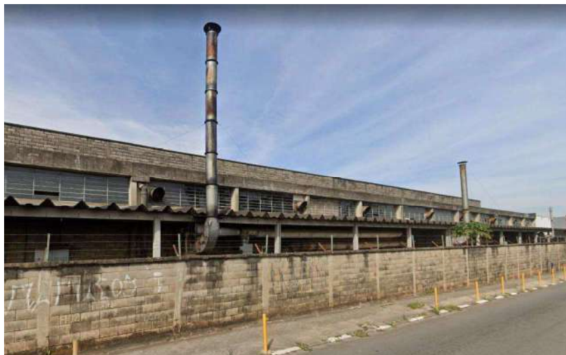
Foto 05 – Vista externa dos galpões
