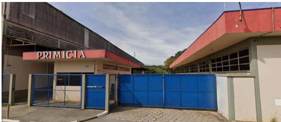
Foto 01 – Vista da entrada principal - Av. David Kasitzki, 135
