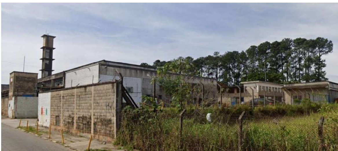
Foto 07 – Vista externa dos galpões
