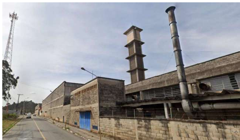
Foto 09 – Vista externa dos galpões
