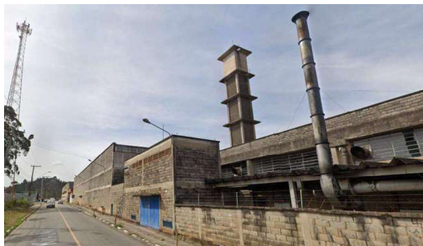
Foto 09 – Vista externa dos galpões
