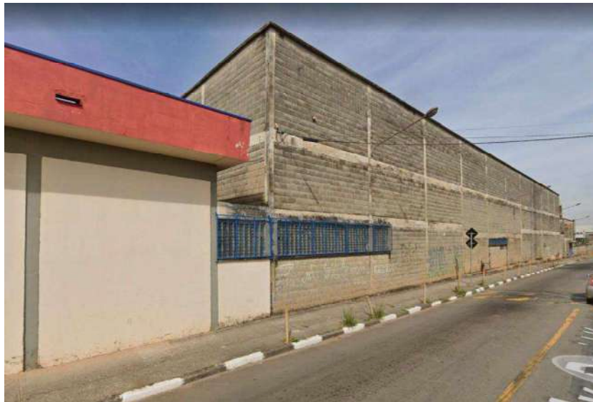
Foto 03 – Vista externa dos galpões
