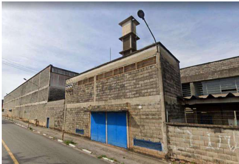
Foto 04 – Vista externa dos galpões
