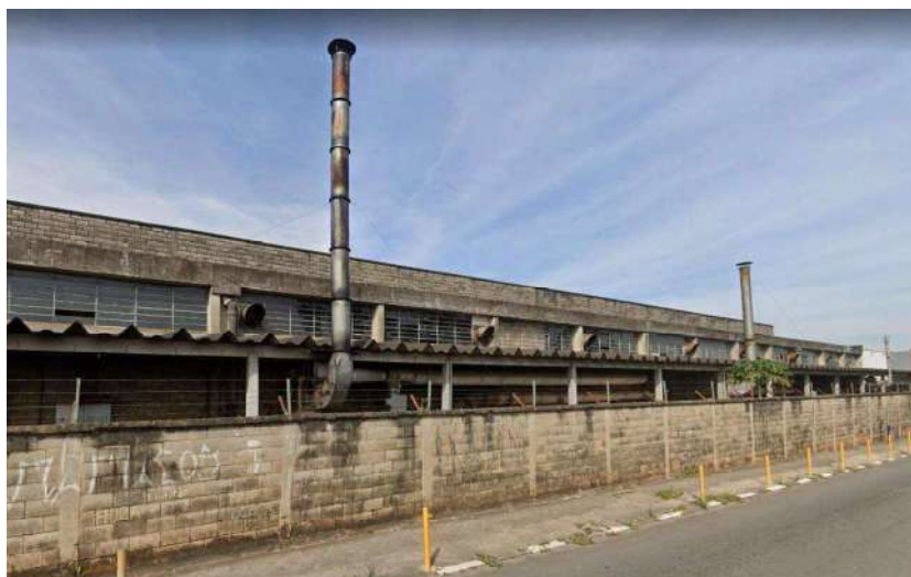
Foto 05 – Vista externa dos galpões
