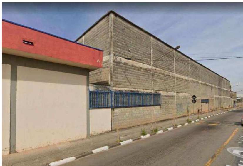
Foto 03 – Vista externa dos galpões
