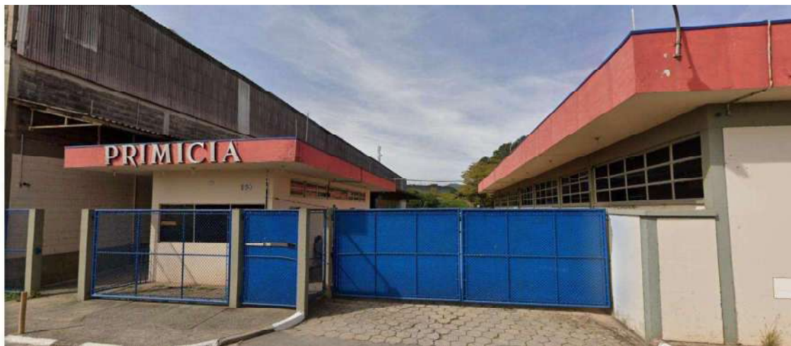
Foto 01 – Vista da entrada principal - Av. David Kasitzki, 135
