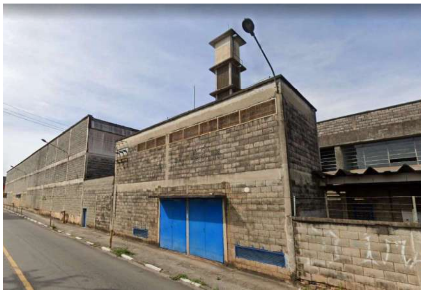
Foto 04 – Vista externa dos galpões
