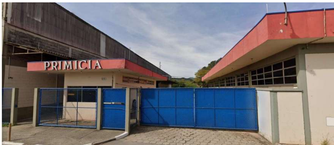
Foto 01 – Vista da entrada principal - Av. David Kasitzki, 135
