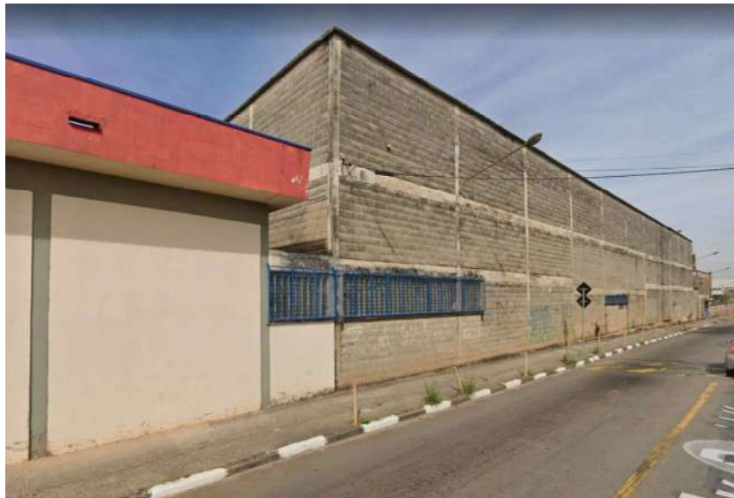
Foto 03 – Vista externa dos galpões
