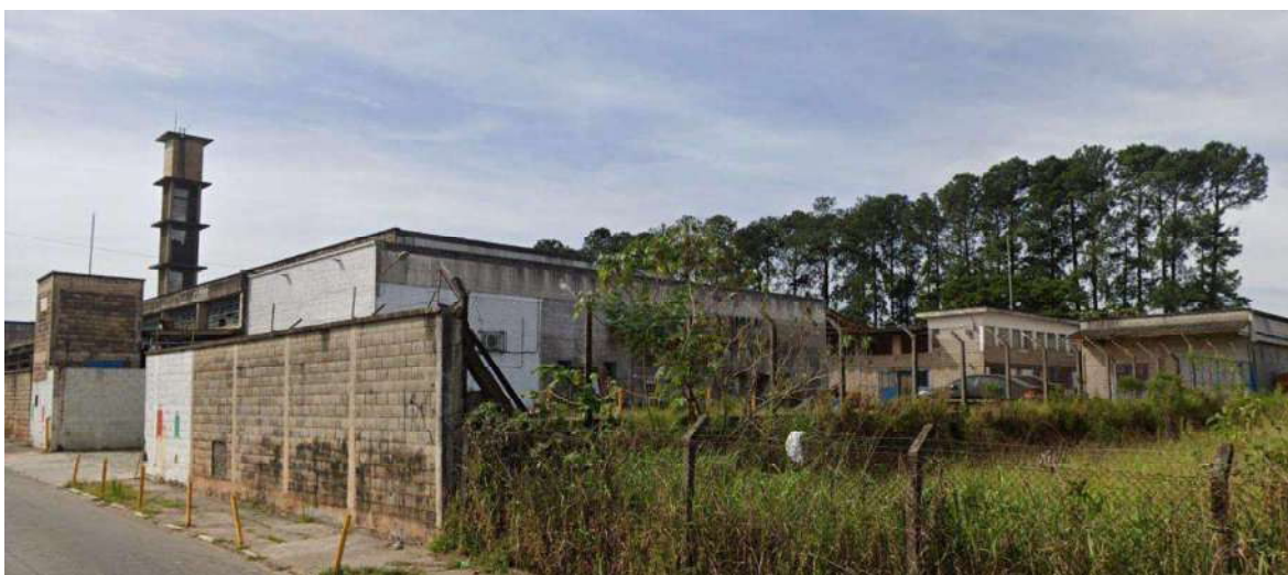
Foto 07 – Vista externa dos galpões
