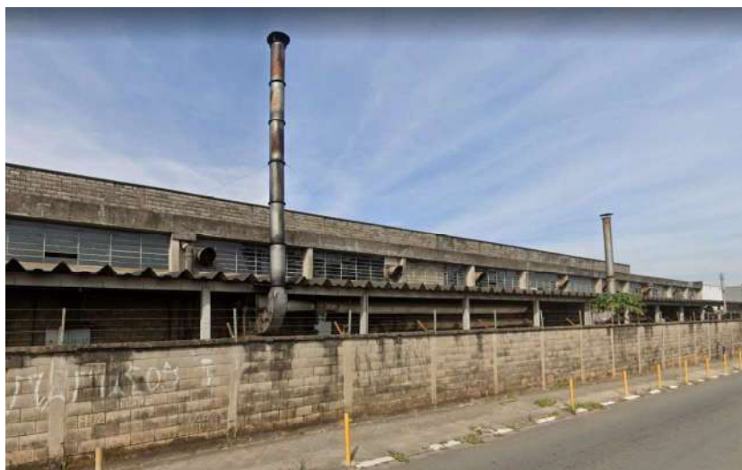
Foto 05 – Vista externa dos galpões
