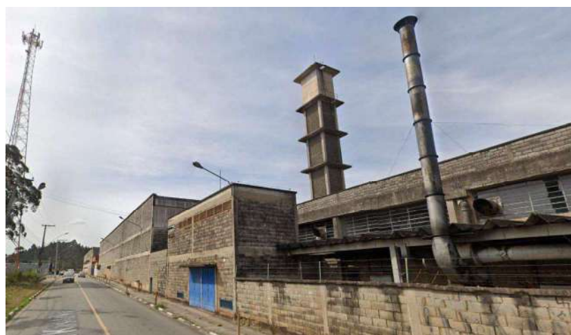
Foto 09 – Vista externa dos galpões
