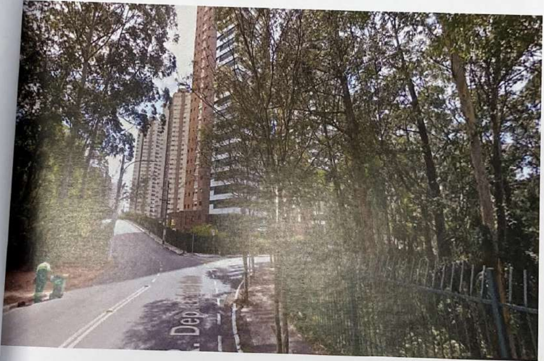
AV. DR. LAÉRCIO CORTE VIA DE ACESSO AO IMÓVEL
