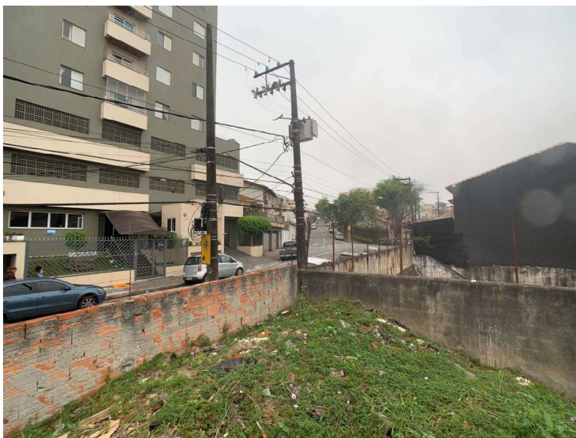
Foto 01: Vista do muro sobre Rua Dr. Antônio Jorge Franco.
