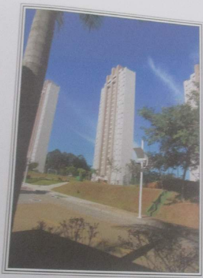
FOTO 29 : Vista parcial do Edifício Amarante, Bloco B, em que se situa o a unidade nº 201, ora avalianda.
