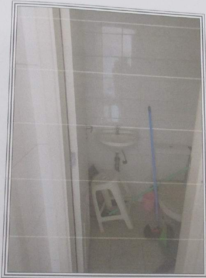
FOTO 135 : Vista parcial do banheiro de empregada da unidade nº 43, ora avalianda.
