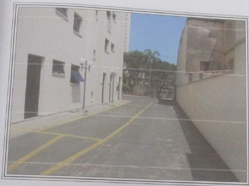
FOTO 145 : Outra vista interna do Condomínio Edifício The Winner, notando-se as vagas de garagem descobertas no pavimento térreo.
