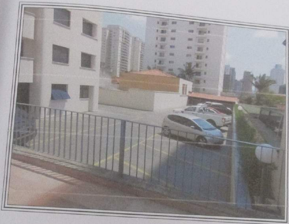
FOTO 147 : Outra vista interna do Condomínio Edifício The Winner, notando-se as vagas de garagem descobertas no pavimento térreo.
