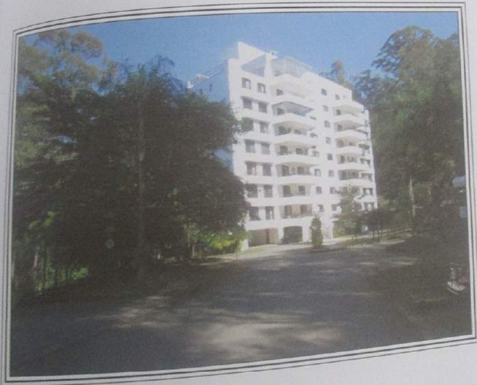
FOTO 68 : Vista parcial do Edifício Spoleto, Bloco 4, em que se situa o a unidade nº 51, ora avalianda.
