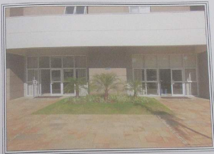
FOTO 31 : Vista parcial da entrada social do Edifício Amarante, Bloco B, no qual se situa a unidade nº 201, ora avalianda..
