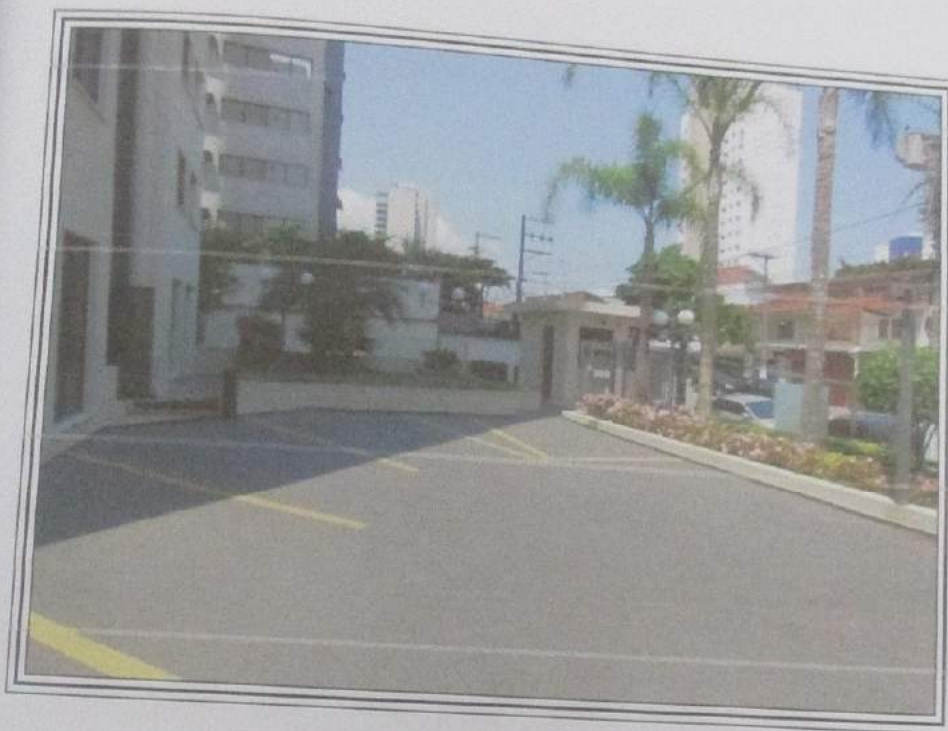
FOTO 144 : Vista interna do Condomínio Edifício The Winner, notando-se as vagas de garagem descobertas no pavimento térreo.
