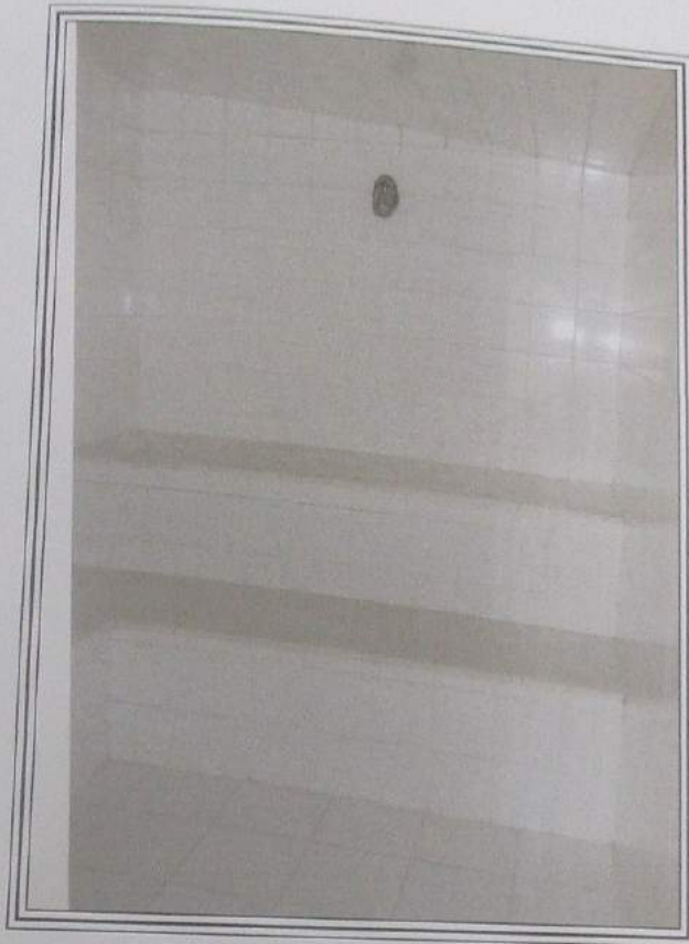
FOTO 25 : Vista Vista parcial da sauna úmida existente no Condomínio Forte do Golf.
