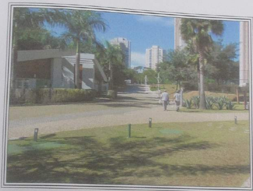
FOTO 06 : Vista parcial das vias internas e das áreas de jardins na parte da frente do Condomínio Forte do Golf.
