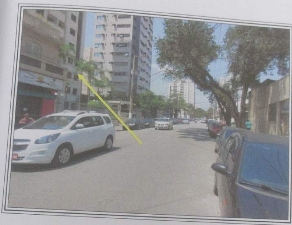
FOTO 141 : Outro ângulo da Rua Alexandre Dumas, notando-se o Condomínio Edifício The Winner, à esquerda, onde apontado.
