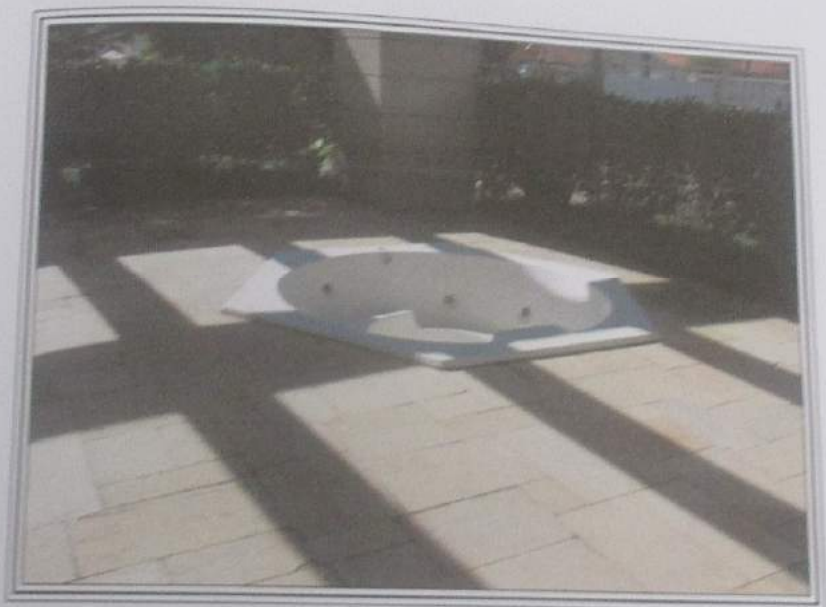
FOTO 27 : Detalhe da jacuzzi existente junto à área das saunas do Condomínio Forte do Golf.
