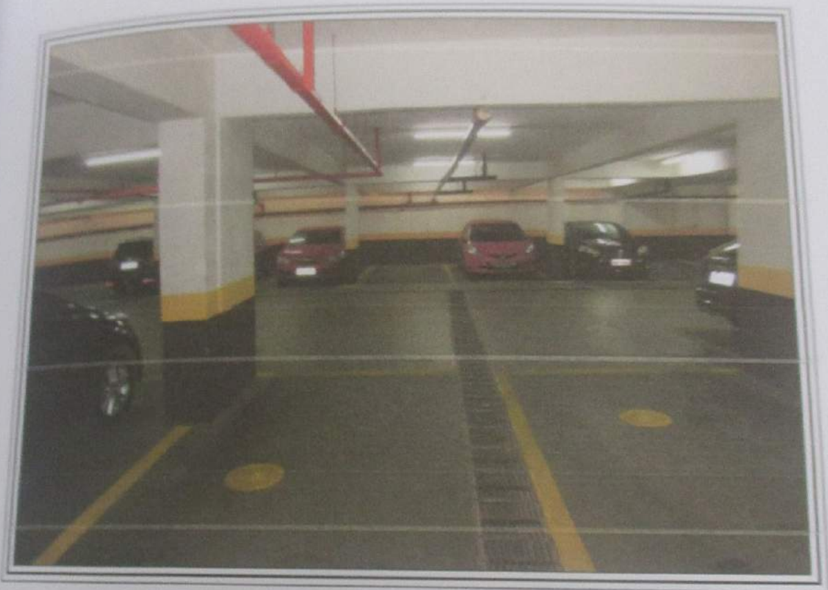
FOTO 166 : Vista parcial da área de garagem no subsolo do edifício, notando-se, em primeiro plano, a vaga de uso da unidade n° 52, ora avalianda.
