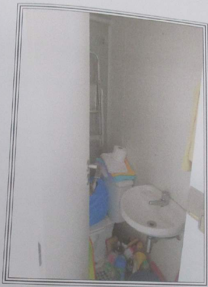
FOTO 47 : Vista parcial do banheiro de empregada da unidade nº 201, ora avalianda.
