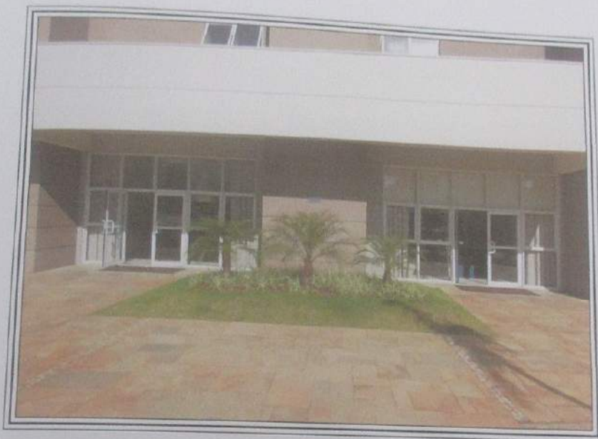
FOTO 31 : Vista parcial da entrada social do Edifício Amarante, Bloco B, no qual se situa a unidade nº 201, ora avalianda..
