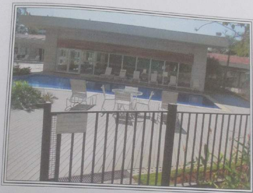
FOTO 18 : Outra vista da da área de piscinas existente no Condomínio Forte do Golf.
