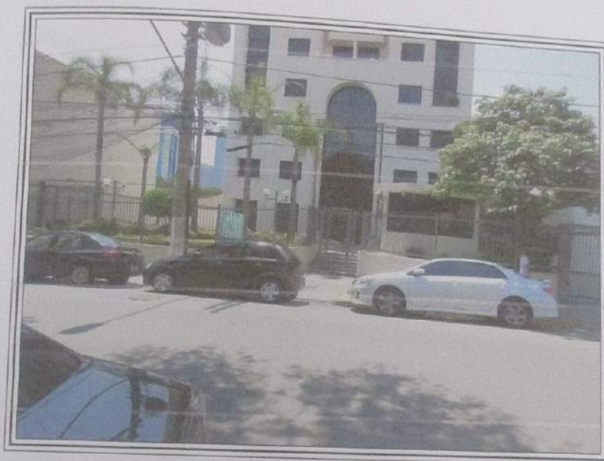
FOTO 143 : Vista parcial da portaria do Condomínio Edifício The Winner, localizada no nº 1300 da Rua Alexandre Dumas.
