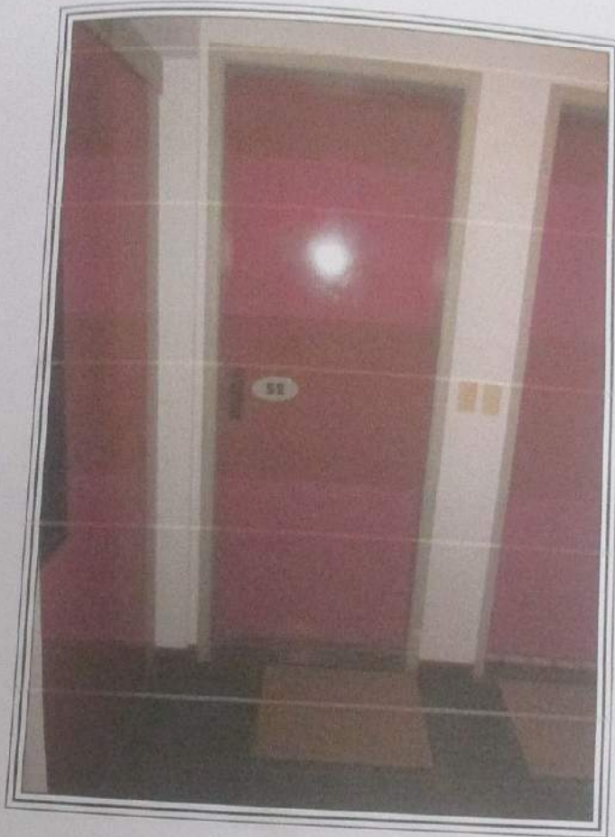
FOTO 156 : Vista da porta de acesso à unidade nº 52, ora avalianda, situada no 5º andar do edifício.
