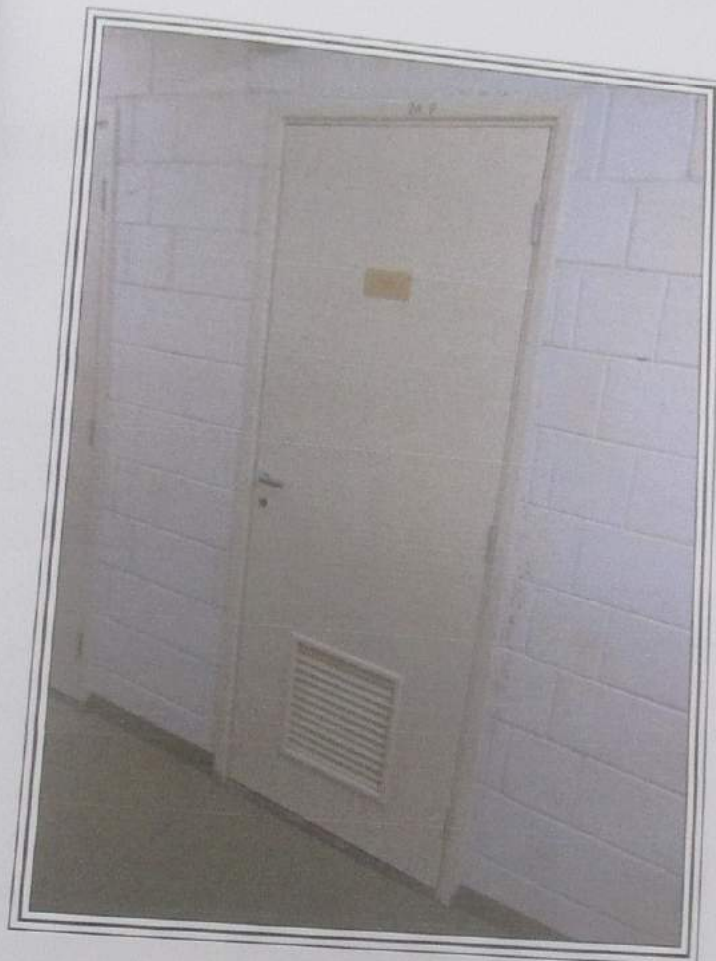
FOTO 138 : Vista parcial do depósito de uso da unidade nº 43 do Edifício Petúnia, ora avalianda.
