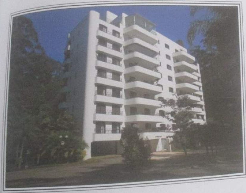
FOTO 69 : Outro ângulo do Edifício Spoleto, Bloco 4, em que se situa o a unidade nº 51, ora avalianda.
