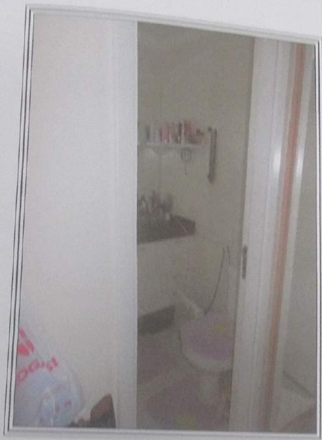
FOTO 43 : Vista parcial do banheiro da terceiro suite da unidade nº 201, ora avalianda.
