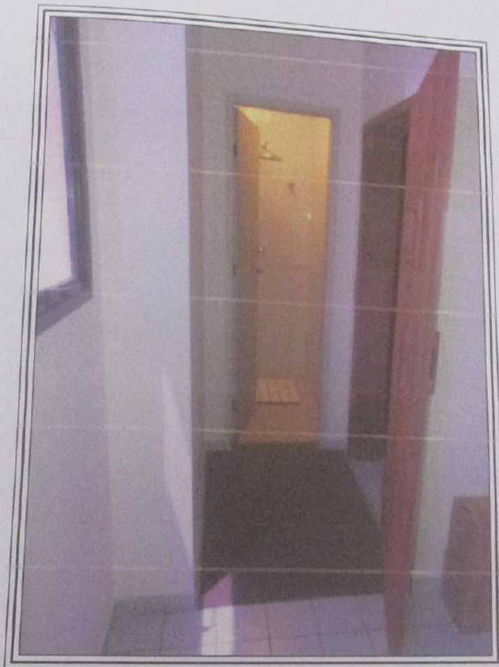
FOTO 152 : Vista parcial da sauna do Condomínio Edifício The Winner.
