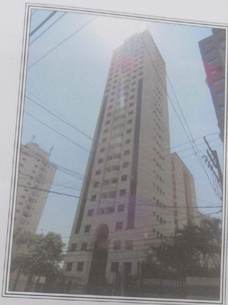
FOTO 140 : Vista do Condomínio Edifício The Winner, situado à Rua Alexandre Dumas, nº 1300.
