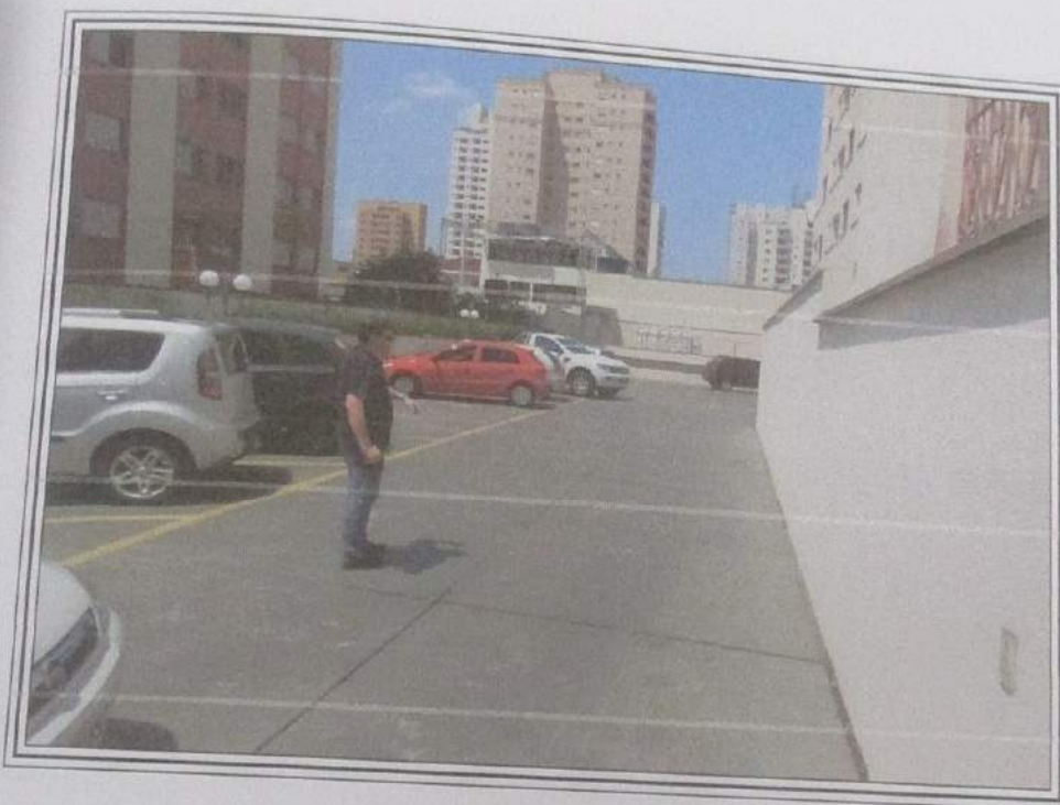
FOTO 146 : Outra vista interna do Condomínio Edifício The Winner, notando-se as vagas de garagem descobertas no pavimento térreo.
