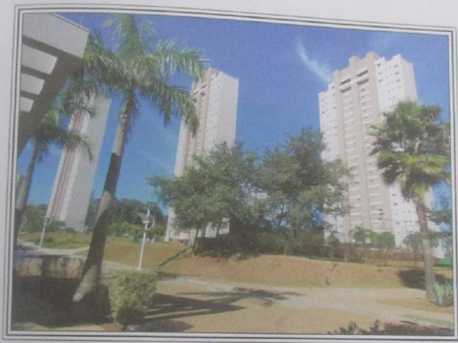
FOTO 04 : Outro ângulo interno do Condomínio Forte do Golf, notando-se três das sete torres existentes.
