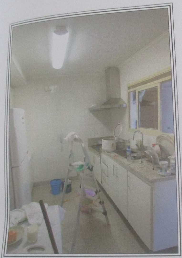
FOTO 80 : Vista parcial da cozinha da unidade nº 51, ora avalianda.
