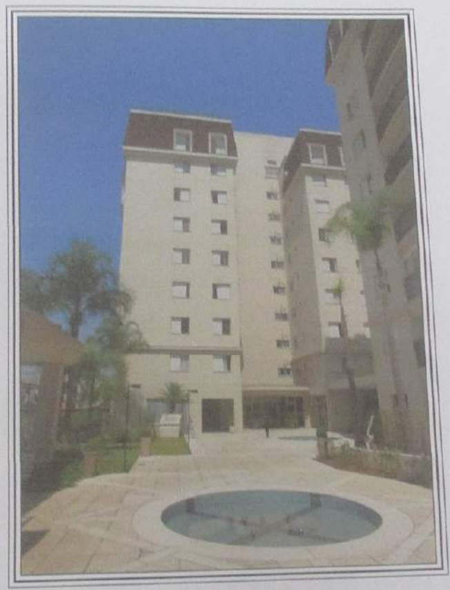
FOTO 114 : Vista parcial do Edifício Petúnia, Bloco 1, em que se situa a unidade nº 43, ora avalianda.
