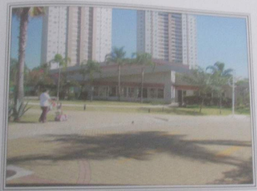
FOTO 28 : Vista parcial da casa clube existente no Condomínio Forte do Golf.
