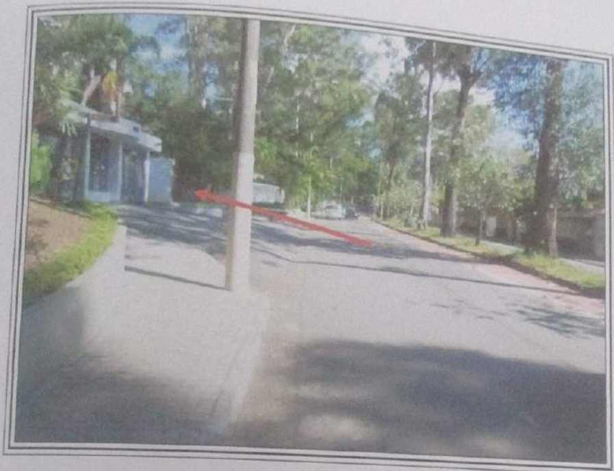
FOTO 49 : Vista parcial Av. Dr. Candido Mota Filho, notando-se o Condomínio Portal do São Francisco, à esquerda, onde apontado.
