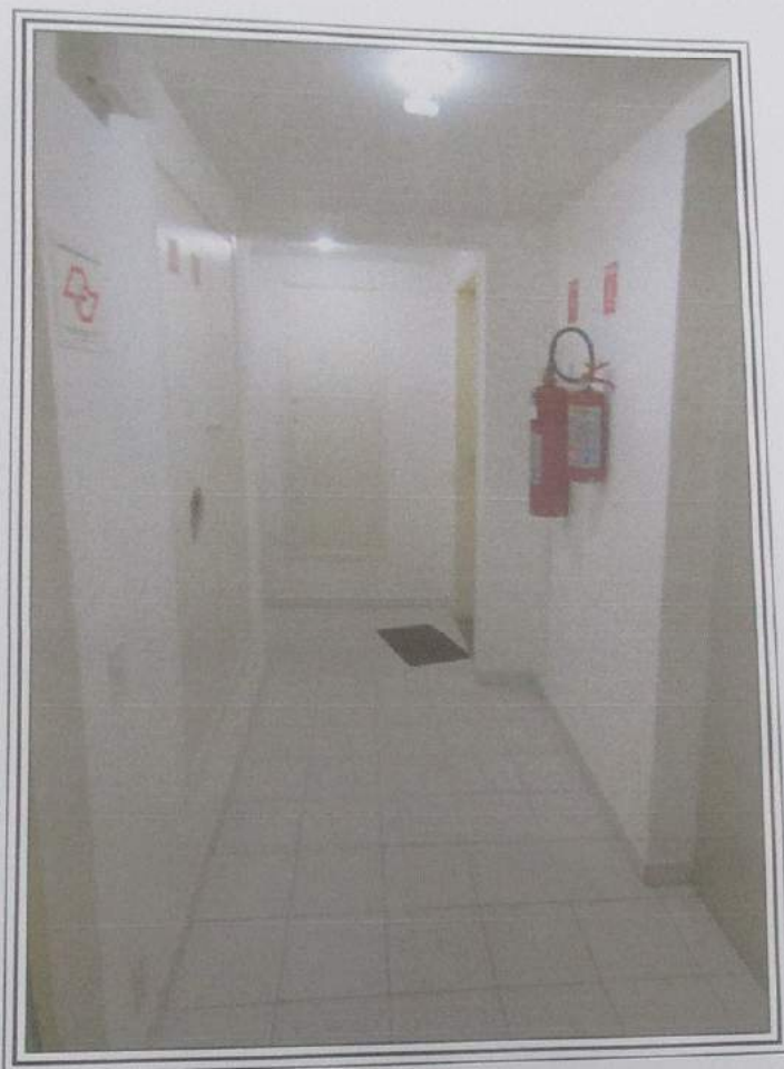
FOTO 117 : Vista parcial do hall social do 4º pavimento do Edifício Petúnia, no qual se situa a unidade, nº 43, ora avalianda.
