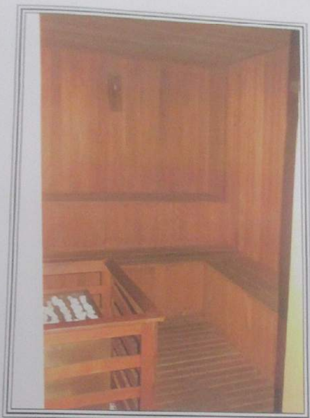
FOTO 24 : Vista parcial da sauna seca do Condomínio Forte do Golf.
