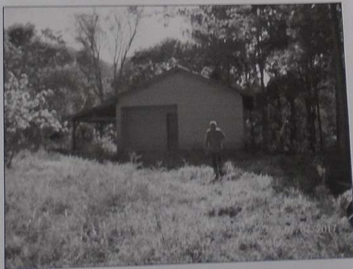
Foto 08 – Casa de Colono.
