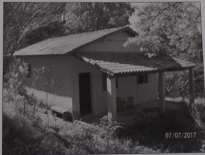
Foto 06 – Casa de Colono.
