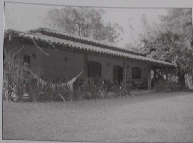
Foto 02 – Casa Sede – Fachada. Áreas avarandadas.
