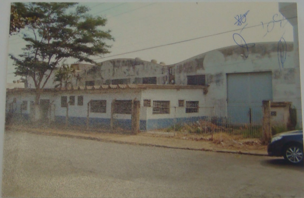
Vista da construção do tipo galpão industrial, localizado com frente para a Rua Rubens Rego Fontão, n.º 850, antiga rua das Industrias, bairro Parque Industrial, 1.ª Etapa.
