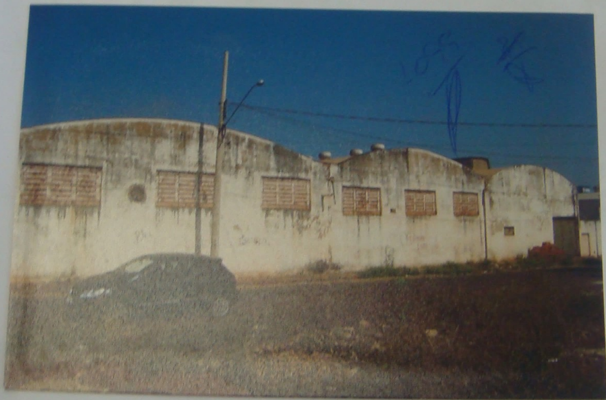
Vista da construção pela Rua Izamar, com um só pavimento, com a cobertura em arco e descrita detalhadamente no corpo do laudo.
