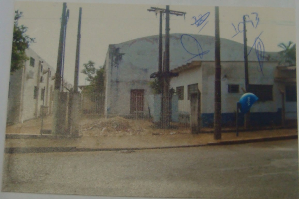
Vista da construção pelo lado esquerdo de quem de frente olha para o imóvel, com um só pavimento.
