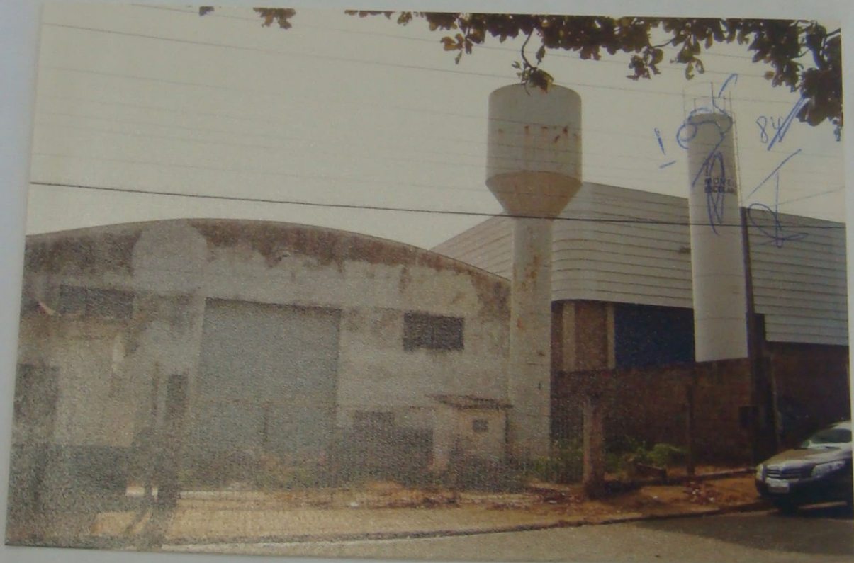
Vista da Rua Rubens Rego Fontão, com todos os melhoramentos públicos e parte de um dos galpões e o reservatório d'água elevado e metálico, que abastece o imóvel.
