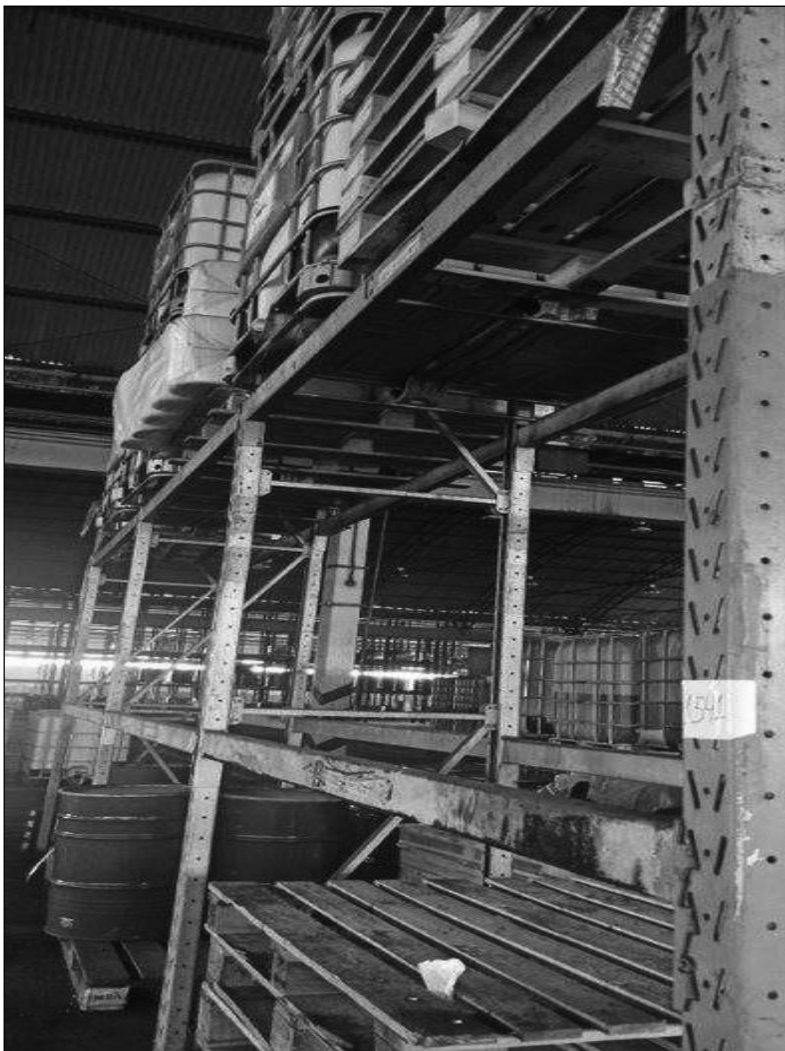
ITEM 1,024 – VISTA DA ESTANTE PORTA PALLETS, 8 PRATELEIRAS, 4 COLUNAS
