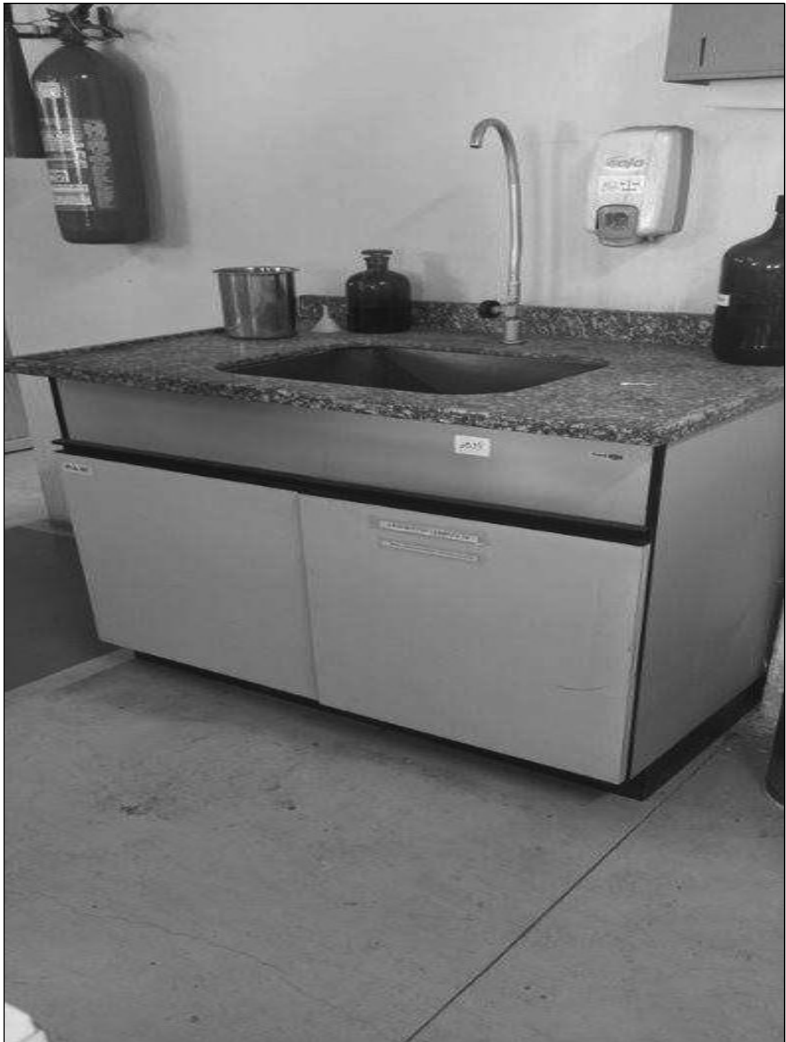
ITEM 1,182 – VISTA DO BALCAO DE MADEIRA, REVEST. EM LAMINADO MELAMINICO, 2 PORTAS, 1 PIA ACO INOX, DIM. 1.04 X 0.70 X 0.90 M
