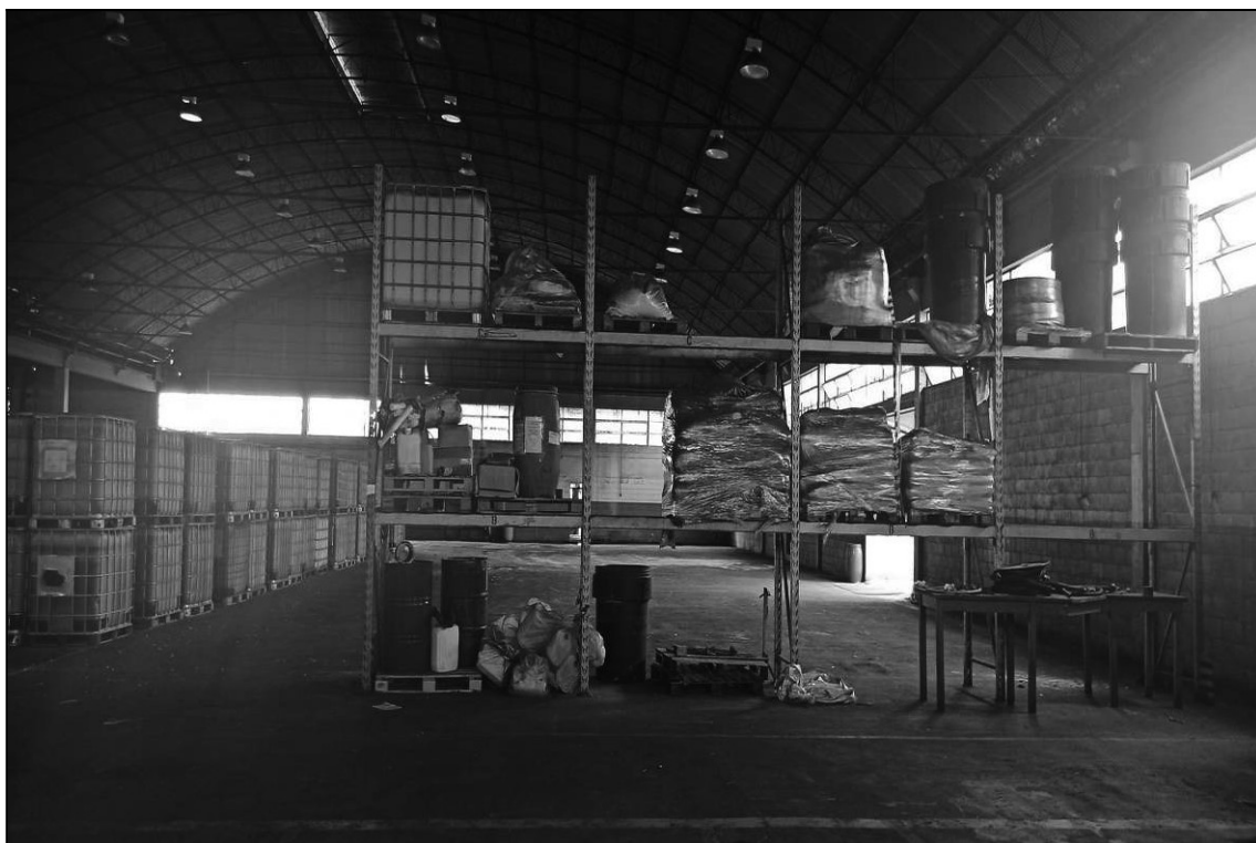
ITEM 1,023 – VISTA DA ESTANTE PORTA PALLETS, 10 PRATELEIRAS, 5 COLUNAS
