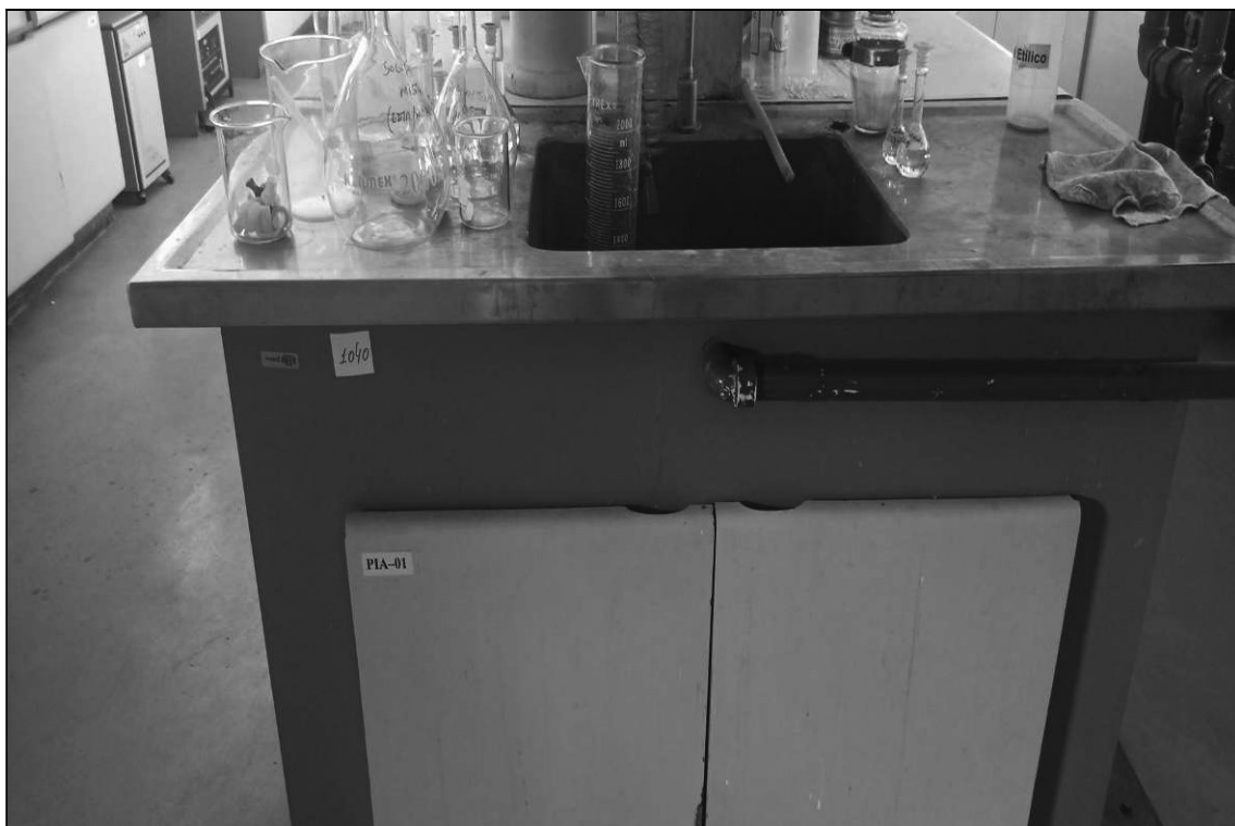
ITEM 1,184 – VISTA DA PIA COM TAMPO EM INOX, GABINETE EM MADEIRA, 2 PORTAS, DIM. 1.40 X 0.60 X 0.89 M
