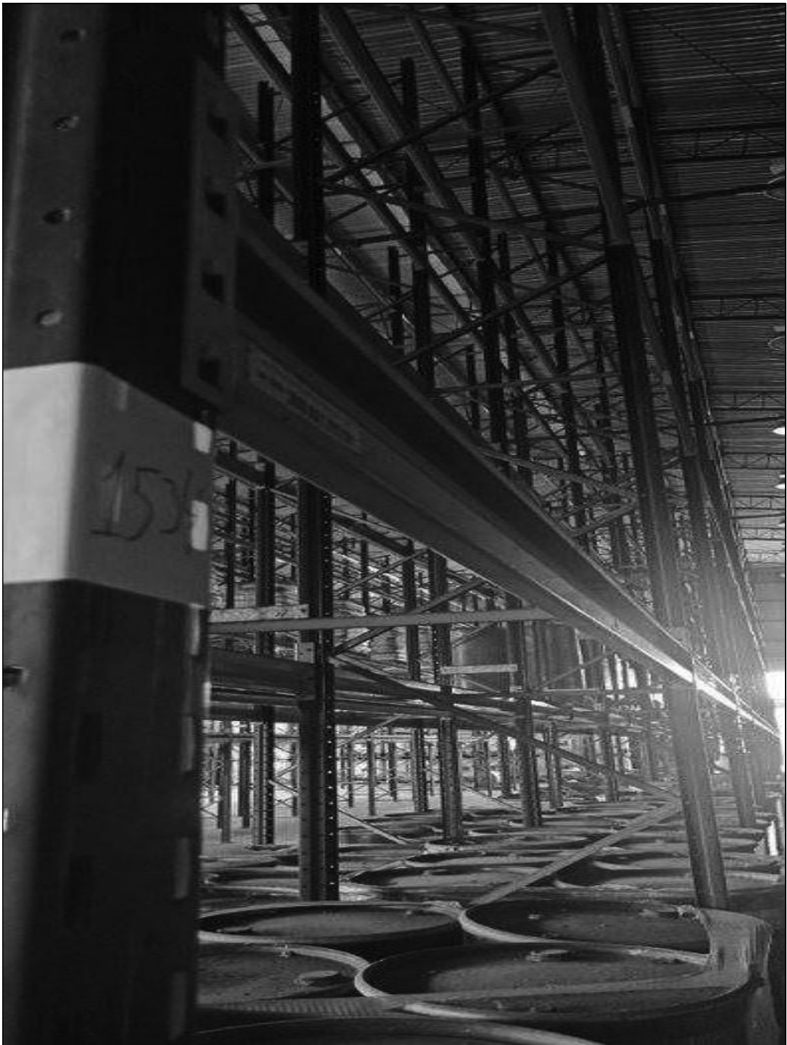
ITEM 1,017 – VISTA DA ESTANTE PORTA PALLETS, 52 PRATELEIRAS, 14 COLUNAS
