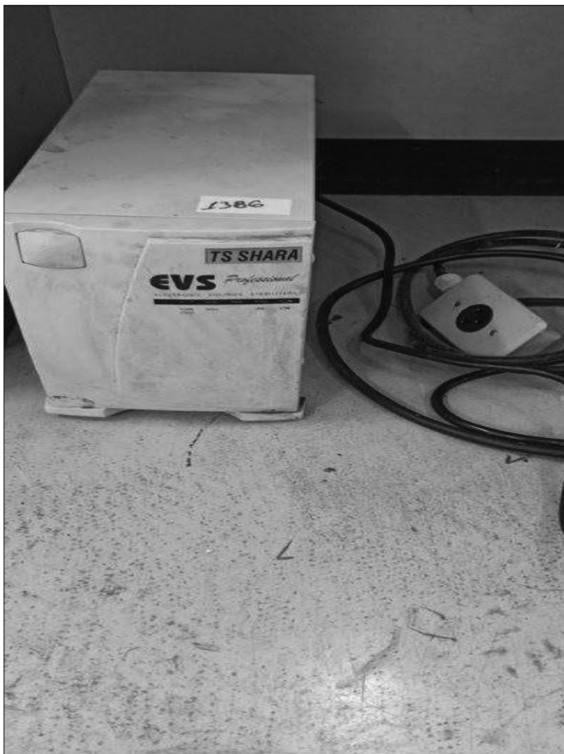
ITEM 1,235 – VISTA DO ESTABILIZADOR DE TENSAO, FAB. TS SHARA, MOD. EVS PROF 3000
