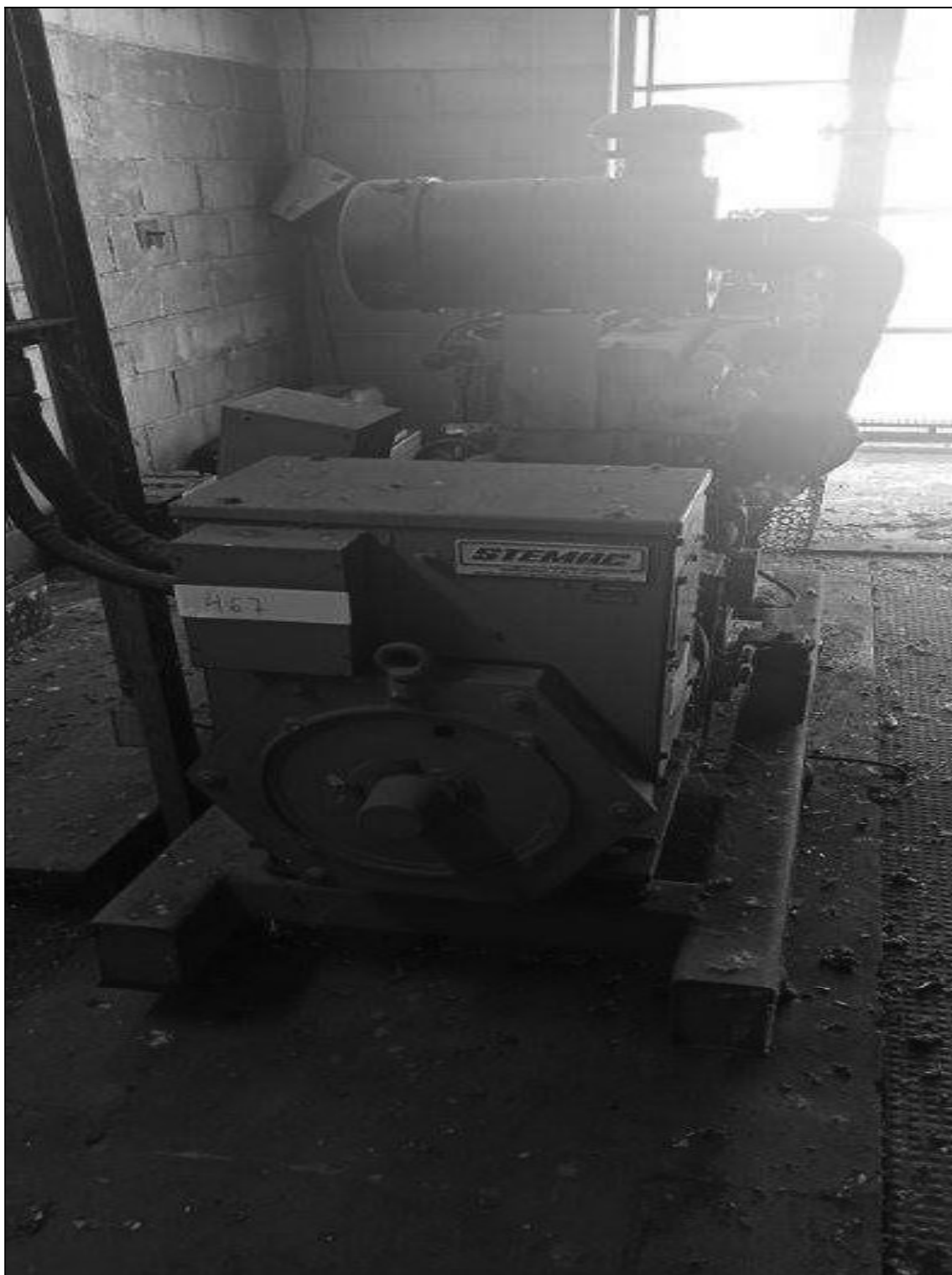
ITEM 1,152 – VISTA DO GRUPO DE GERADOR, FAB. STEMAC, 100/110 KVA, MOTOR PERKINS 6 CILINDROS, N. SERIE 110086795
