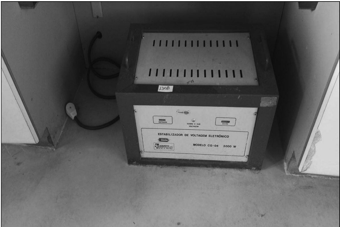
ITEM 1,191 – VISTA DO ESTABILIZADOR DE TENSAO, FAB. CS, MOD. CG-04, 3000 W
