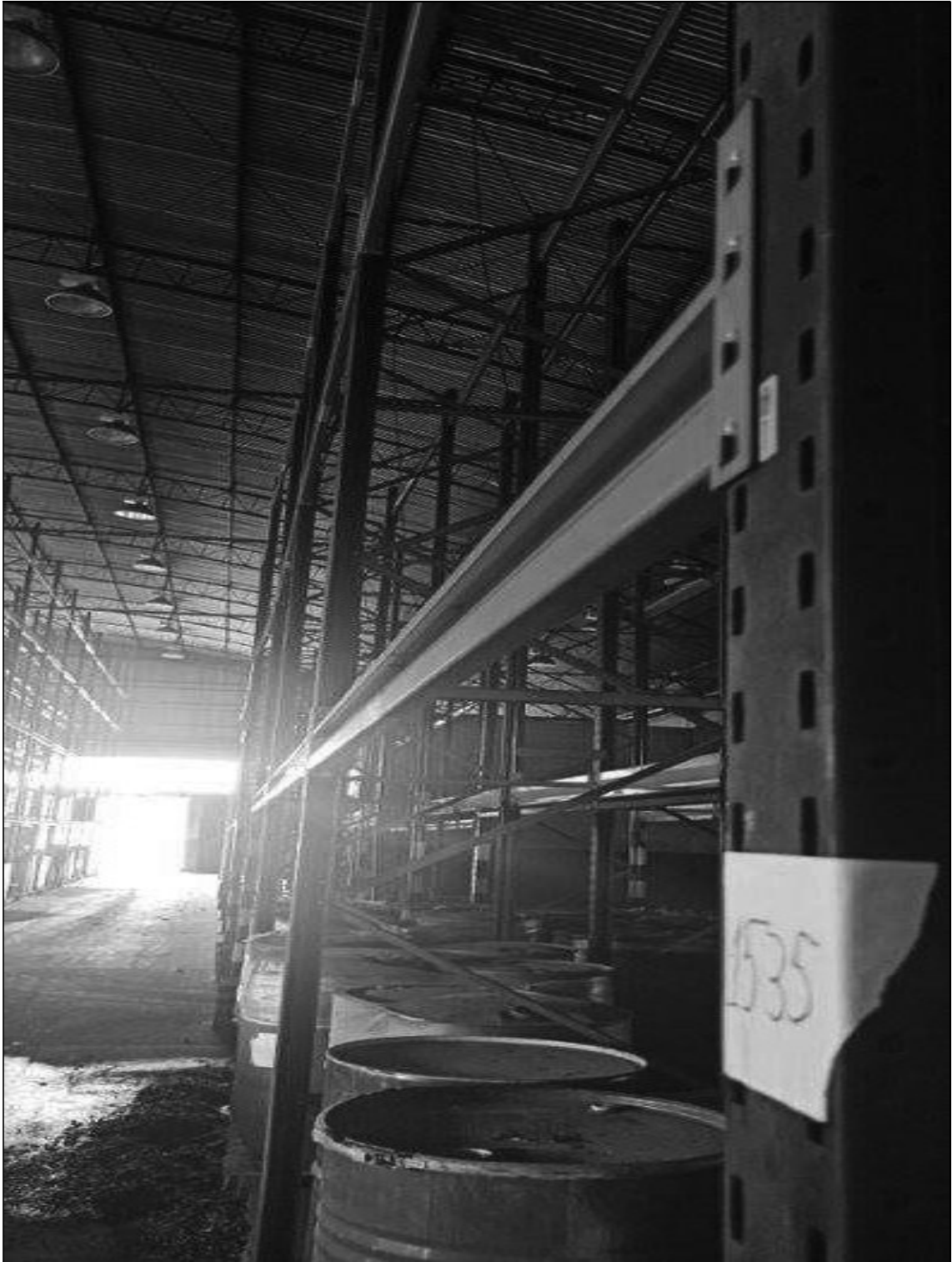
ITEM 1,018 – VISTA DA ESTANTE PORTA PALLETS, 35 PRATELEIRAS, 14 COLUNAS
