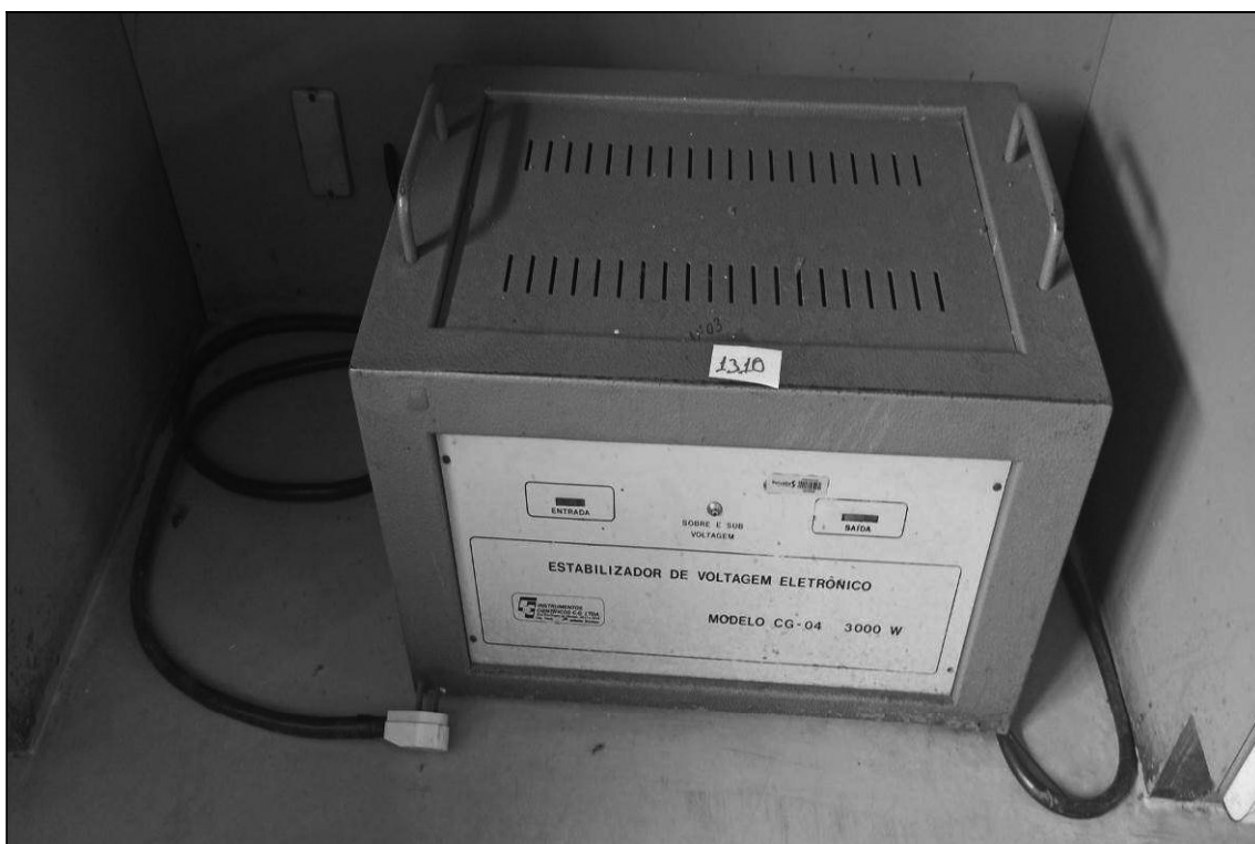
ITEM 1,193 – VISTA DO ESTABILIZADOR DE TENSAO, FAB. CS, MOD. CG-04, 3000 W
