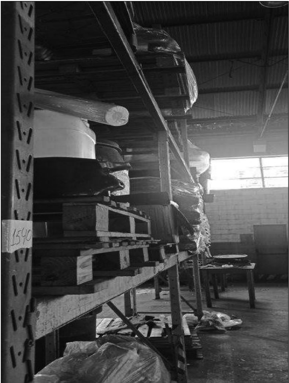
ITEM 1,023 – VISTA DA ESTANTE PORTA PALLETS, 10 PRATELEIRAS, 5 COLUNAS
