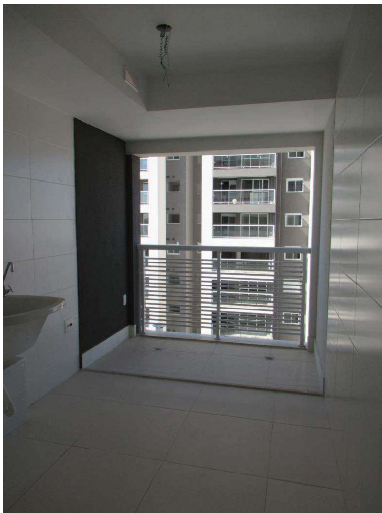
Foto nº. 42 – Vista da área de serviço.
