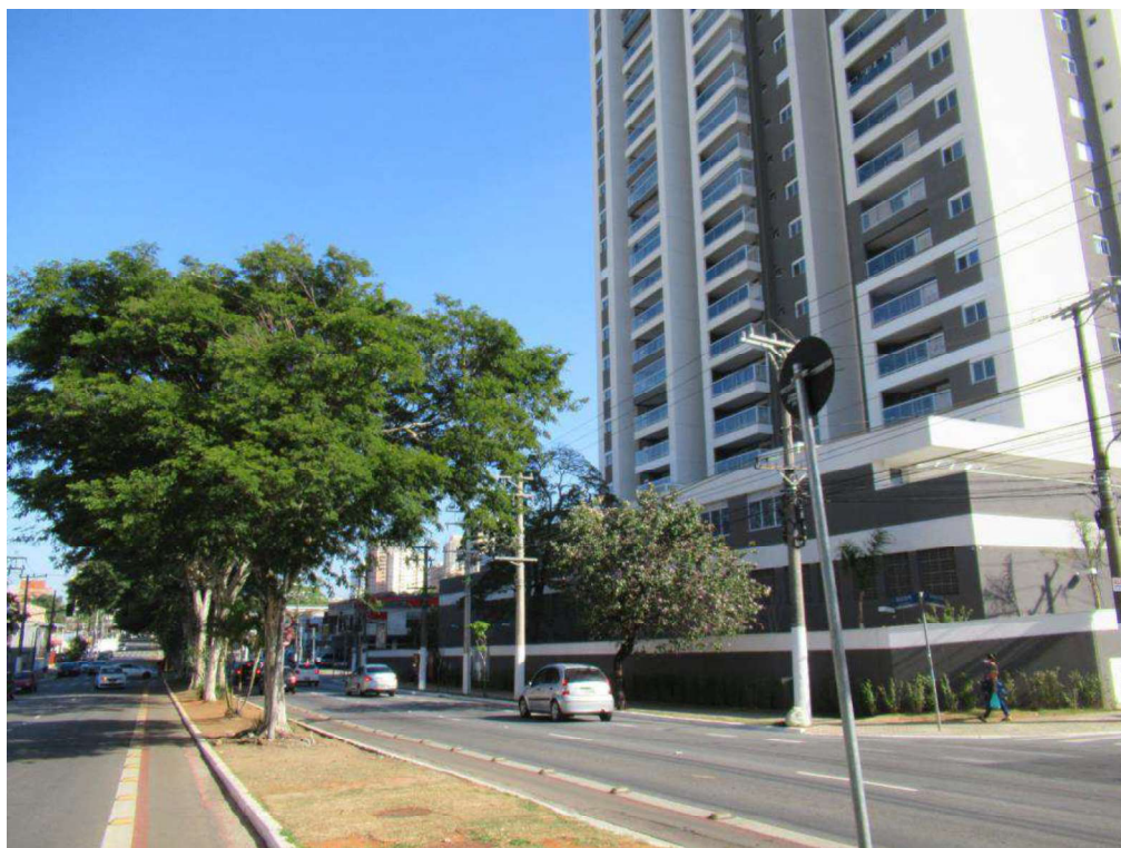
Foto nº. 1 – Vista da Avenida Nazaré, onde se localiza o imóvel avaliado no presente laudo.
