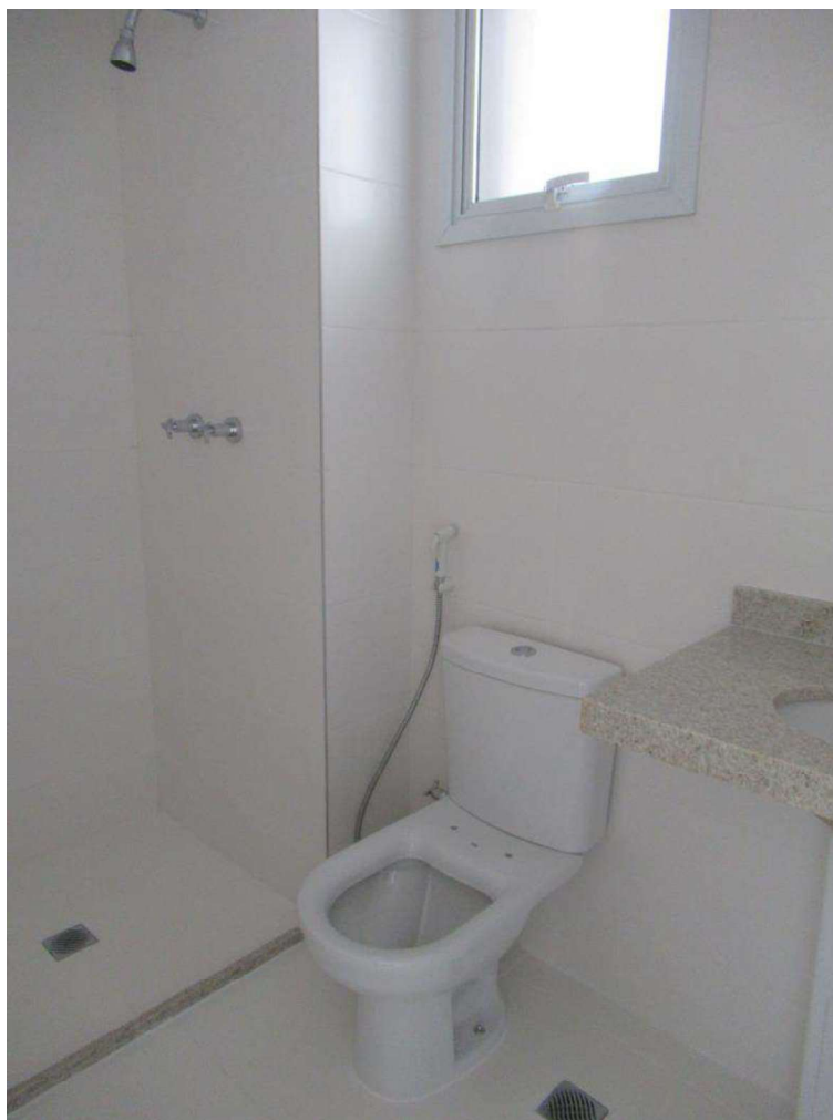
Foto nº. 39 – Vista do banheiro social.
