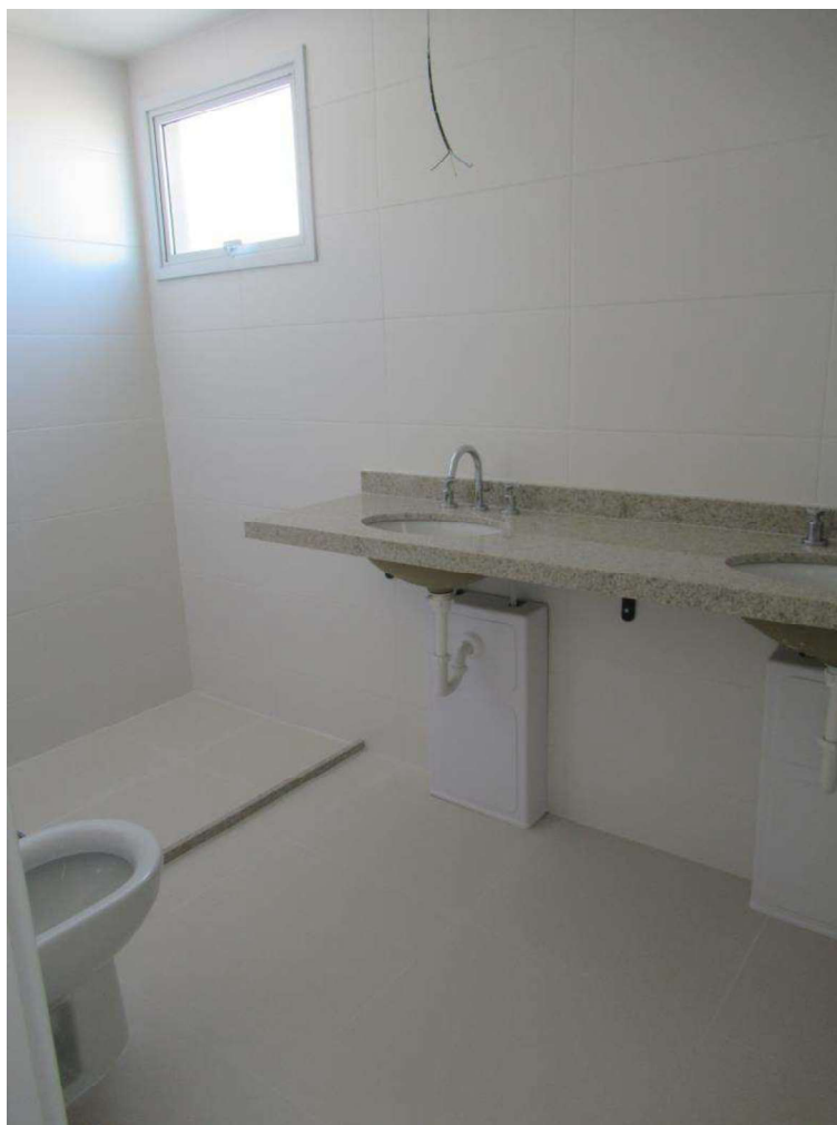
Foto nº. 34 – Vista do banheiro suíte 1.
