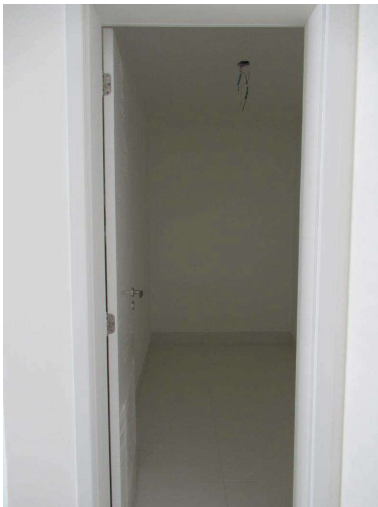
Foto nº. 43 – Vista do dormitório de serviço.
