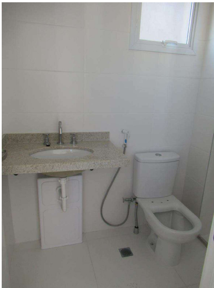
Foto nº. 36 – Vista do banheiro suíte 2.
