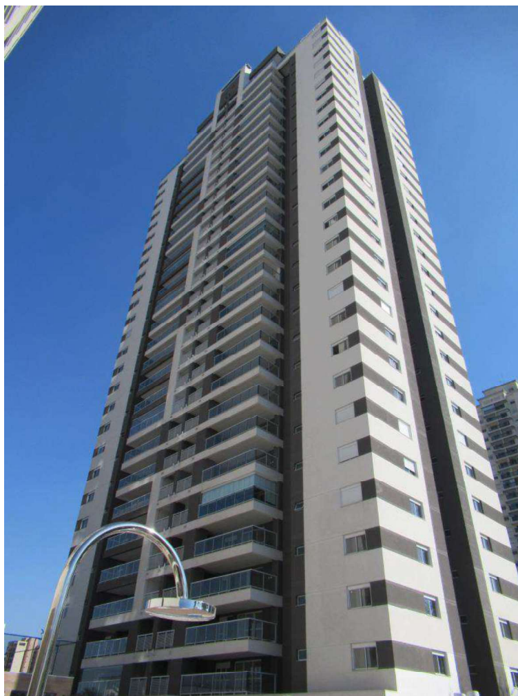
Foto nº. 4 – Vista da fachada do Edifício Paineira, onde se localiza o imóvel avaliado no presente laudo.
