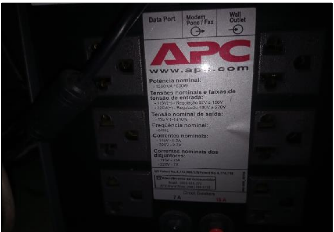
ITEM 3,013 - VISTA DA PLACA DE IDENTIFICAÇÃO DO NOBREAK APC BACK UPS RS 1200
