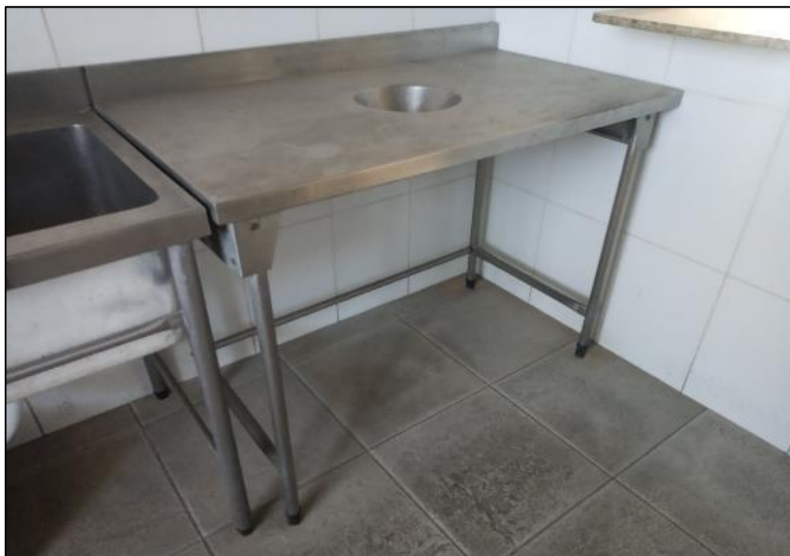
ITEM 2,020 - VISTA DA BANCADA INOX PARA LIXO
