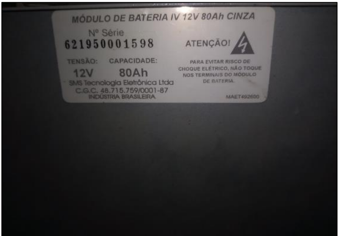
ITEM 3,015 - VISTA DA PLACA DE IDENTIFICAÇÃO DO MÓDULO DE BATERIA SMS SÉRIE: 621950001598
