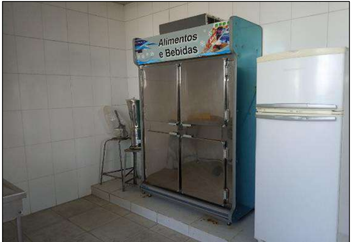
ITEM 2,031 - VISTA DA GELADEIRA INOX 4 PORTAS
