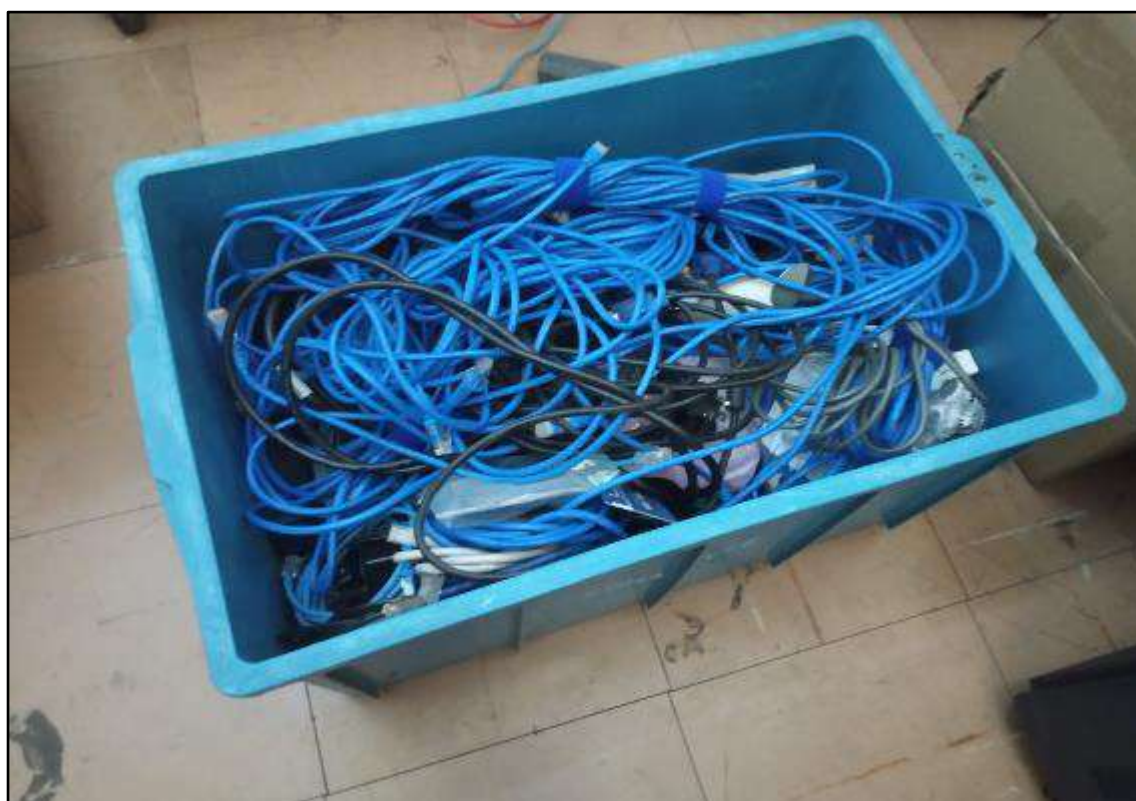
ITEM 3,100 - VISTA DA CAIXA COM CABOS DE REDE
