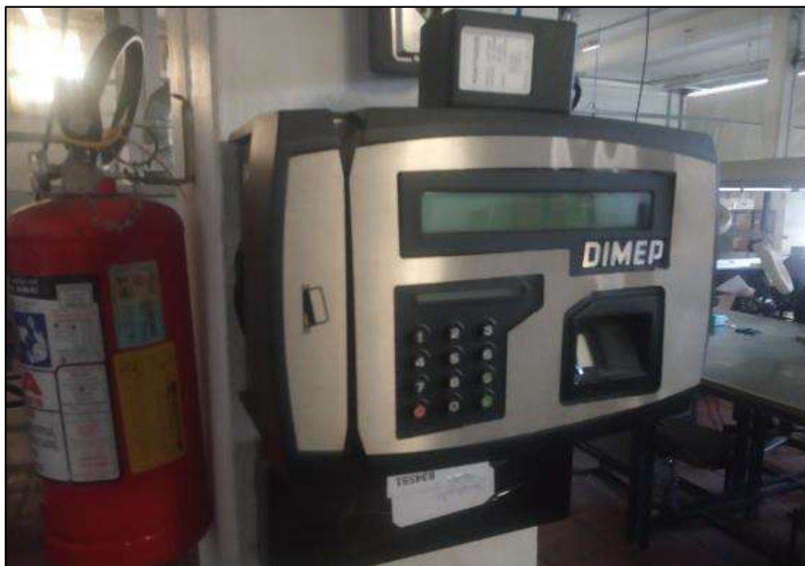
ITEM 3,129 - VISTA DO RELÓGIO DE PONTO DIMEP
