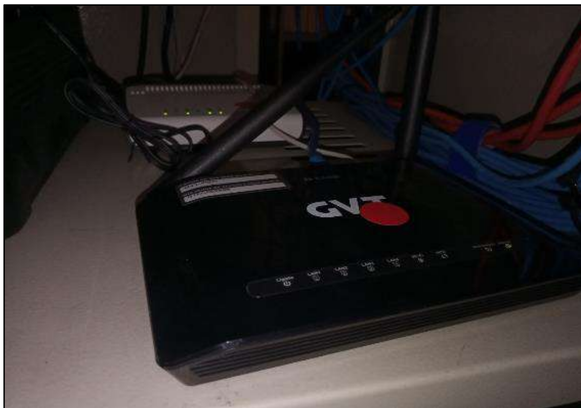
ITEM 3,050 - VISTA DO ROTEADOR D-LINK DSL 2740 E
