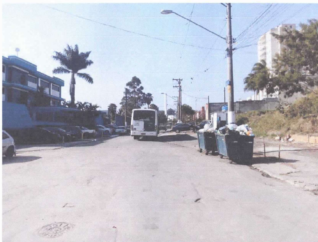
Foto nº 01 – Vista da Rua Serra Redonda, no trecho onde se localiza o imóvel objeto da presente ação.
