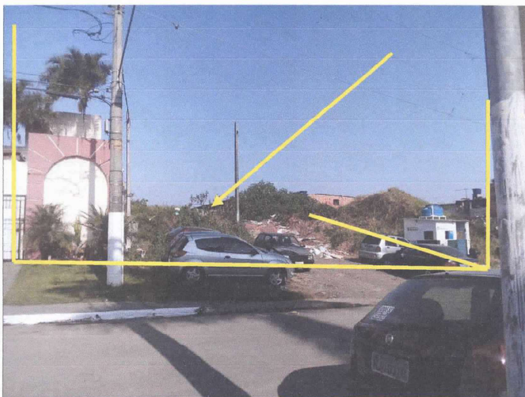
Foto nº 03 – Vista da fachada do imóvel, objeto da presente ação.
