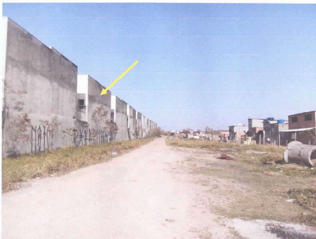
Foto n° 05 – Vista interna do terreno, note-se a esquerda do terreno as construções do condomínio sobre a área do imóvel, objeto da presente ação.
