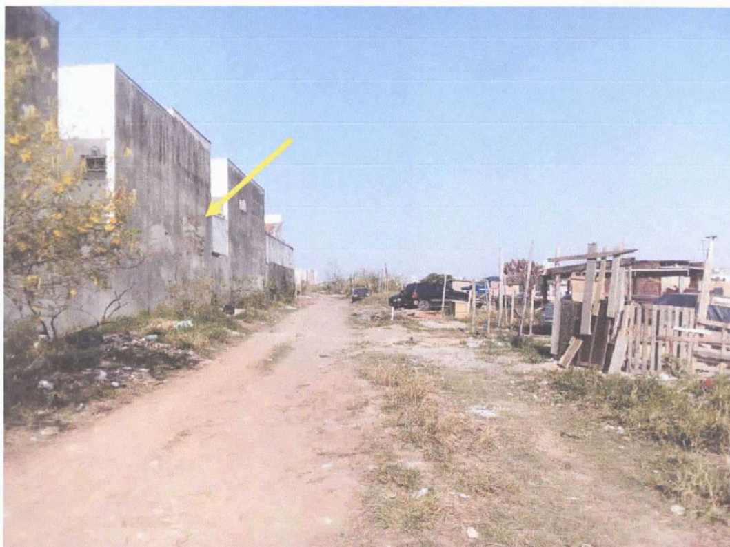
Foto n° 07 – Vista do imóvel, note-se a esquerda do terreno as construções do condomínio sobre a área do imóvel, objeto da presente ação.
