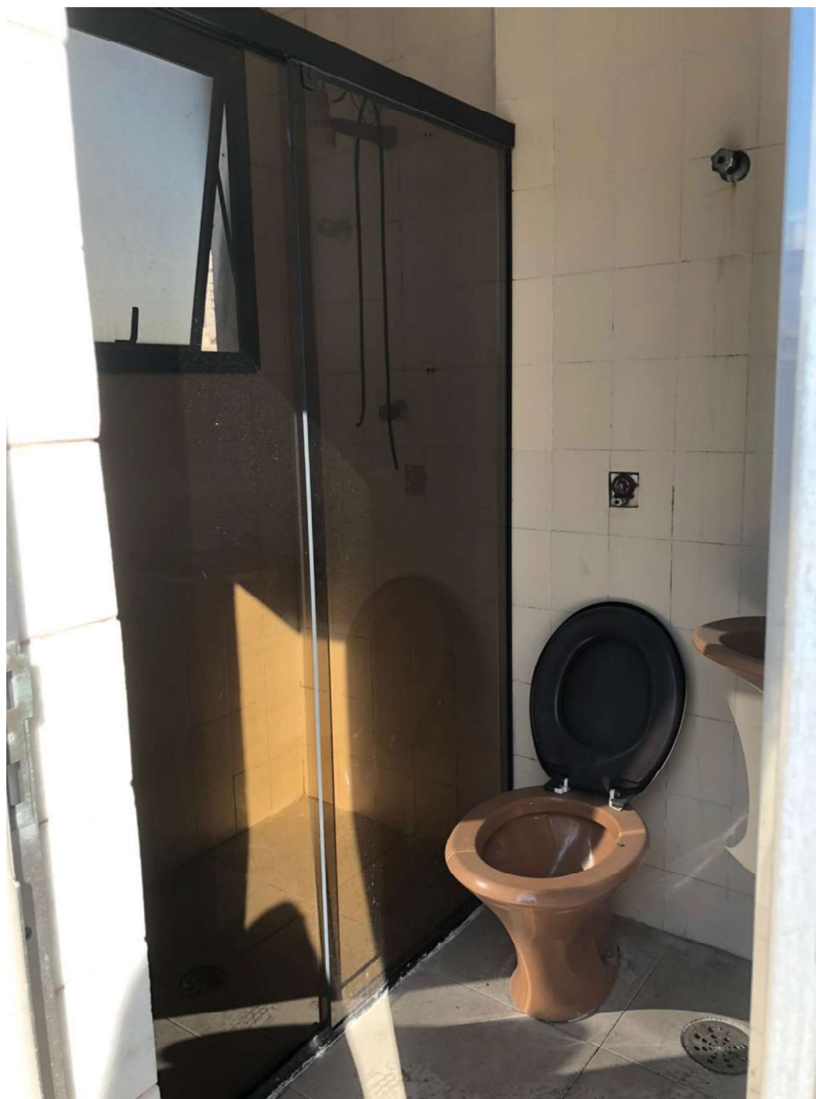
FOTO N o 42 – Vista do banheiro externo junto à piscina.
