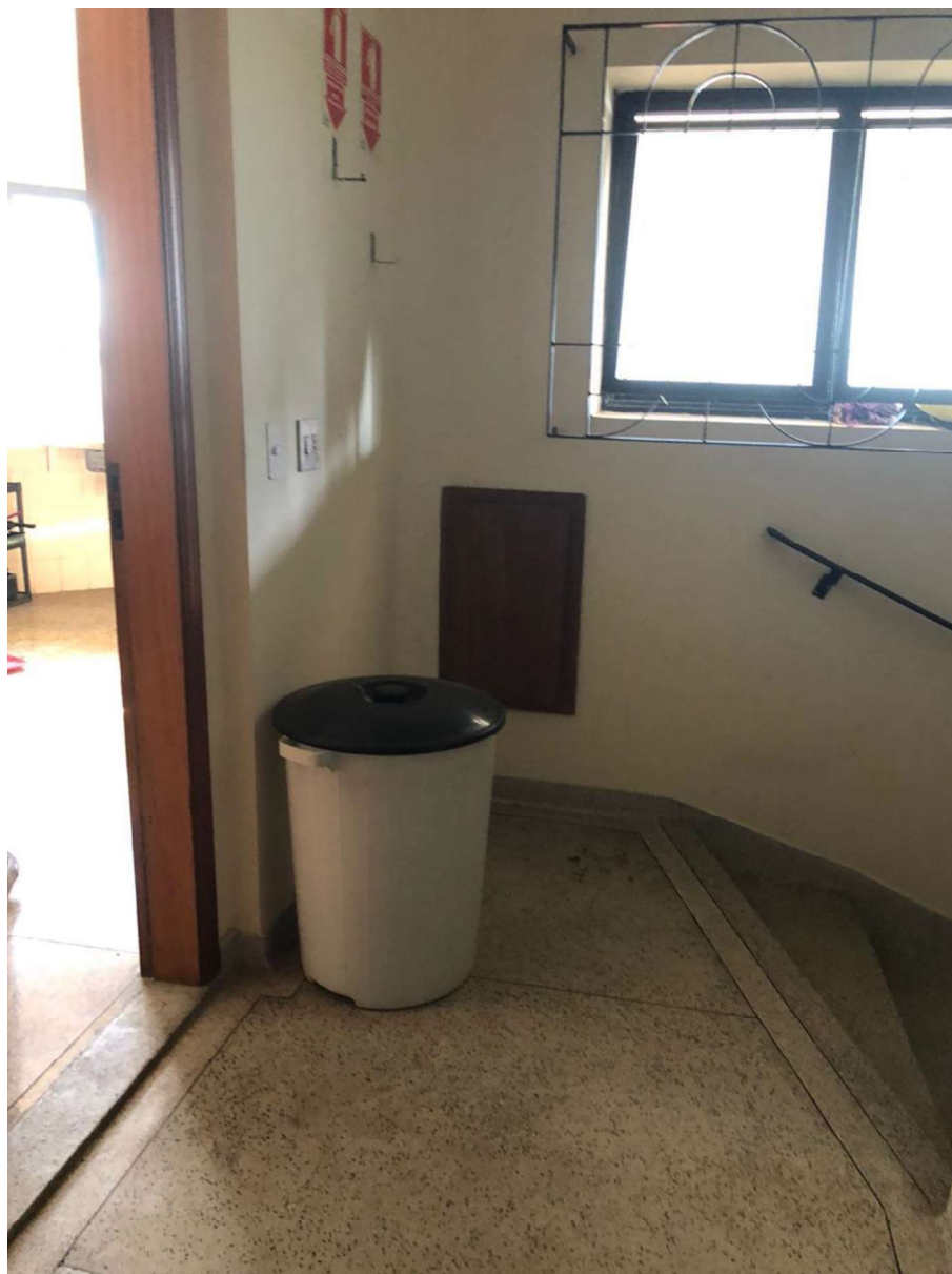
FOTO Nº 7 - Vista da entrada de serviço da unidade.
