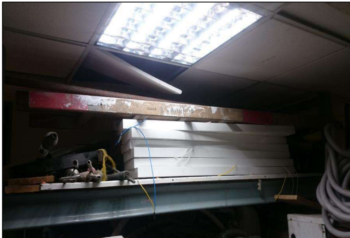
ITEM 5,074 - VISTA DA ESCADA DE MADEIRA
