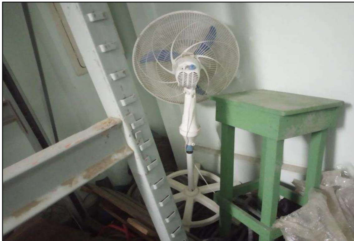
ITEM 2,007 - VISTA DO VENTILADOR DE COLUNA
