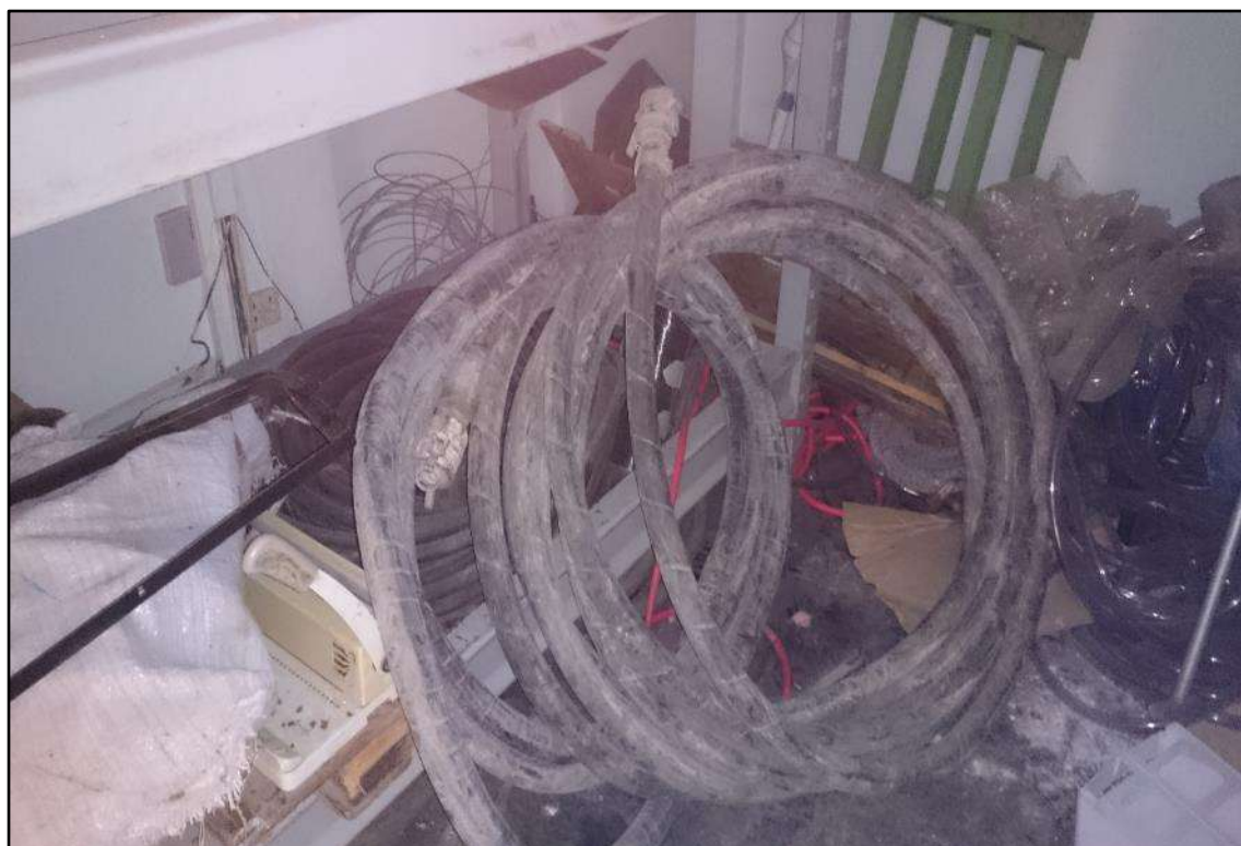
ITEM 5,075 - VISTA DA MANGUEIRA DE AR COMPRIMIDO
