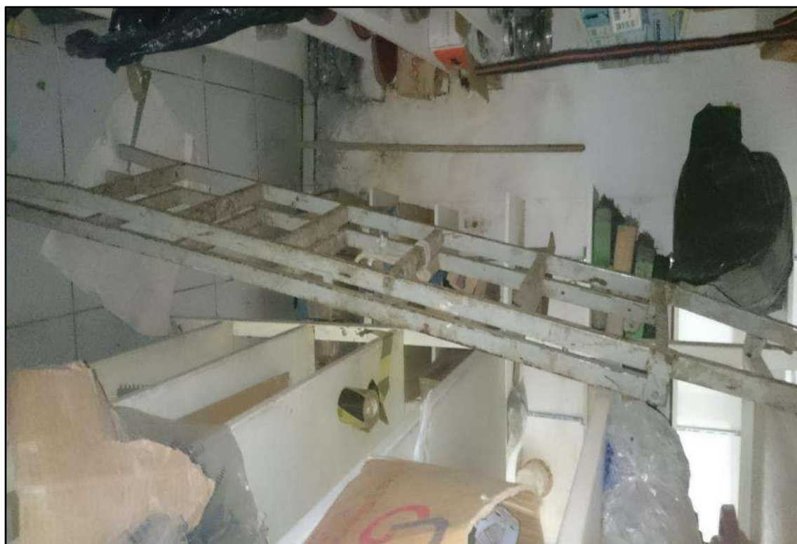
ITEM 5,062 - VISTA DA ESCADA DE FERRO
