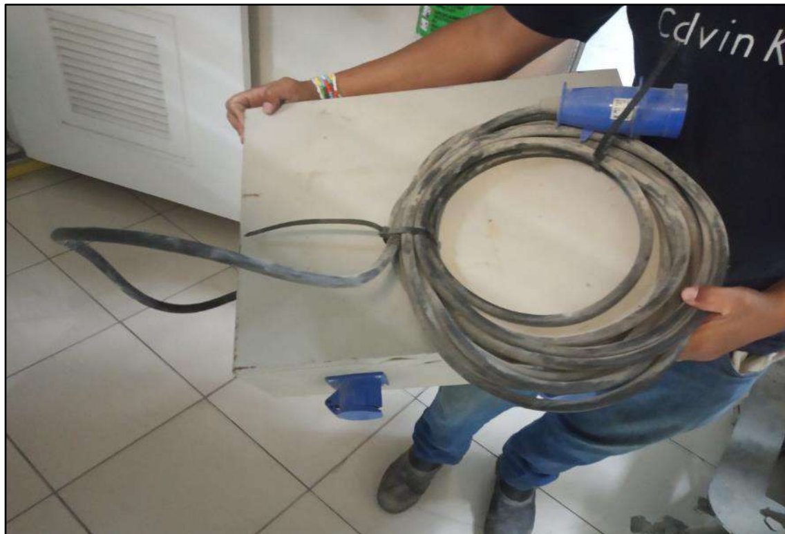
ITEM 1,011 - VISTA DO QUADRO DE LUZ
