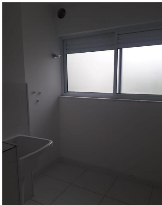
VISTA DO PADRÃO CONSTRUTIVO DA ÁREA DE SERVIÇO.
