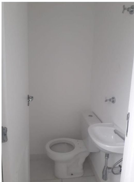
VISTA DO PADRÃO CONSTRUTIVO DO BANHEIRO.
