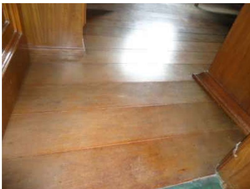
Assoalho de madeira presente nos dormitórios
