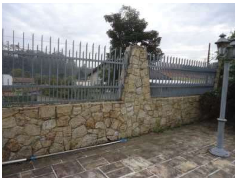
Muros (arrimo) altos para a Rua Jandaia
