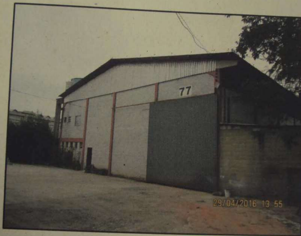
Vista frontal do galpão
