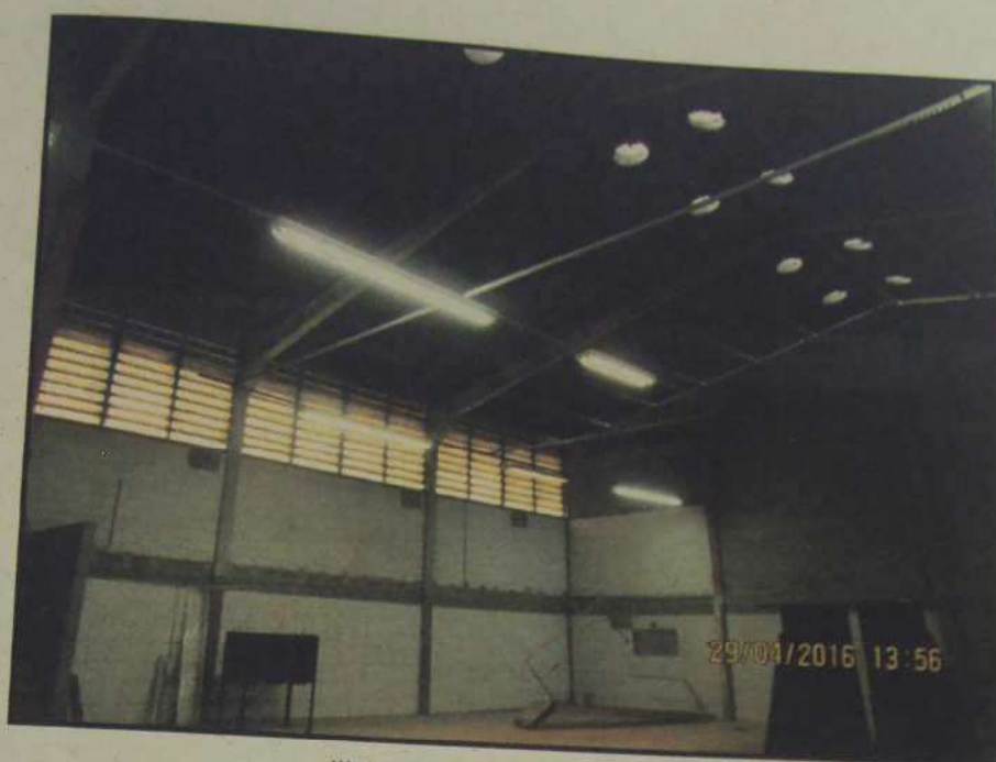
Vista da área principal do galpão
