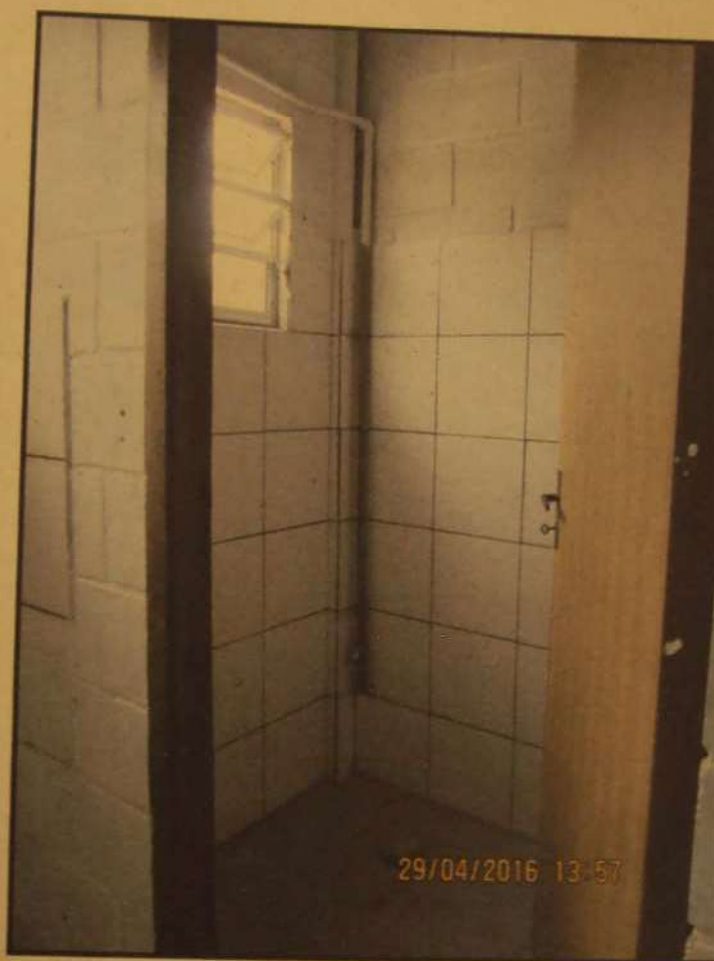
Vista interna do lavabo - área administrativa
