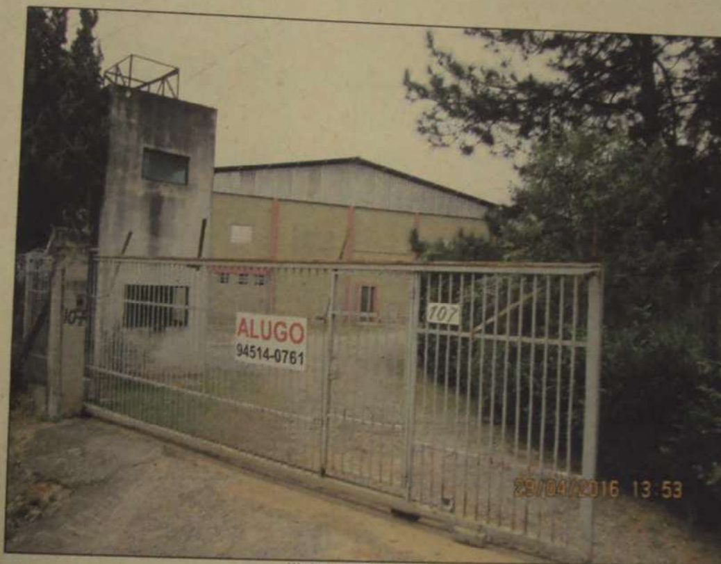
Vista frontal do imóvel
