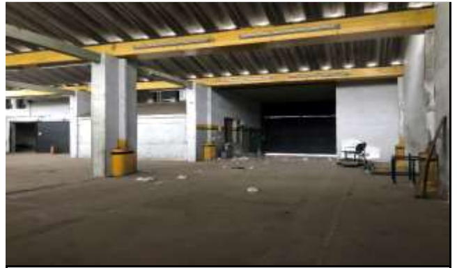
Aspecto do galpão
