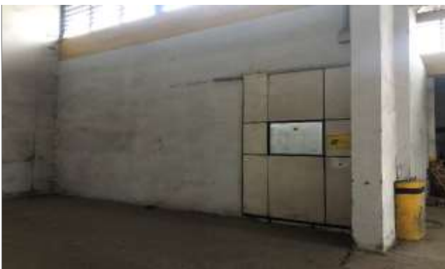
Aspecto do galpão
