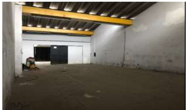
Aspecto do galpão
