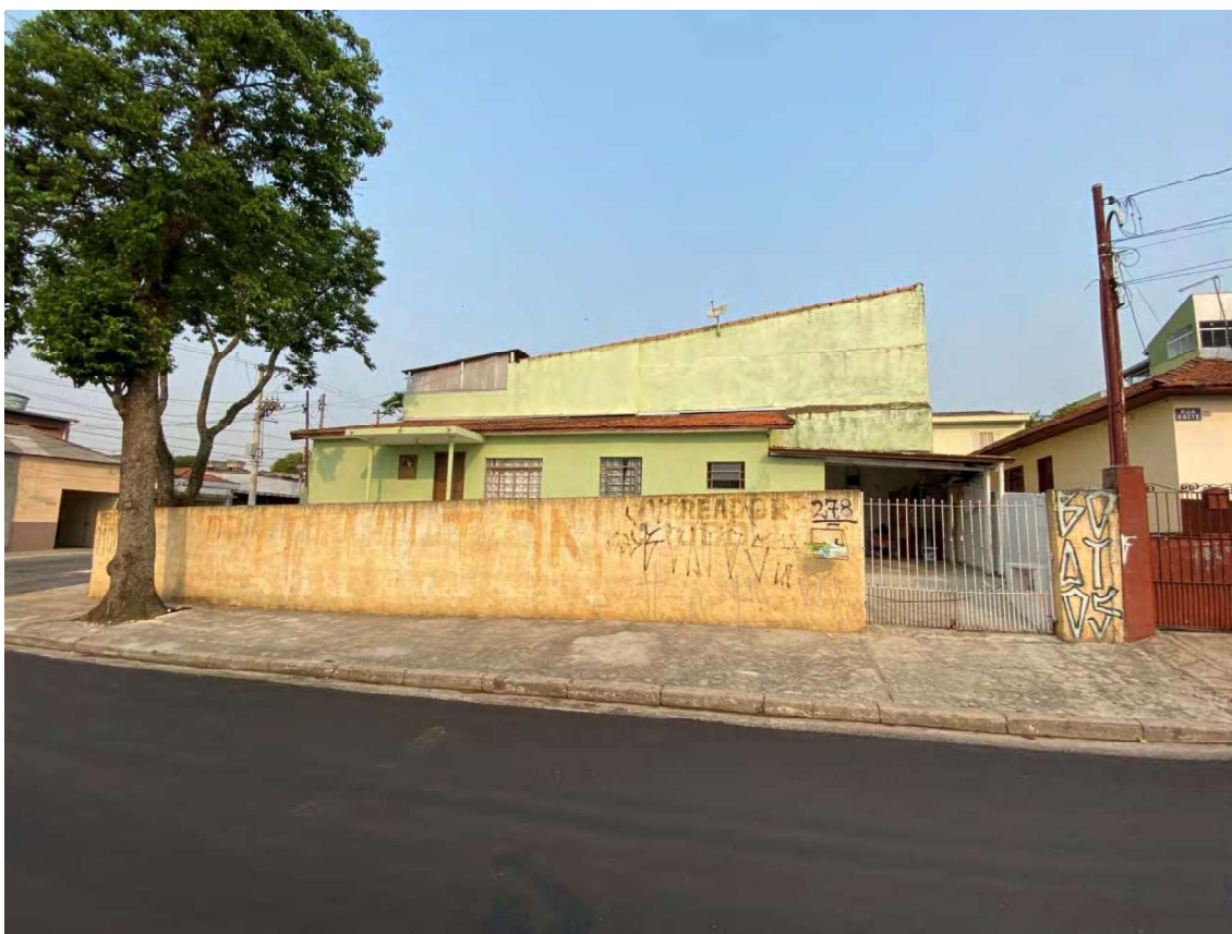
Foto 05: Vista da fachada desde Rua Odete.
