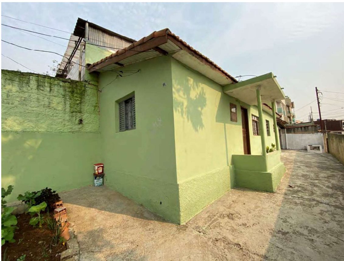
Foto 07: Vista da fachada desde o quintal.
