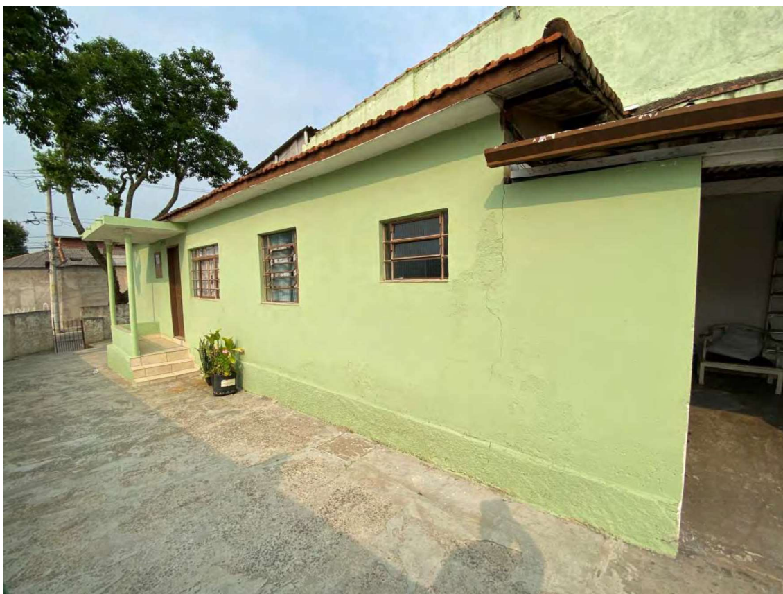
Foto 06: Vista da fachada desde o quintal.
