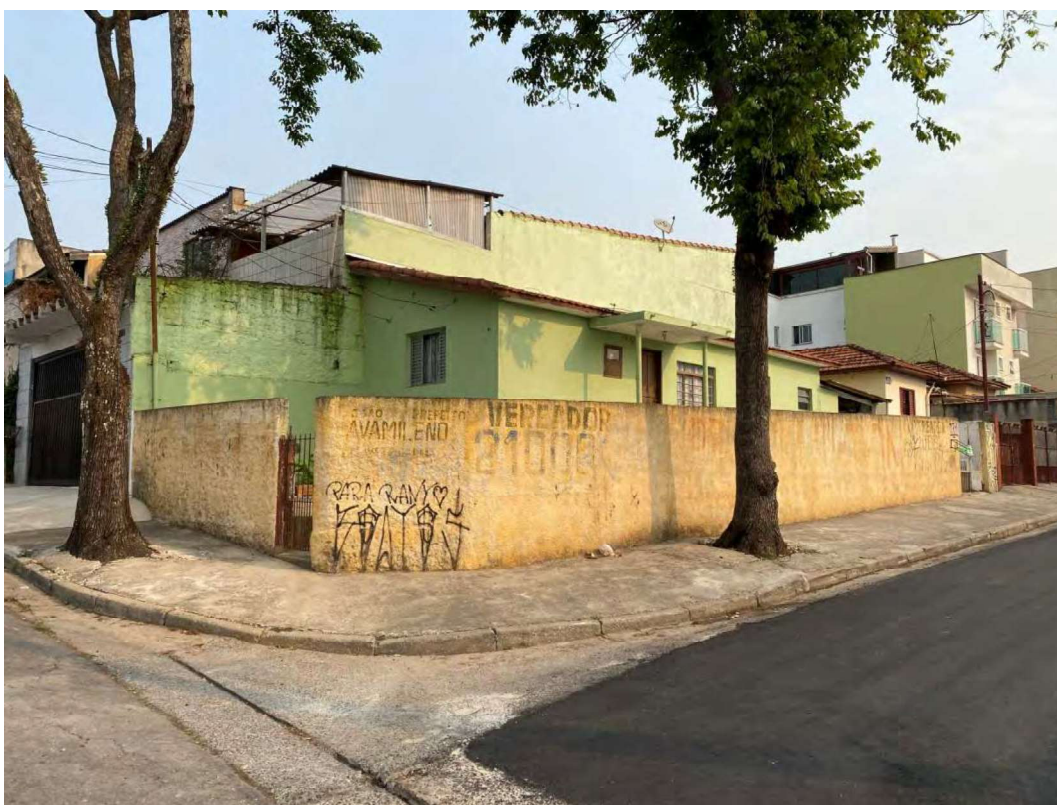
Foto 01: Vista da fachada desde esquina entre Rua Conde de Sarzedas e Rua Odete.
