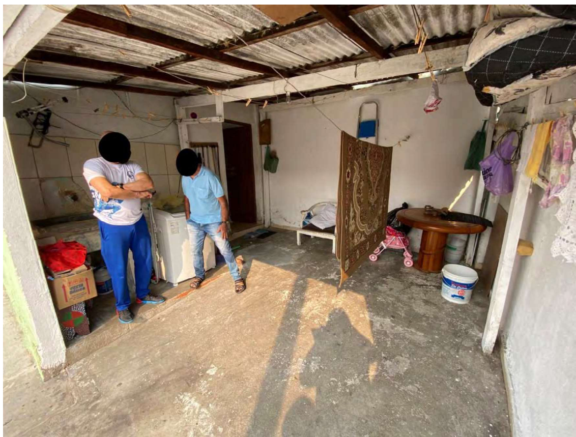
Foto 09: Vista da garagem e área de serviço.
