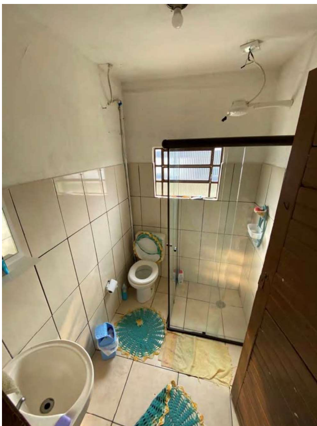
Foto 12: Vista do banheiro.
