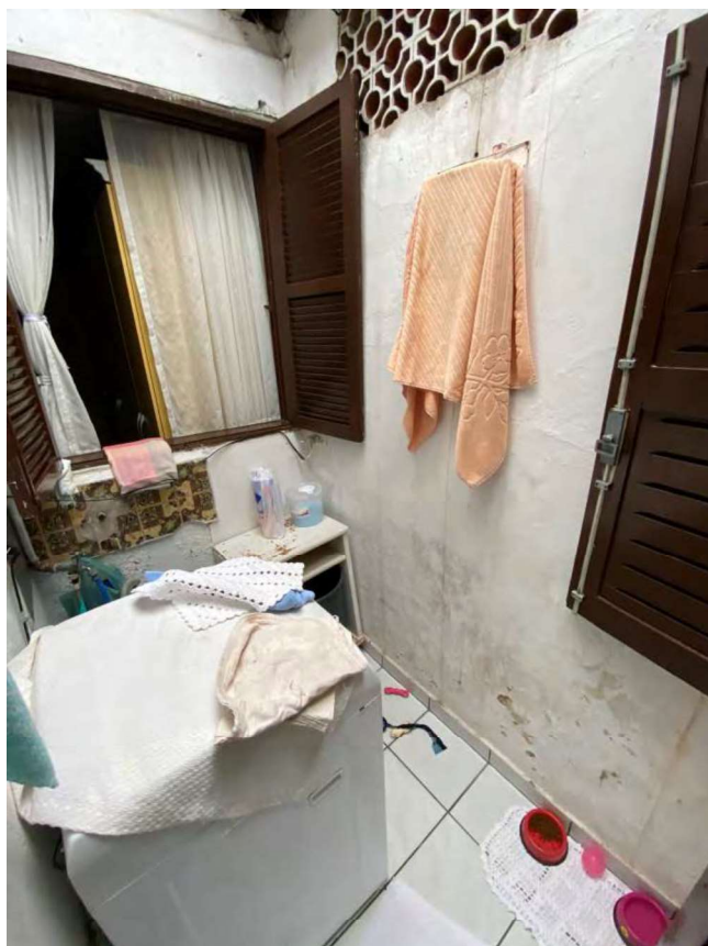
Foto 27: Vista da área de serviço.
