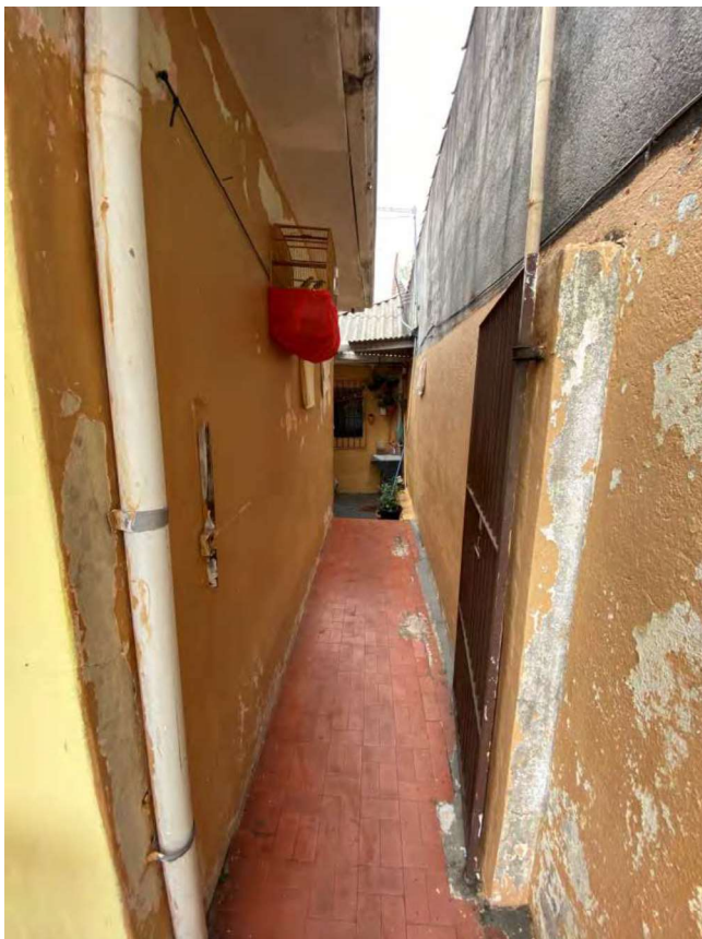
Foto 14: Vista do corredor lateral.
