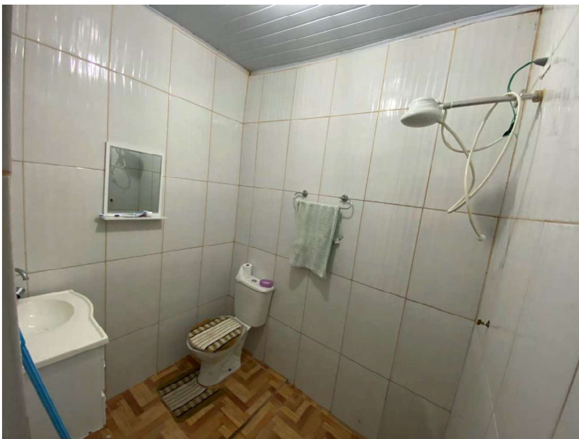
Foto 12: Vista do banheiro.
