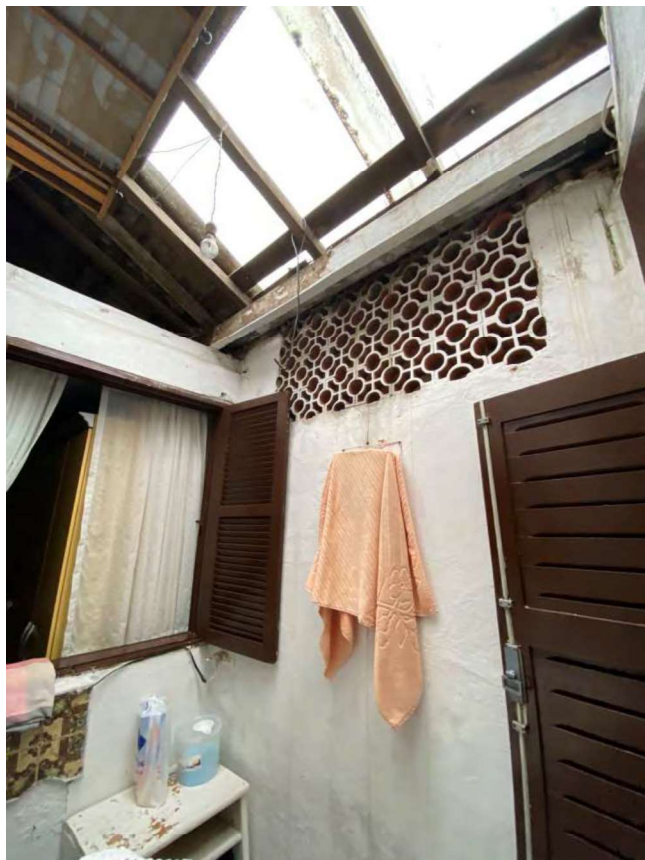
Foto 28: Vista da área de serviço.
