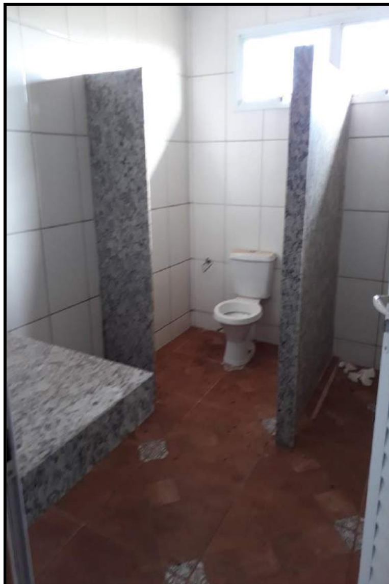
Foto 44 – vista do imóvel 02 – barracão 01
