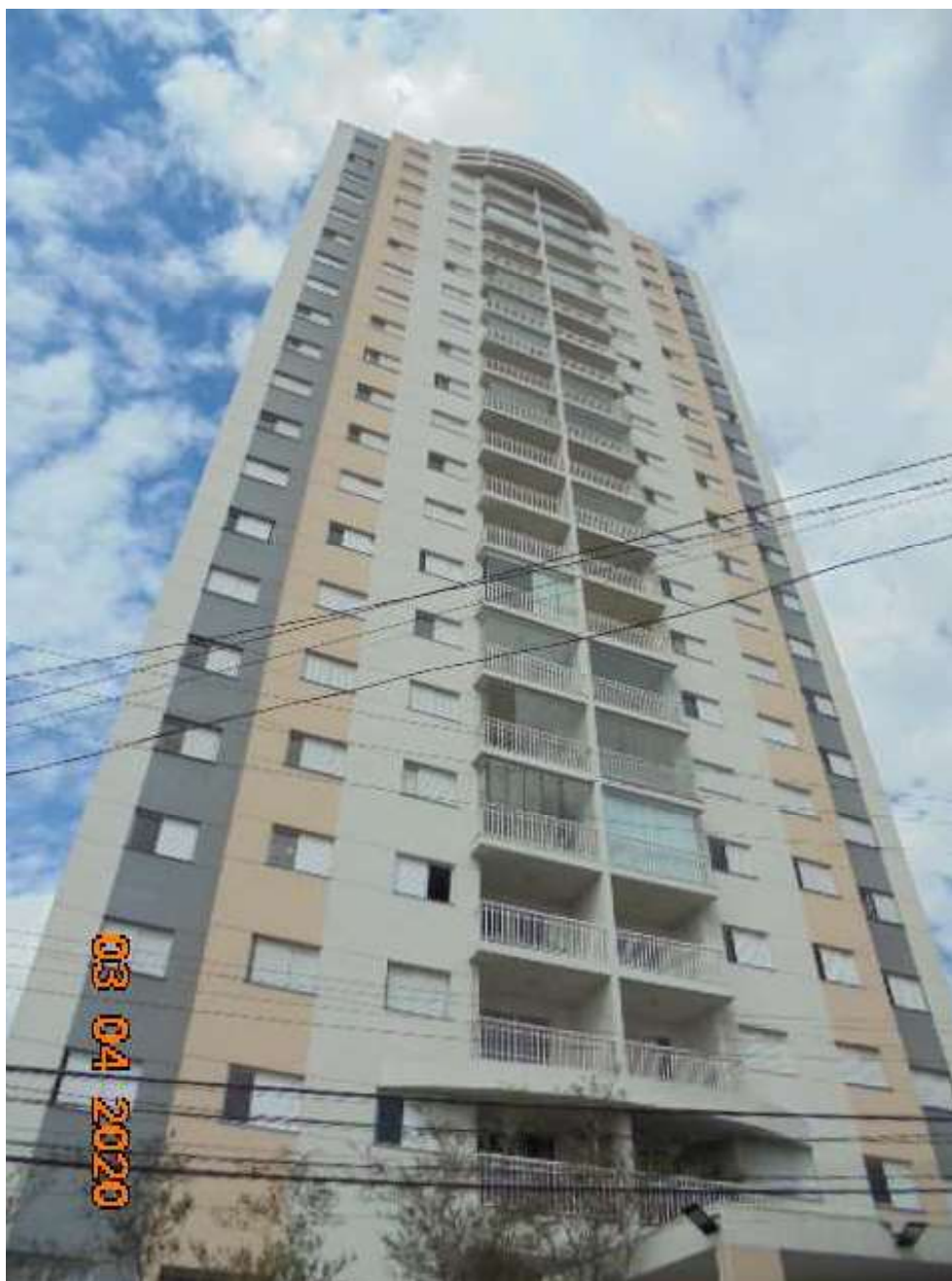
FOTO Nr.10: Detalhe externo dos acabamentos da fachada do Condomínio UP Alto do Jaguaré.
