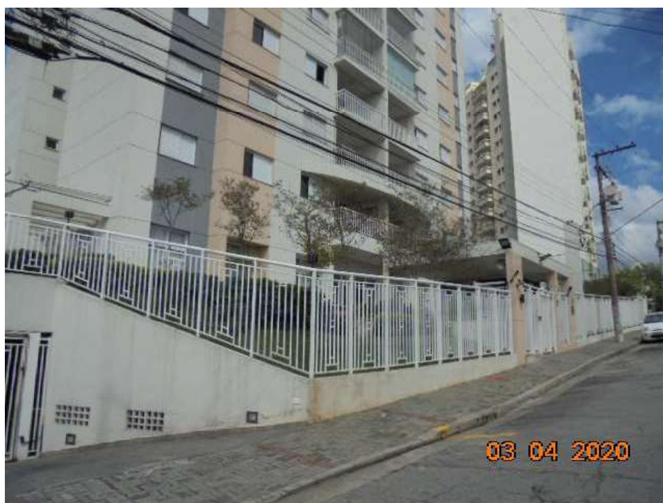
FOTO Nr.08: Panorama da frente do prédio e portaria de acesso.
