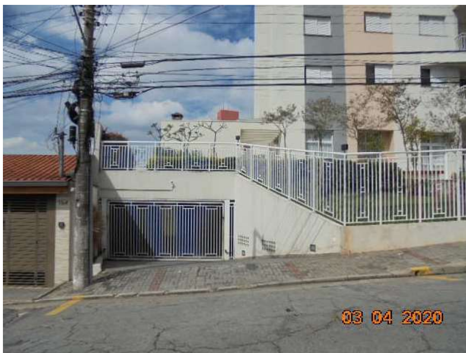
FOTO Nr.07: Detalhe do acesso de veículos aos dois sub-solos de estacionamento.
