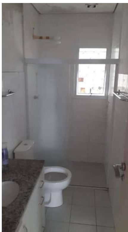
Foto 78 - Vista do banheiro social do imóvel registrado sob a Matrícula nº. 166.451.
