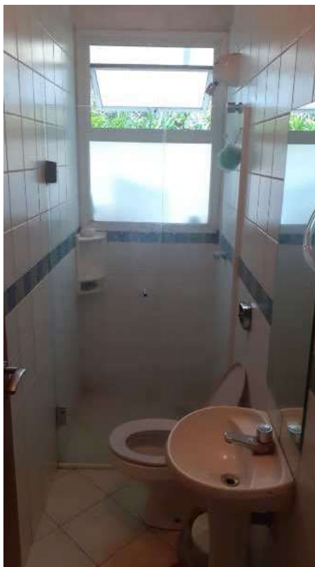
Foto 67 - Vista do banheiro social do imóvel registrado sob a Matrícula nº. 166.451.
