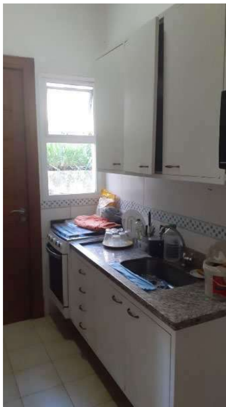
Foto 65 - Vista da cozinha do imóvel registrado sob a Matrícula nº. 166.451.
