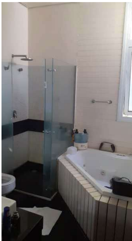
Foto 55 - Vista do banheiro do terceiro dormitório suíte do imóvel registrado sob a Matrícula nº. 179.320.
