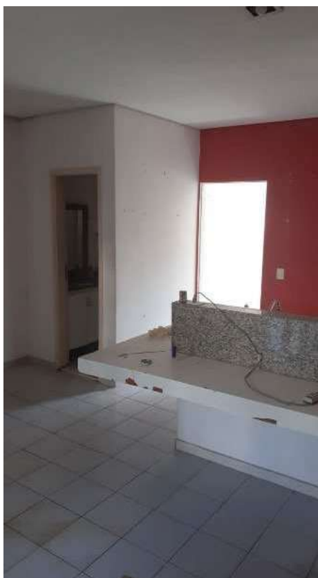
Foto 76 - Vista da sala do imóvel registrado sob a Matrícula nº. 166.451.
