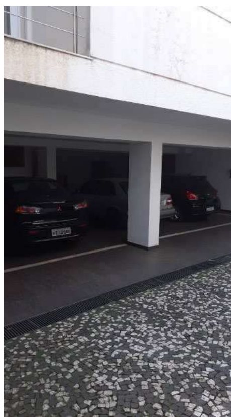
Foto 06 - Vista da garagem do imóvel registrado sob a Matrícula nº. 179.320.
