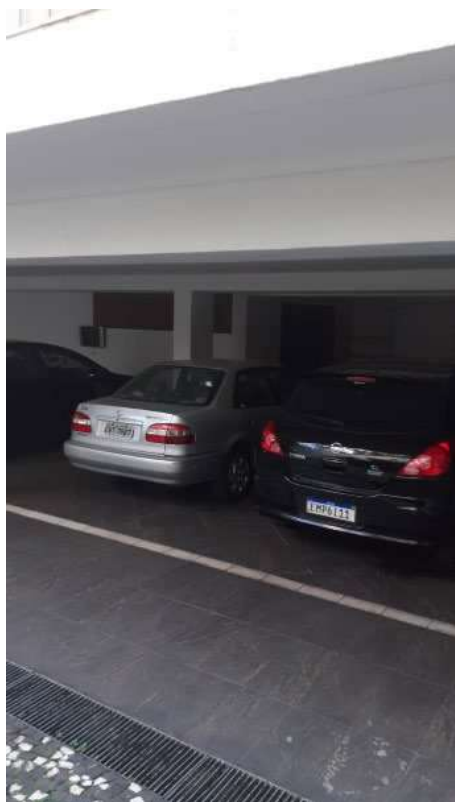
Foto 05 - Vista da garagem do imóvel registrado sob a Matrícula nº. 179.320.
