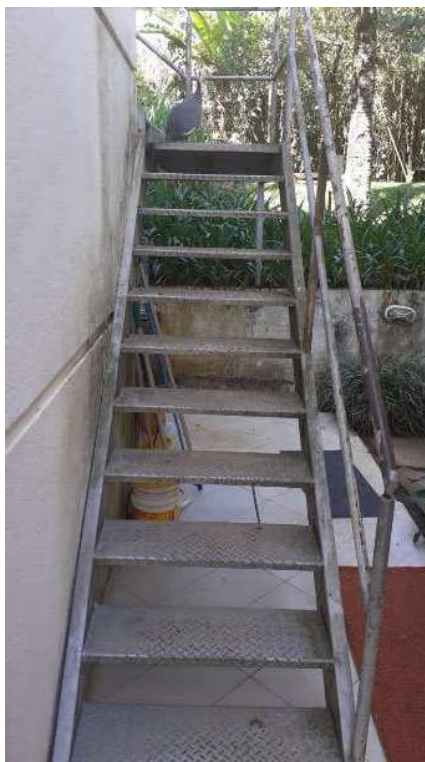
Foto 75 - Vista da escada de acesso ao segundo pavimento do imóvel registrado sob a Matrícula nº. 166.451.
