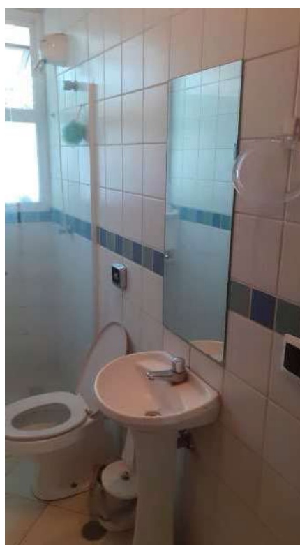
Foto 68 - Vista do banheiro social do imóvel registrado sob a Matrícula nº. 166.451.
