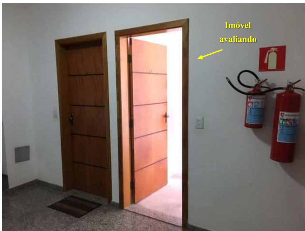
Figura 15- identificação da porta de entrada do imóvel avaliando
