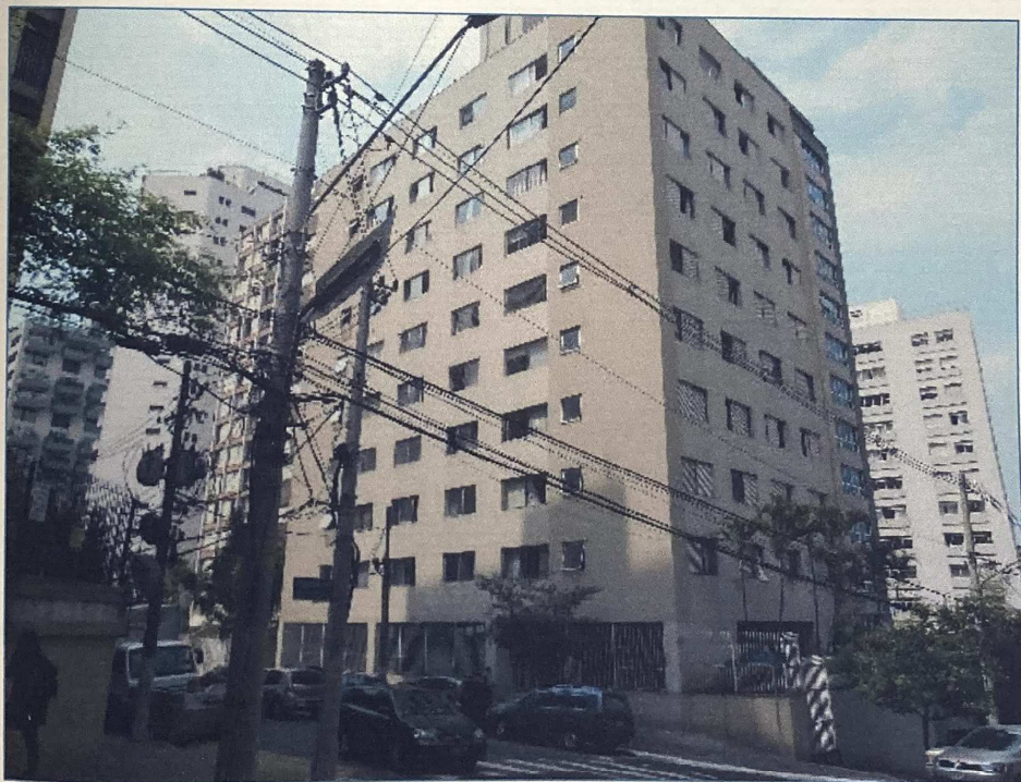
FACHADA DO EDIFÍCIO DONA ADÉLIA.
