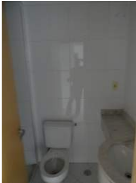
VISTA DO BANHEIRO FLAT Nº 1.611 (ATUAL Nº 1.607).
