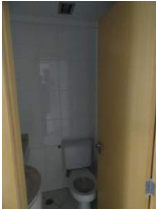
VISTA DO BANHEIRO FLAT Nº 1.712 (ATUAL Nº 1.706).
