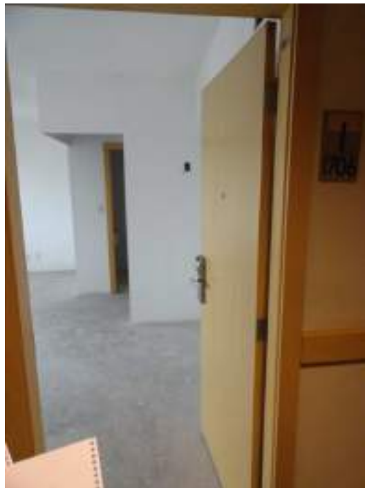
VISTA DA PORTA DO FLAT Nº 1.712 (ATUAL Nº 1.706).
