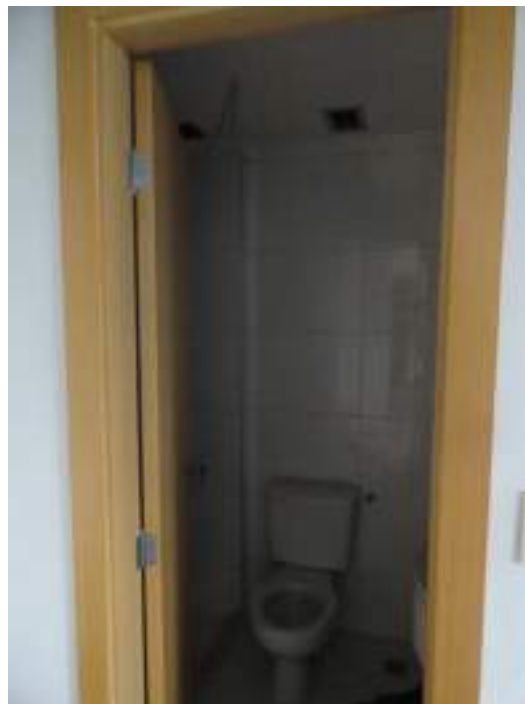
VISTA DO BANHEIRO DO FLAT N° 605 (ATUAL N° 601).
