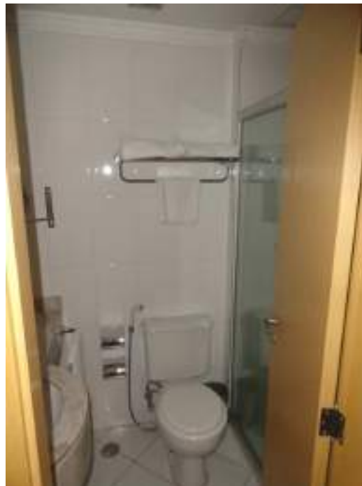
VISTA DO BANHEIRO FLAT N° 1.806 (ATUAL N° 1.812).
