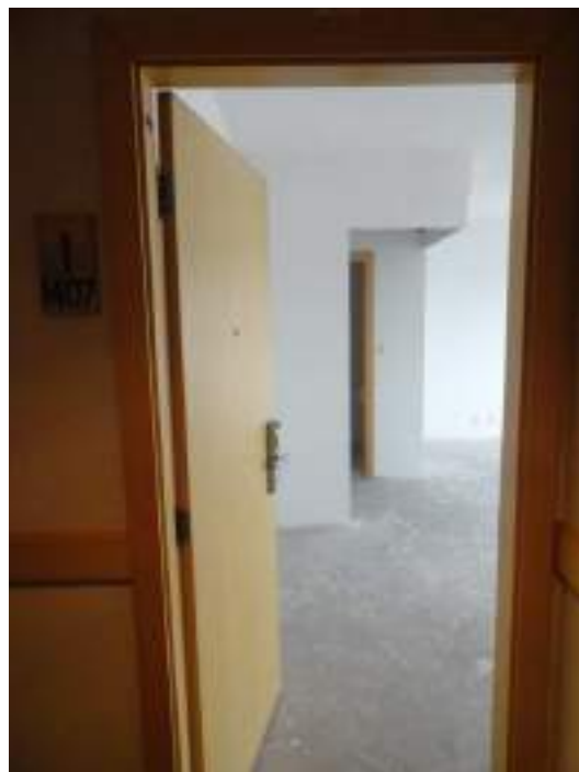
VISTA DA PORTA DO FLAT Nº 1.411 (ATUAL Nº 1.407).
