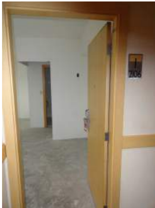
VISTA DA PORTA DO FLAT Nº 2.112 (ATUAL Nº 2.106).
