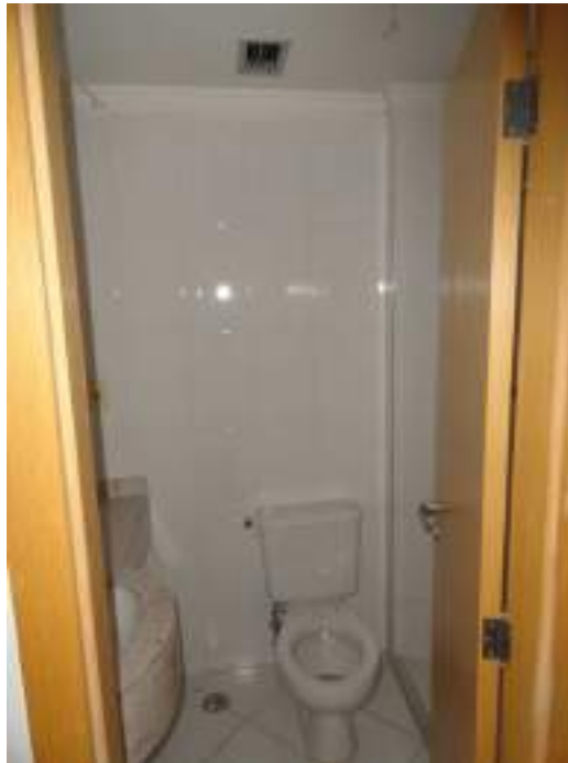
VISTA DO BANHEIRO FLAT Nº 2.112 (ATUAL Nº 2.106).
