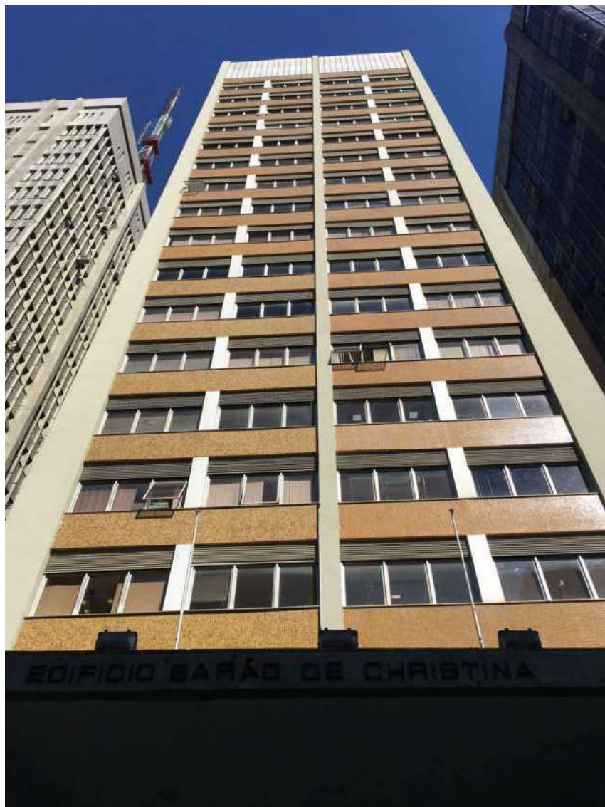
ASPECTOS GERAIS FACHADA DO EDIFÍCIO
