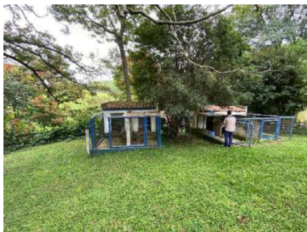
Foto N. 36 - 02 Canis (9,92m 2 +18,24m 2 ) contendo 28,16m 2 construído a aproximadamente 15 anos , enguida sobre alvenaria de tijolos de barro, cercados por telas metálicas e cobertura com estrutura de madeira e telhas cerâmicas da época - Padrão Construtivo é considerado – COBERTURA RÚSTICA – O seu estado de conservação é considerado - “F” – Necessitando de Reparos de Simples a Importantes – Depreciação de 33,20%.
