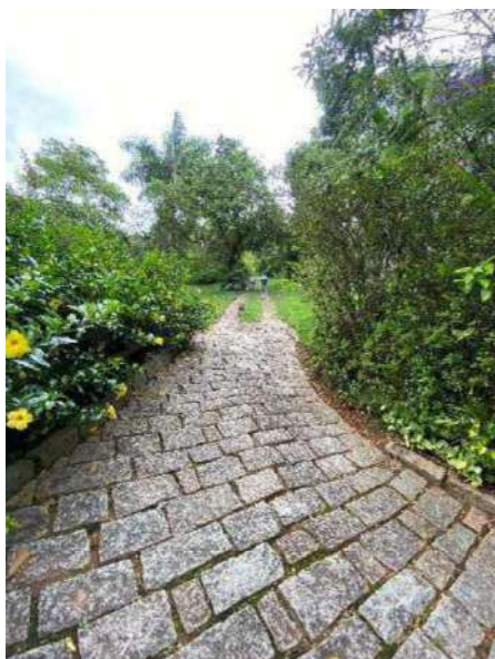
Fotos N. 70, 71 e 72 - 2.500,00m 2 de Pavimentação por Calçamento do Tipo Folheta de Pedra Natural (Tipo de Paralelepípedo maior).
