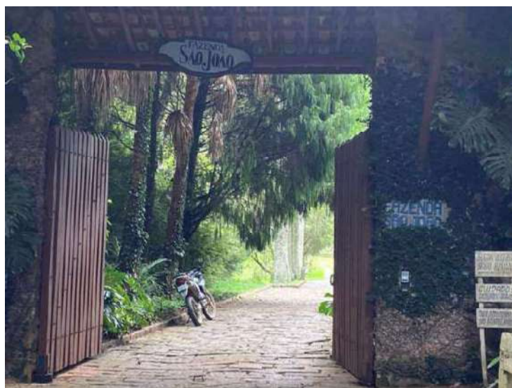
Fotos N. 04, 05, 06 e 07 – Nesta Local – KM- 116 +50,0m está situada a entrada da Fazenda São João tendo acesso direto pela Rodovia por estrada pavimentada por Calçamento do Tipo Folheta de Pedra Natural (Paralelepido maior) .
