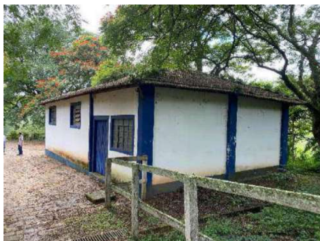
Foto N. 36 - 02 Canis (9,92m 2 +18,24m 2 ) contendo 28,16m 2 construído a aproximadamente 15 anos , enguida sobre alvenaria de tijolos de barro, cercados por telas metálicas e cobertura com estrutura de madeira e telhas cerâmicas da época - Padrão Construtivo é considerado – COBERTURA RÚSTICA – O seu estado de conservação é considerado - “F” – Necessitando de Reparos de Simples a Importantes – Depreciação de 33,20%.
