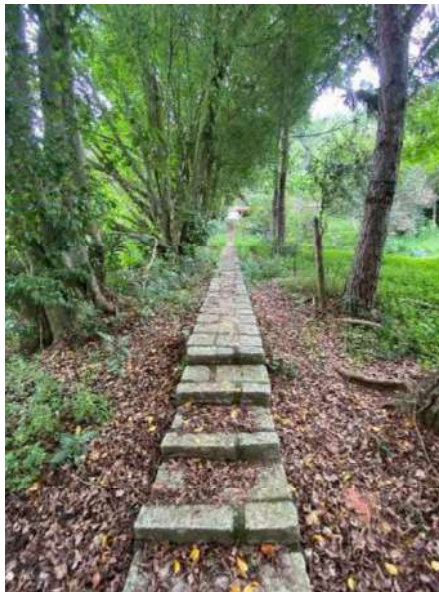
Fotos N. 70, 71 e 72 - 2.500,00m 2 de Pavimentação por Calçamento do Tipo Folheta de Pedra Natural (Tipo de Paralelepípedo maior).
