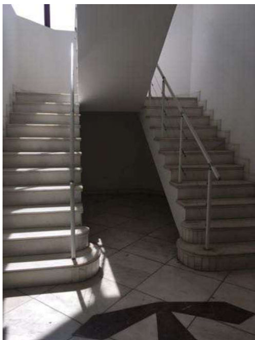
Foto 1: vista do hall de entrada do apartamento, para quem está postado defronte à porta do elevador que dá acesso ao 13º andar.
