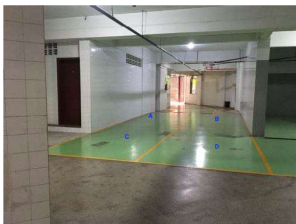
Foto 15: destacados pela signatária, com letras em azul A a D, quatro vagas para automóveis, localizadas no 2º subsolo do edifício.
