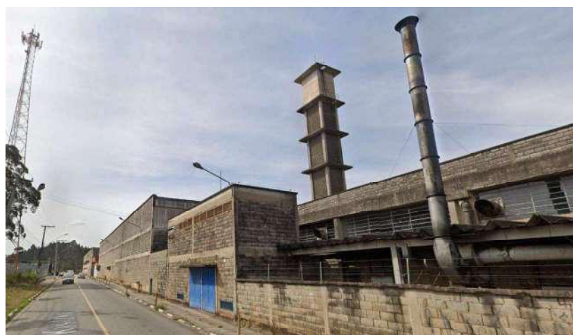
Foto 09 – Vista externa dos galpões
