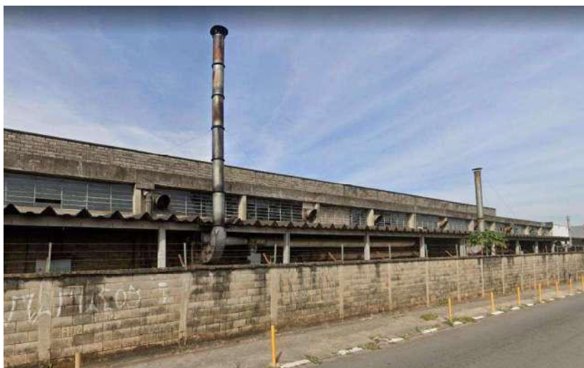
Foto 05 – Vista externa dos galpões
