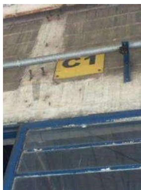
Foto 22 – Identificação do Galpão – C1
