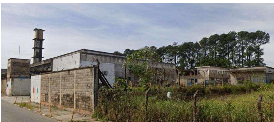
Foto 07 – Vista externa dos galpões
