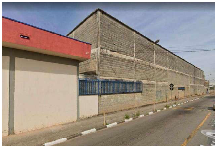
Foto 03 – Vista externa dos galpões
