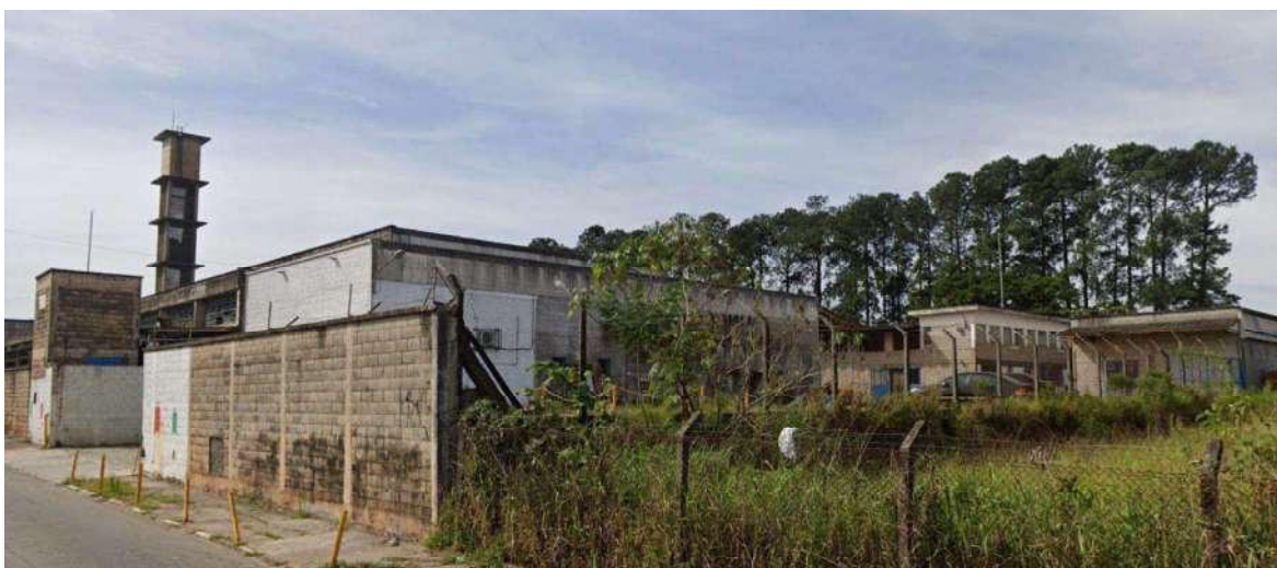
Foto 07 – Vista externa dos galpões
