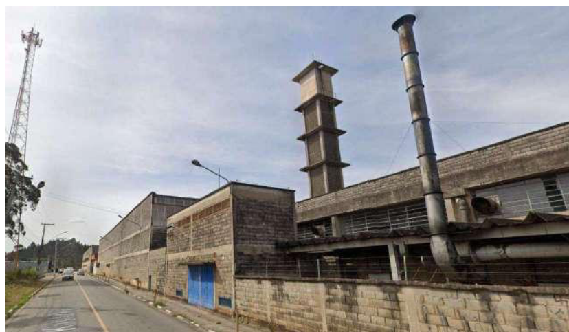
Foto 09 – Vista externa dos galpões
