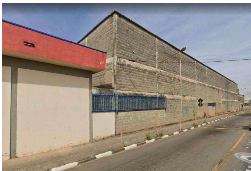
Foto 03 – Vista externa dos galpões
