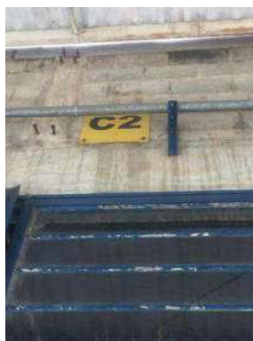
Foto 26 – Identificação do Galpão – C2
