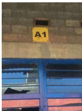
Foto 14 – Identificação do Galpão – A1
