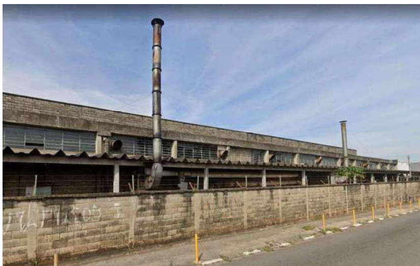
Foto 05 – Vista externa dos galpões
