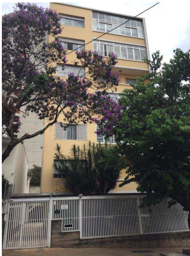
Foto 01 – Frente do imóvel avaliando, Rua Doutor Tomás Carvalho nº 981
