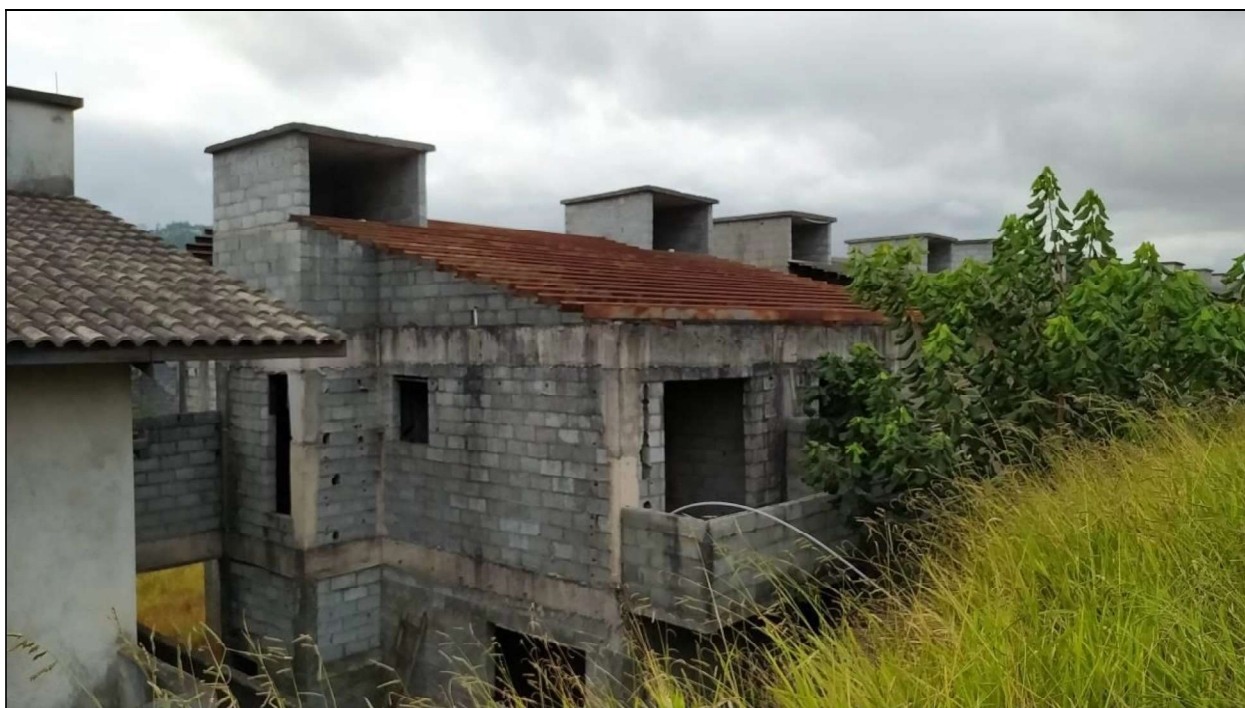
FOTO Nº 8 – OUTRA VISTA DA DIVISA LATERAL COM O RESIDENCIAL TOSCANA.
