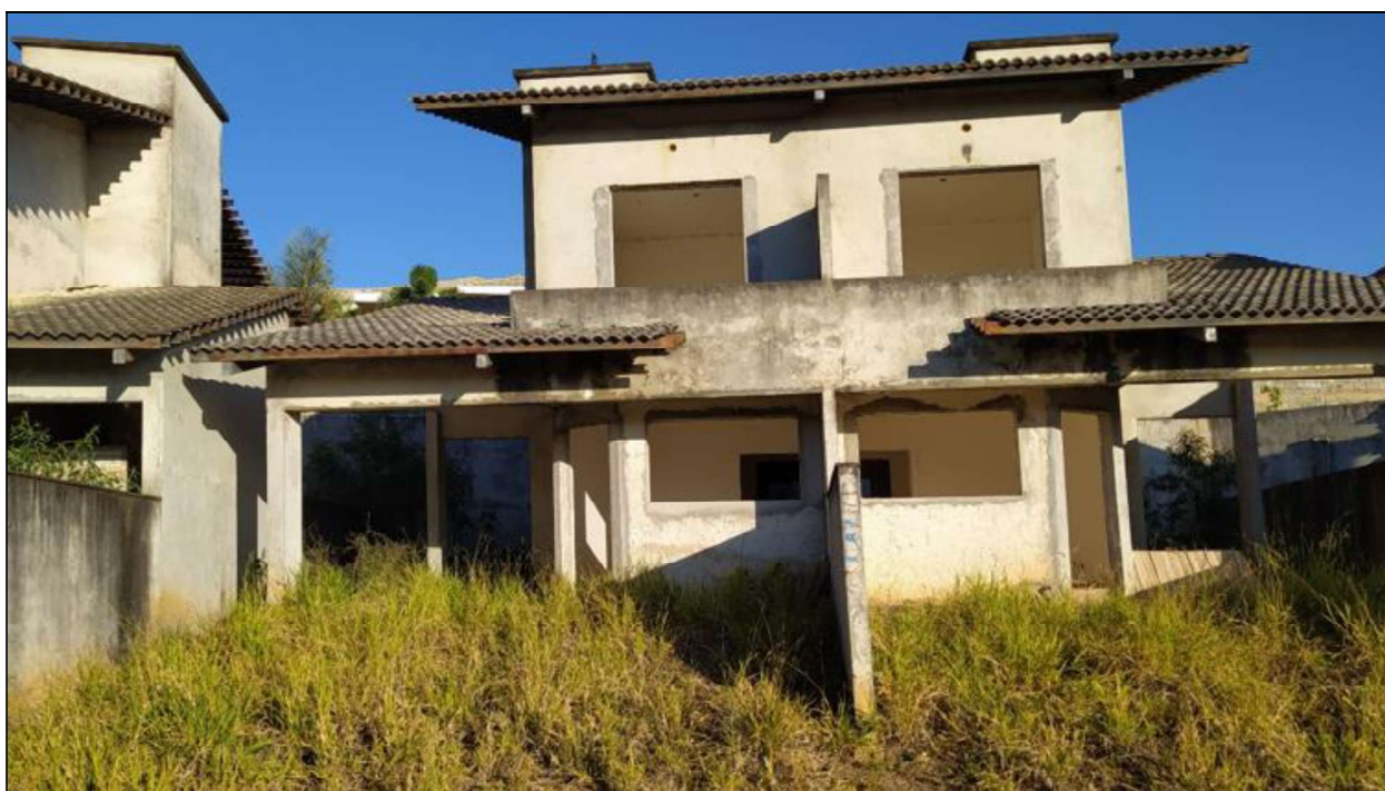
FOTO Nº34 – VISTA PARCIAL DE UMA UNIDADE COMPREENDIDA ENTRE AS DE NºS 70 E 101.
