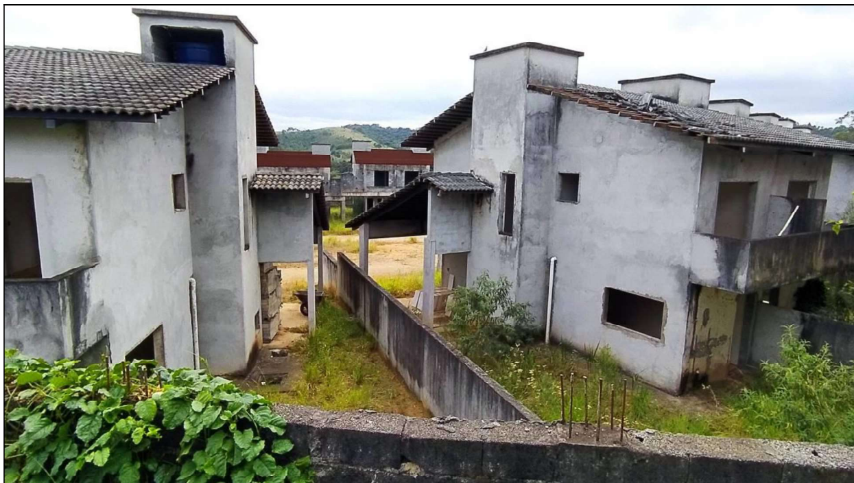
FOTO Nº 9 – VISTA PARCIAL DO EMPREENDIMENTO A PARTIR DO RESIDENCIAL TOSCANA.
