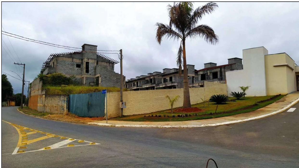
FOTO Nº1 – VISTA FRONTAL DO EMPREENDIMENTO QUINTAS DE MARIA III, LOCALIZADO NA ESTRADA MUNICIPAL ANTONIO RAMOS, ALTURA DO Nº 850 – BOM JESUS DOS PERDÕES/SP.
