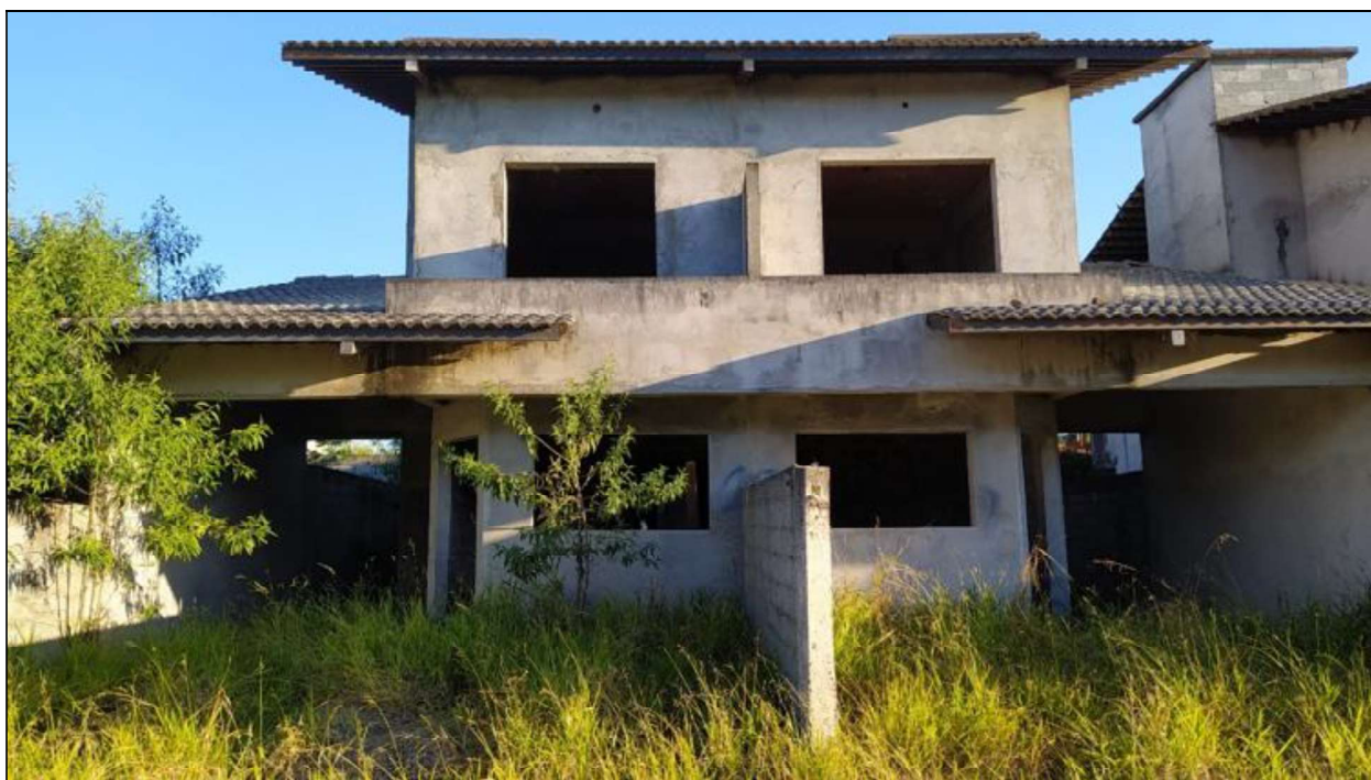
FOTO Nº40 – VISTA PARCIAL DE UMA UNIDADE COMPREENDIDA ENTRE AS DE NºS 103 E 136.
