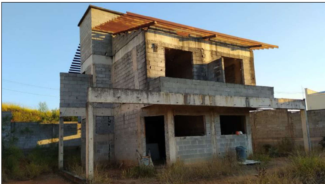
FOTO Nº46 – VISTA DAS UNIDADES HABITACIONAIS 135 (ESQUERDA) E 136 (DIREITA).
