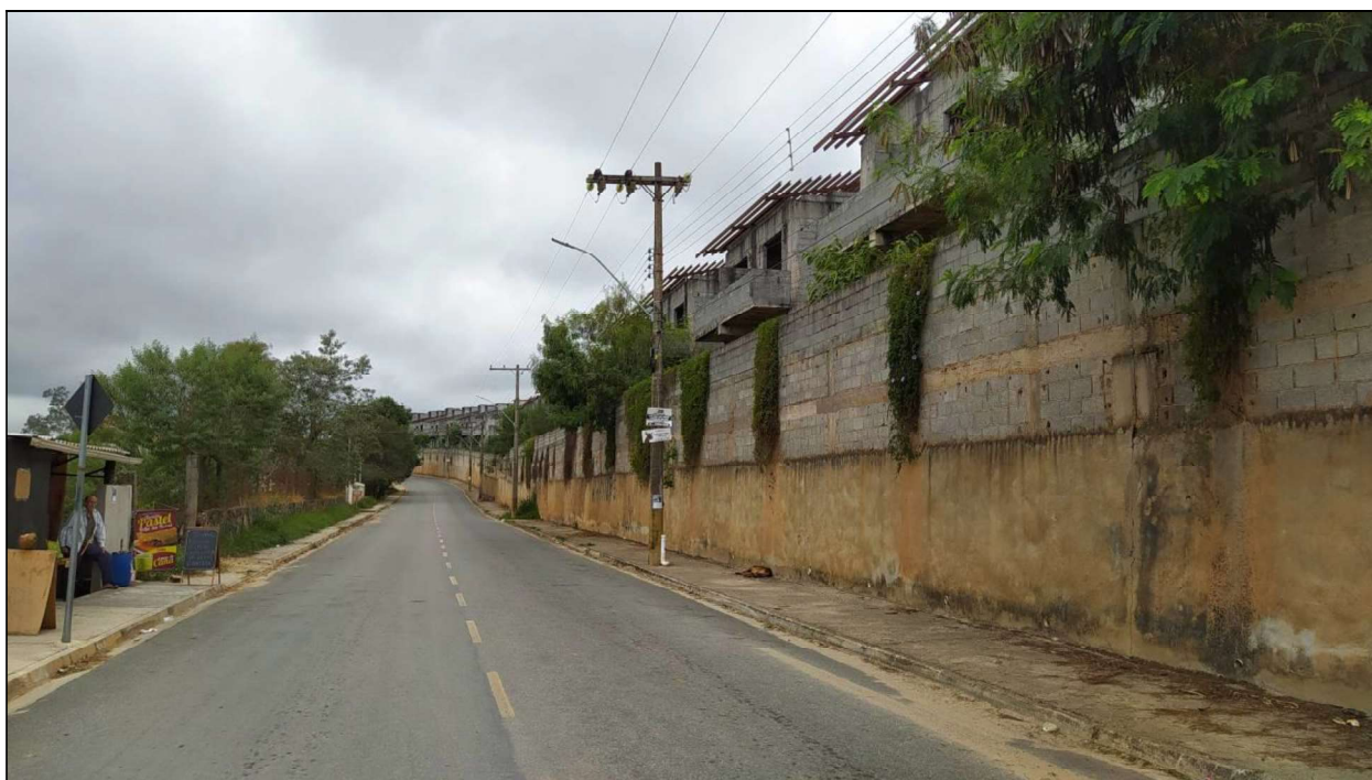
FOTO Nº4 – VISTA DA ESTRADA MUNICIPAL ANTONIO RAMOS COM O MURO DE DIVISA DO EMPREENDIMENTO À DIREITA.
