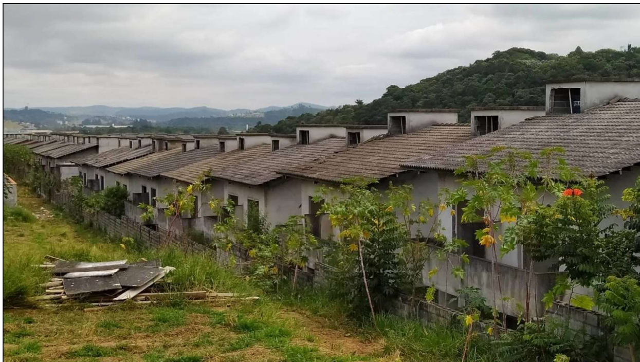
FOTO Nº 7 – VISTA DA DIVISA LATERAL COM O RESIDENCIAL TOSCANA.
