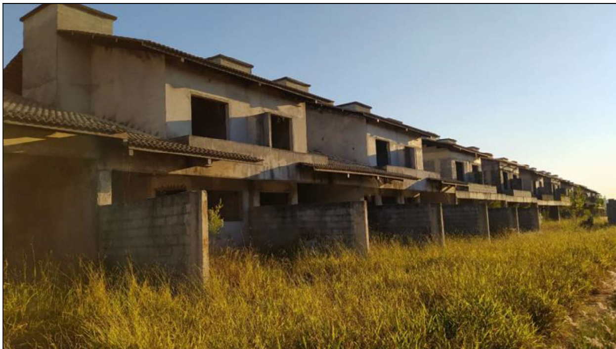
FOTO Nº39 – VISTA PARCIAL DO EMPREENDIMENTO ENTRE AS UNIDADES HABITACIONAIS NºS 103 E 136.
